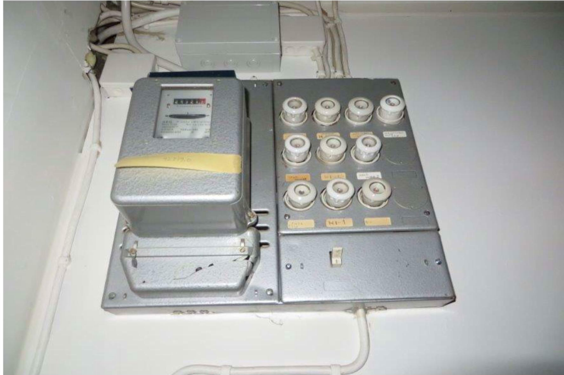
Kuva 5: Liiketilojen alkuperäiset ryhmäkeskukset ovat välttäväkuntoisia.
