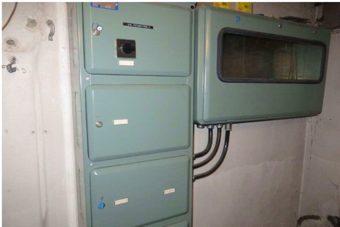
Kuva 2: Nousukeskuksena toimiva vanha pääkeskus on 1970-luvulta.
