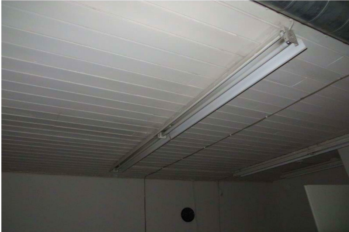
Kuva 7: Kiinteistöhuollon tyhjässä liiketilassa on ikääntyneitä T8-loisteputkivalaisimia.
