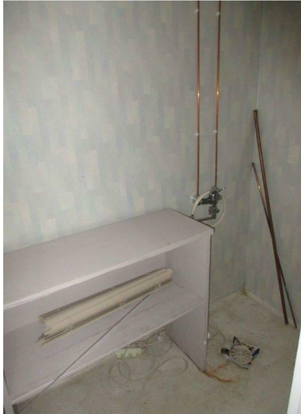
Kuva 7: Vanhojen märkätilojen pintarakenteet uusitaan vedeneristeineen.
