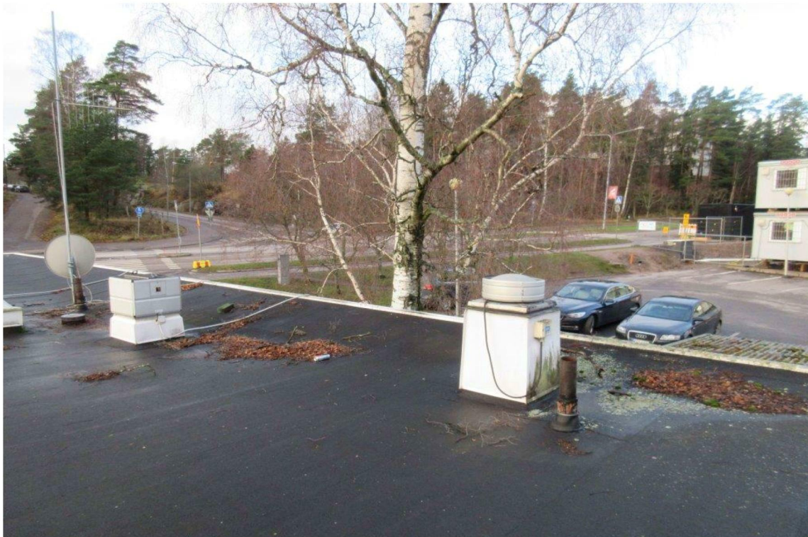
Kuva 4: Vesikatot tulee pitää puhtaana roskista säännöllisesti tehtävin huoltotöin.
