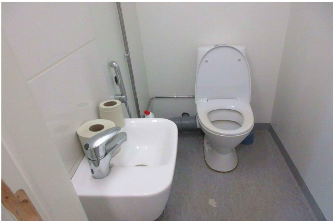
Kuva 4: Vuokralaisen toimesta uusittuja vesi- ja viemärikalusteita ja niiden kytkentävesijohtoja.
