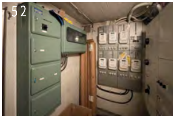
52 Kellarissa sijaitsevat rakennuksen tekniset tilat. Kuvasa sähköpääkeskus. Kuva syyskuulta 2023.
