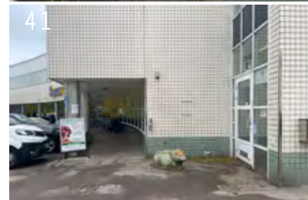
40 Julkisivussa on yhdistetty valkoista sekä mintunvihreää keraamista laattaa. Kuva marraskuulta 2023.
