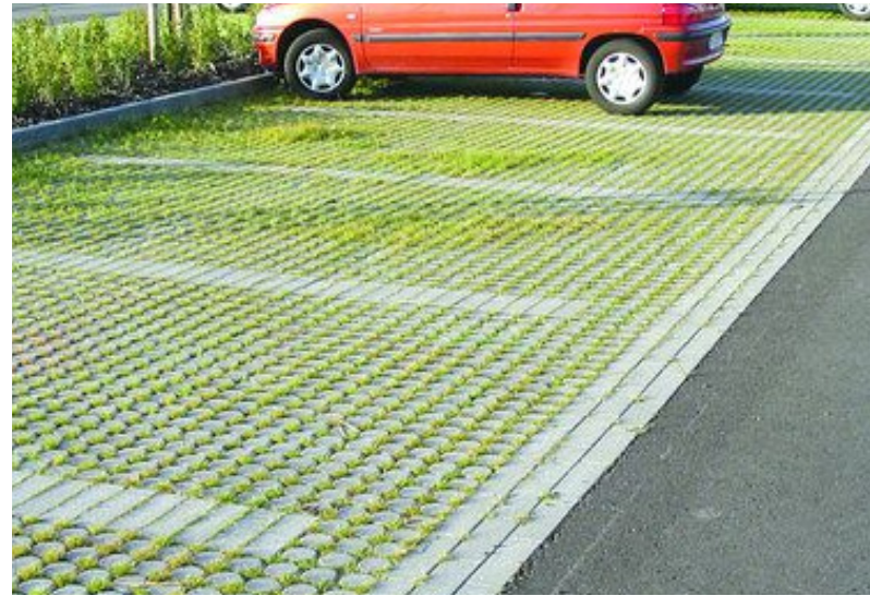
Avoimet pysäköintipaikat tehdään vettä läpäiseväksi nurmikivellä
