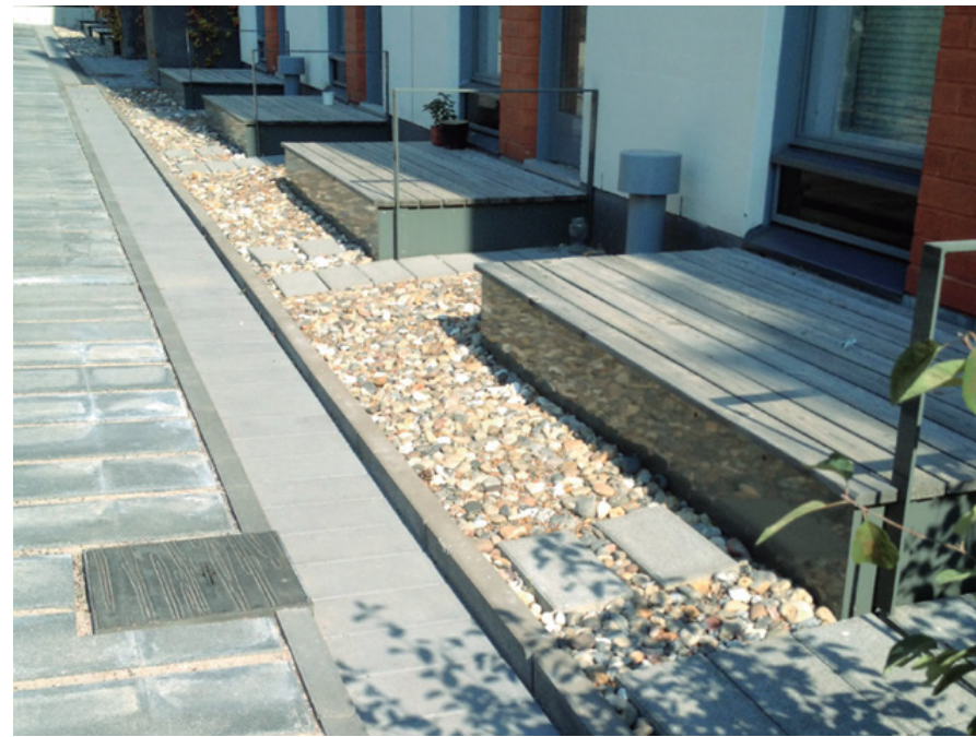
Hulevesien johdattaminen kulkuväylien reunoilla. Betoni-lehti. Maanlumo. Hiljentymisen piha, Yhteispiha 13, Arabianranta, Helsinki. Kuva Teresa Rönkä
