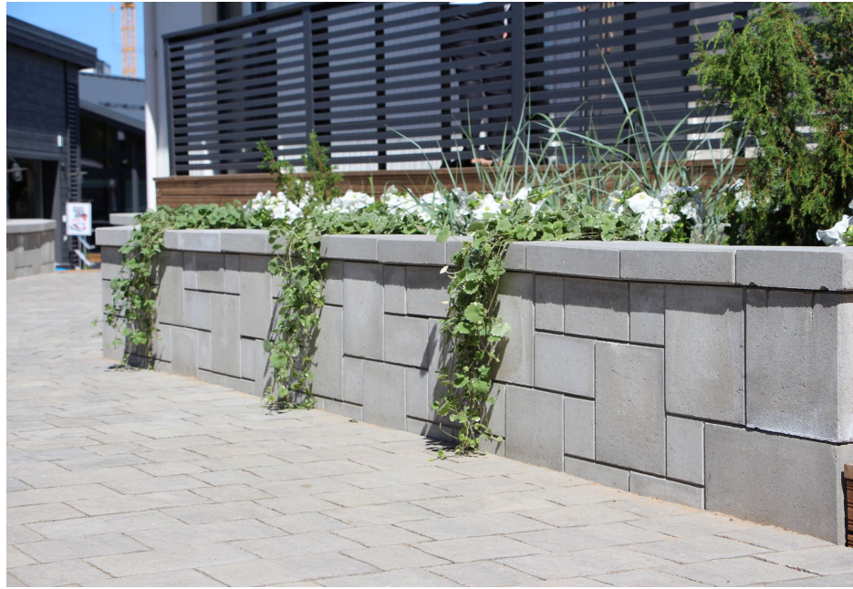
Tontin rajaaminen muurilla rajaa katutilaa selkeästi ja luo yksityisyyttä asunnoille ja asuntopihoille. Muurin materiaalina on tasapintainen muurikivi. Rakentaja.
