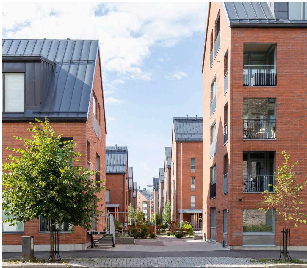
Esimerkki kohteesta, jossa päädyt luovat identiteettiä piha- ja katu ympäristöön. Kohteessa tiiviisti suunniteltu oleskelu- ja leikkipiha toimii kotona pienimittakaavaisena ympäristönä. (Kanttia2)
