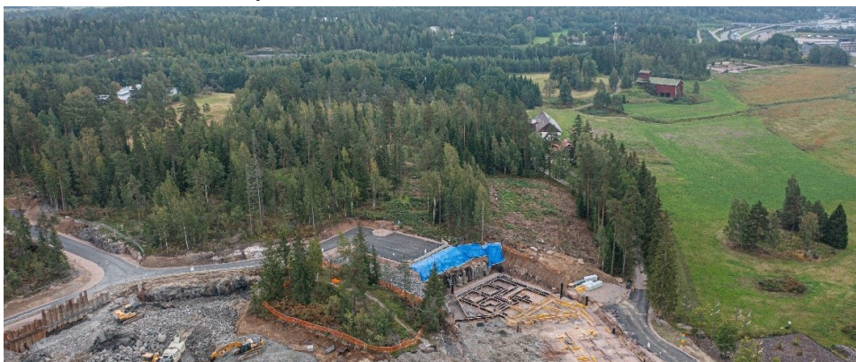
Viistoilmakuva luoteesta kohti Sepänkalliota, Gerkin tilan ympäristön kulttuurimaisemaa ja Kehä II:sta. Alalaidassa korttelin 26211 rakennustyömaa. © Patrick Eriksson 9/2023.
