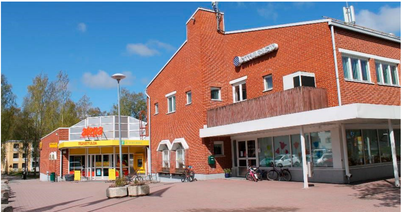
Rakennuksen punatiiliverhoilua elävöittävät valkoiset detaljit.
