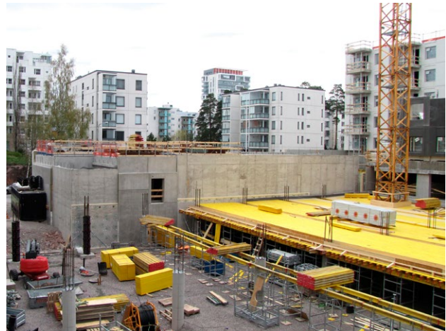
Ostoskeskuksen paikalle on rakenteilla kerrostaloja.
