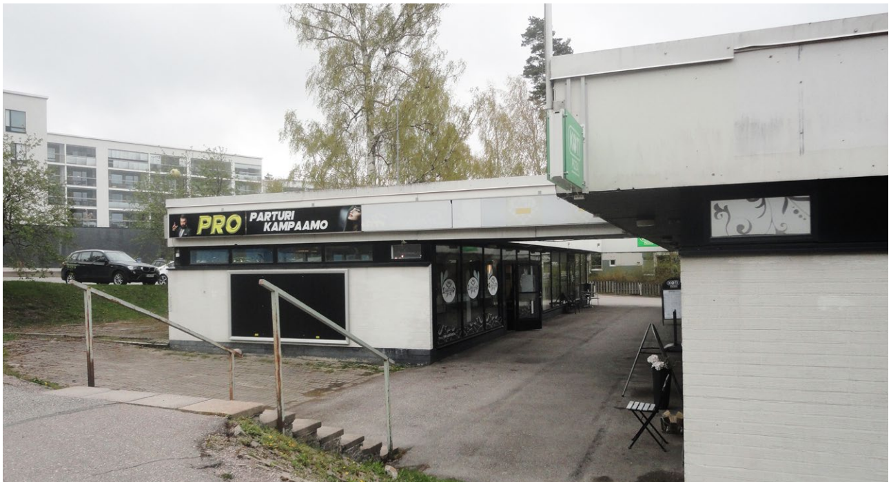
Ostoskeskuksen läpi kulkee katettu ulkokäytävä.
