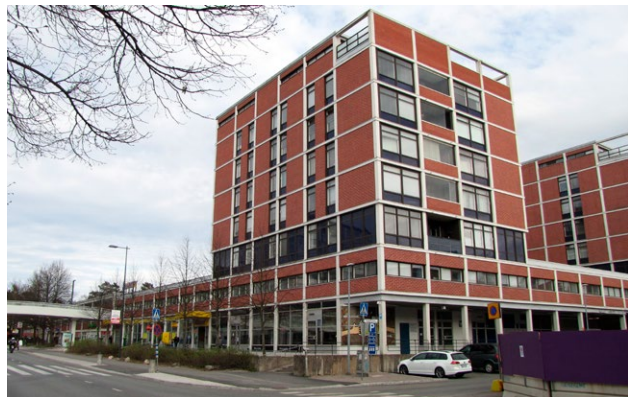
Ostoskeskus asuntotorneineen ja Kuunkadun ylittävä kävely- ja pyöräily silta, Maapallonkuja 2
