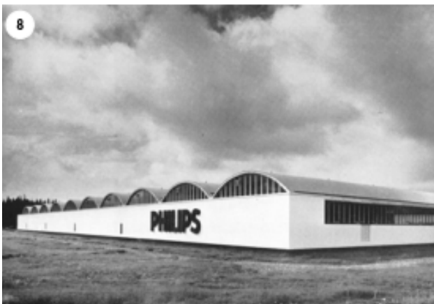
Philipsin tehasrakennus pian valmistumisensa jälkeen 1960-luvun alussa. (Arkkitehti 7-8/1964)
