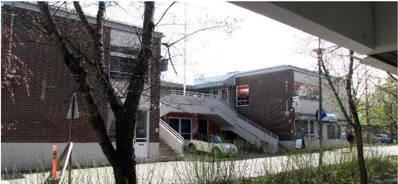
Ostoskeskuksen erityispiirteenä on sen keskellä sijaitseva ulkoportaikko.
