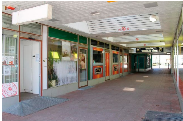
Katetulle käytävälle valoa antavat kattoikkunat.
