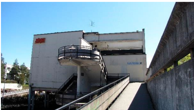
Ala-Soukan ostoskeskuksen julkisivuja hallitsee betoninen pilari-palkkirakenne.
