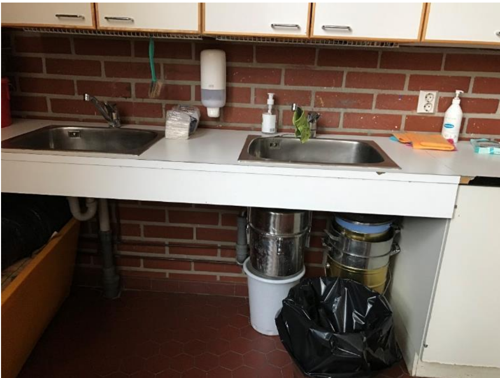
Kuva 5.5. Usea allashana ei ole kunnolla kiinnitetty pöytään.
