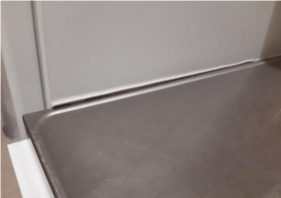
Kuva 4.4. Keittiön 14 tiskipöydän silikonisauma ei ole tiivis.
