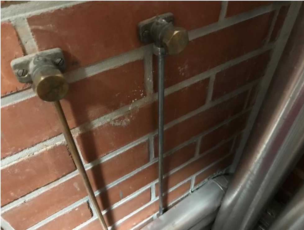
Kuva 5.4. Lämmönjakohuoneen pesuallas on poistettu ja putket tulpattu.
