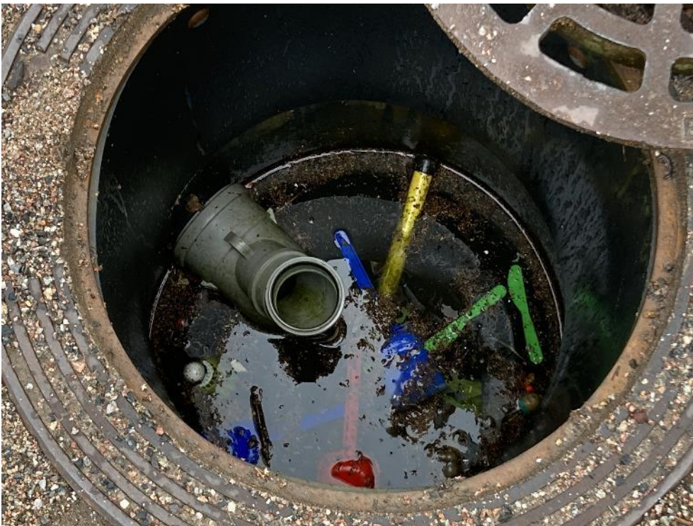
Kuva 5.9. Sadevesikaivoissa on sinne kuulumatonta tavaraa.
