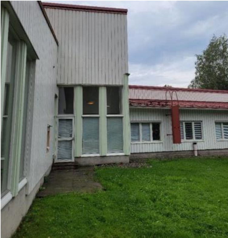
Kuva 4.25. Tilan 137 ulkopuolella on jatkuva kosteusrasitus sokkelin vieressä kasvavasta nurmikosta.
