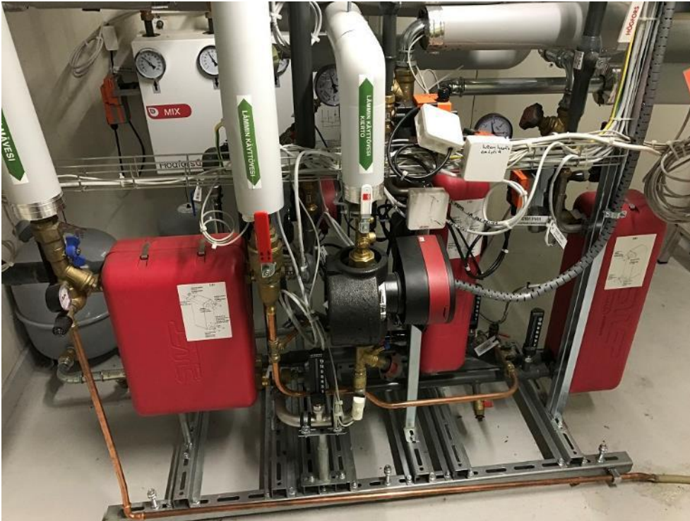
Kuva 6.3. Uusittu lämmönvaihdinpaketti.
