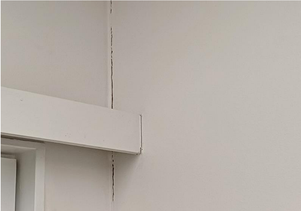
Kuva 4.1. Rakenneliittymien ratkeamia.
