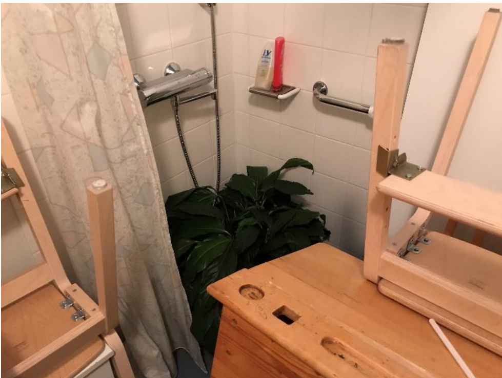
Kuva 5.2. Henkilökunnan pukutilojen suihkussa tavaraa eikä lattiakaivoa pääse täyttämään.
