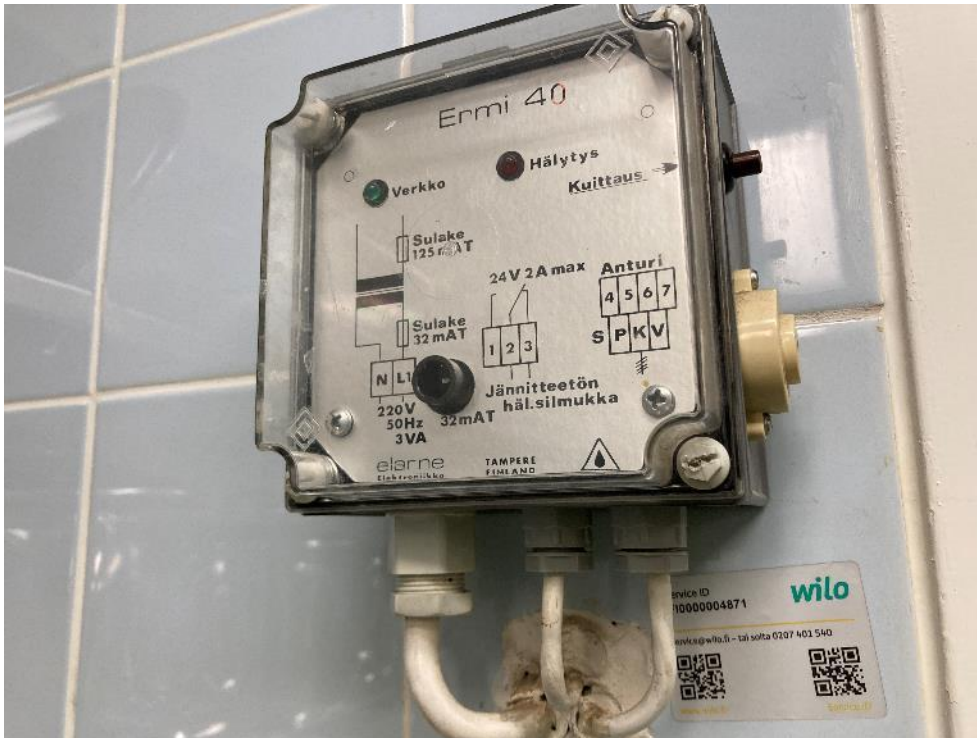
Kuva 5.7. Rasvanerotuskaivon hälytyskeskus kytketty pois päältä.
