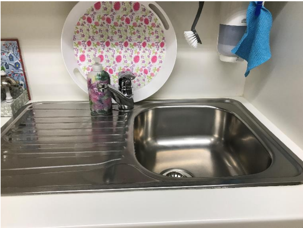
Kuva 5.4. Pesualtaan hanasta puuttuu sivuliikerajoitin.
