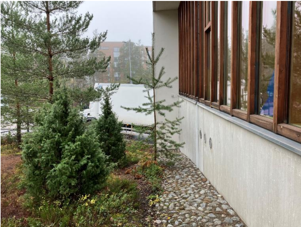
Kuva 4.15. Eteläpäädyssä puu kasvaa liian lähellä sokkeliä.
