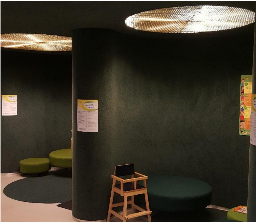
Kuva 4.41. Seinä- ja kattopintoja on verhoiltu tekstiilimatoilla. Kuva 1.kerroksen Odotustilasta 25.10.2018.
