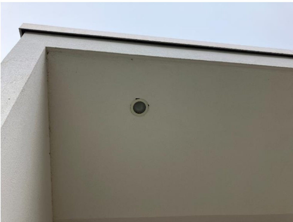
Kuva 4.3. B-sisäänkäynnin lampun upotus on väljä ja lampun sisällä on hyönteisiä.
