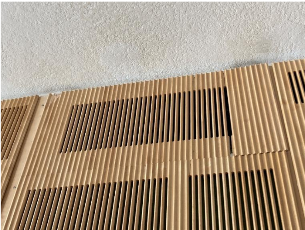
Kuva 5.3. Ilmanvaihdon puinen design-tuloilmasäleikkö on halki tilassa 216.
