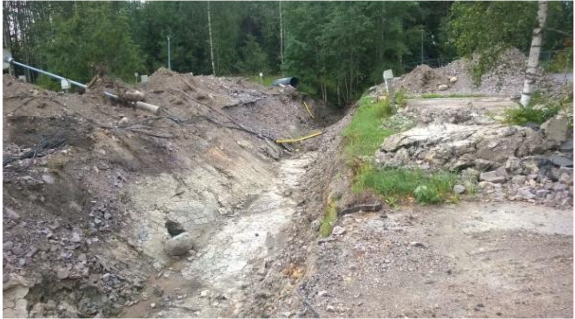
Kuva 6: Kuva G-rakennuksen pihalta putkirummun ja öljyisten maiden poiston jälkeen. Kuva raportista Pilaantuneen maaperän kunnostus, Siikajärventie 88–90, Espoo, 18.1.2016, Ramboll Finland Oy.
