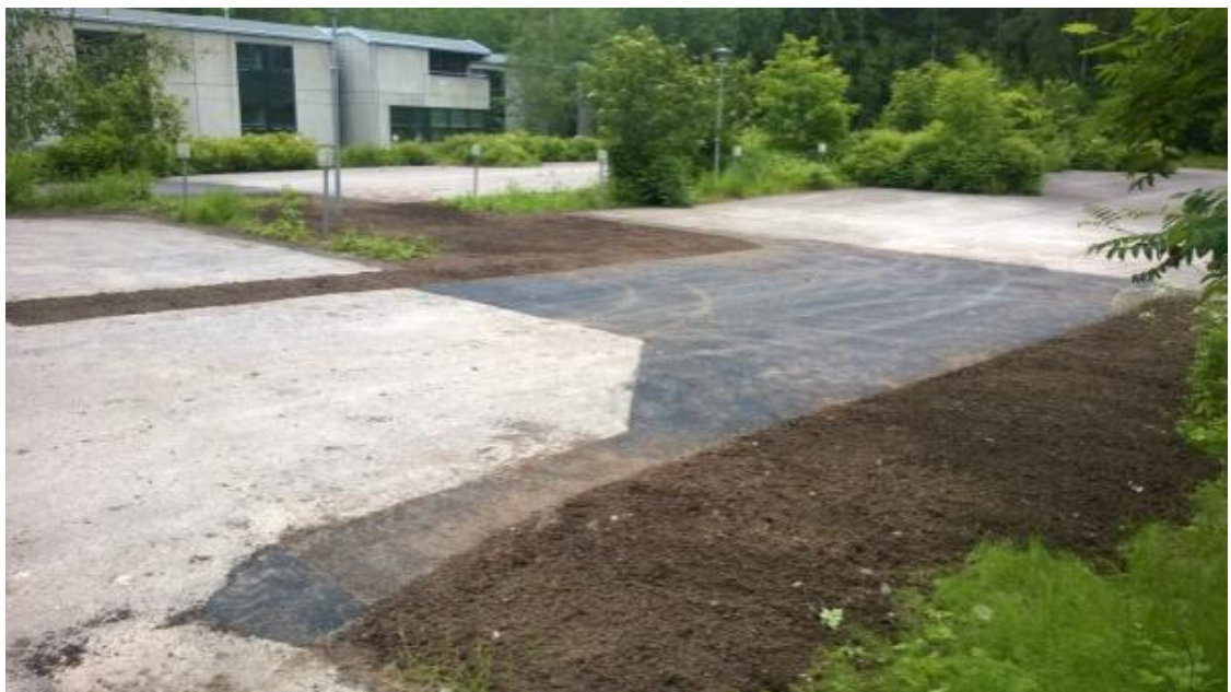
Kuva 7: G-rakennuksen paikoitusalue ennallistettu (asennettu uusi rumpu ja asfaltit paikattu). Kuva raportista Pilaantuneen maaperän kunnostus, Siikajärventie 88–90, Espoo, 18.1.2016, Ramboll Finland Oy.
