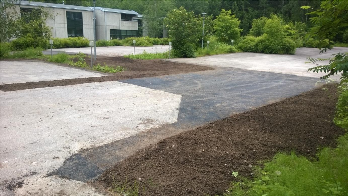
Kuva 9. Siikajärventien itäpuolen paikoitusalue on ennallistettu (asennettu uusi rumpu ja asfaltit paikattu).
