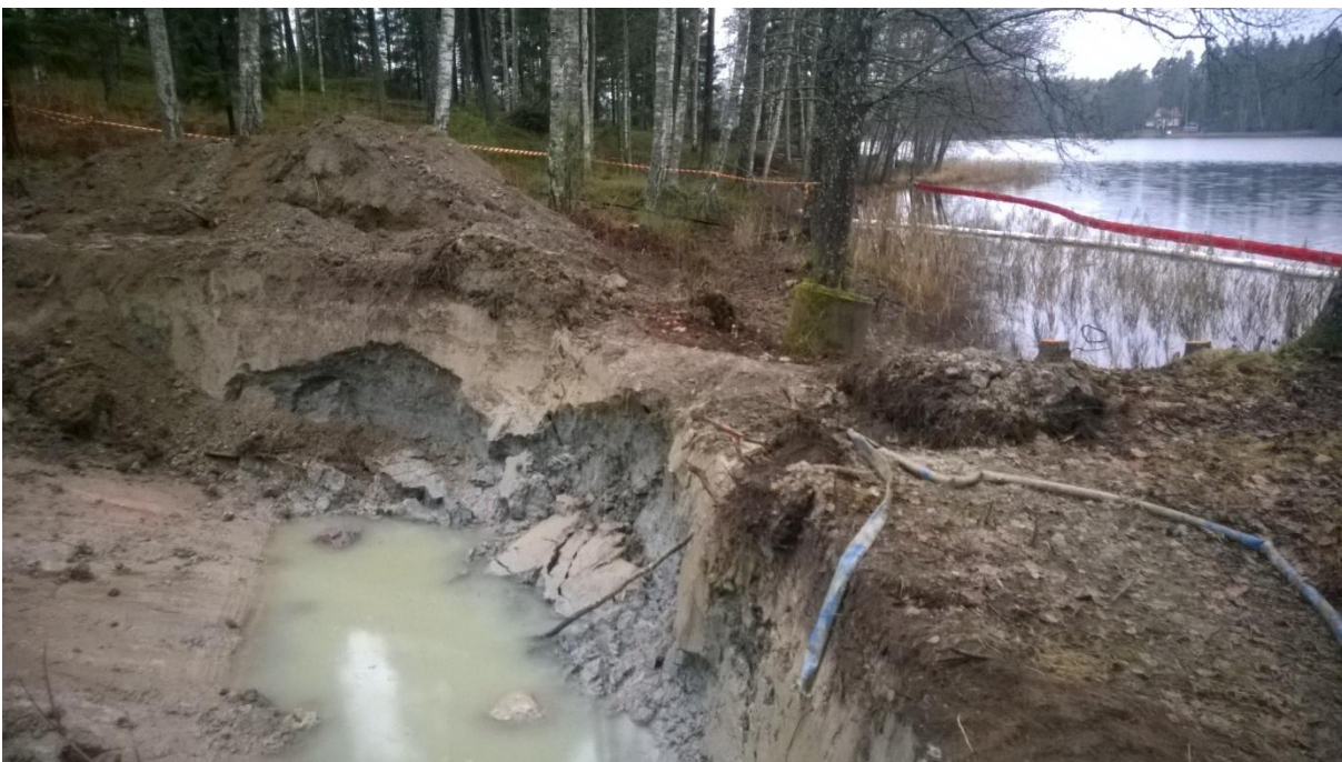
Kuva 6. Viimeinen kannas vielä kaivamatta. Järven rannassa näkyy sammaloitunut kaivonrengas, jonka sisälle putkilinjat johtivat.
