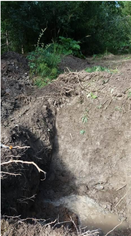
Valokuva 7. Näyte VAH9 otettiin esiin kaivetun betoniputken alapuolisesta maasta.
