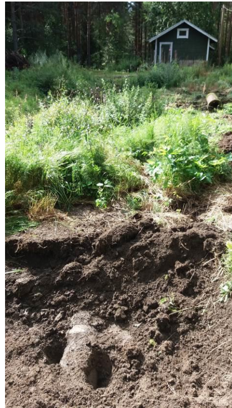
Valokuva 8. Esiin kaivettu betoniputki (näyte VAH10).
