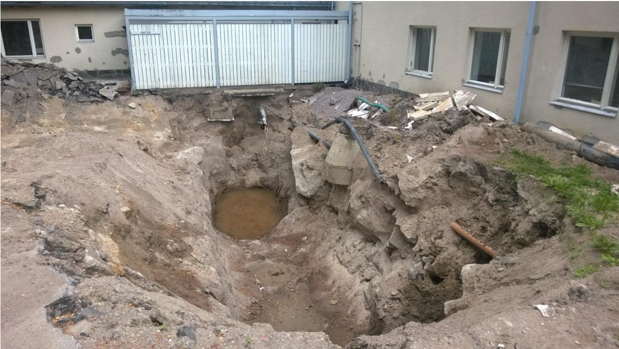
Kuva 1. Vuotanut öljysäiliö on poistettu kaivannosta rakennuksen eteläpuolelta.
