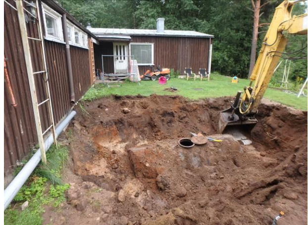
Valokuva 2. Käytöstä poistetun öljysäiliön päällisten maiden kaivua.
