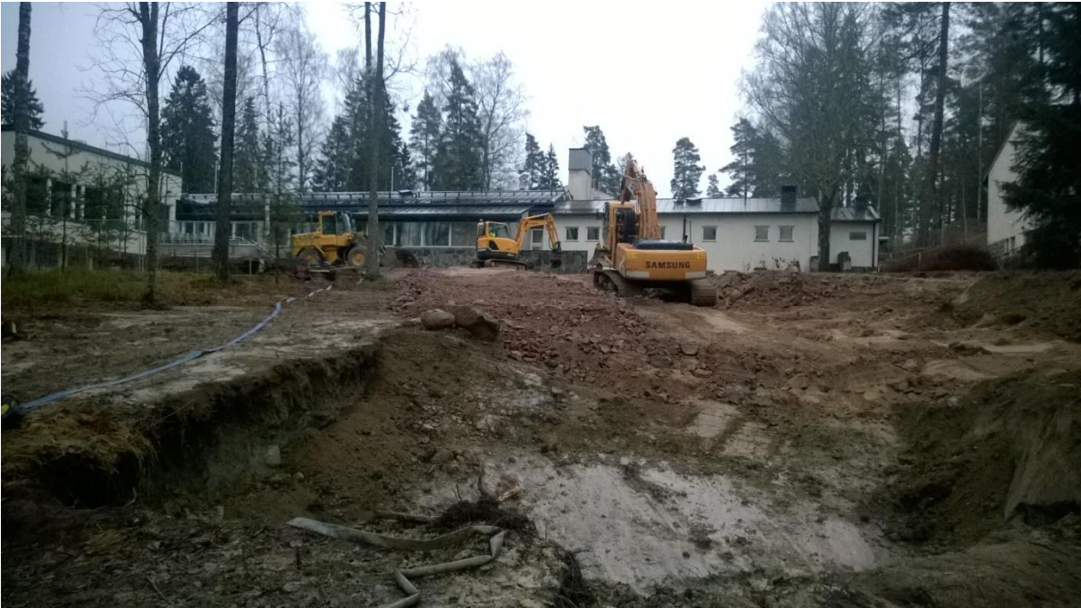
Kuva 7. Kaivannon täyttöä louheella. Kaivannon pohjalla kallio.
