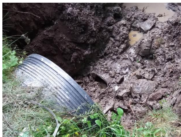
Valokuva 6. Vanha betoniputki alkaa 2014 kunnostuksessa uusitun ojarummun edustalta.
