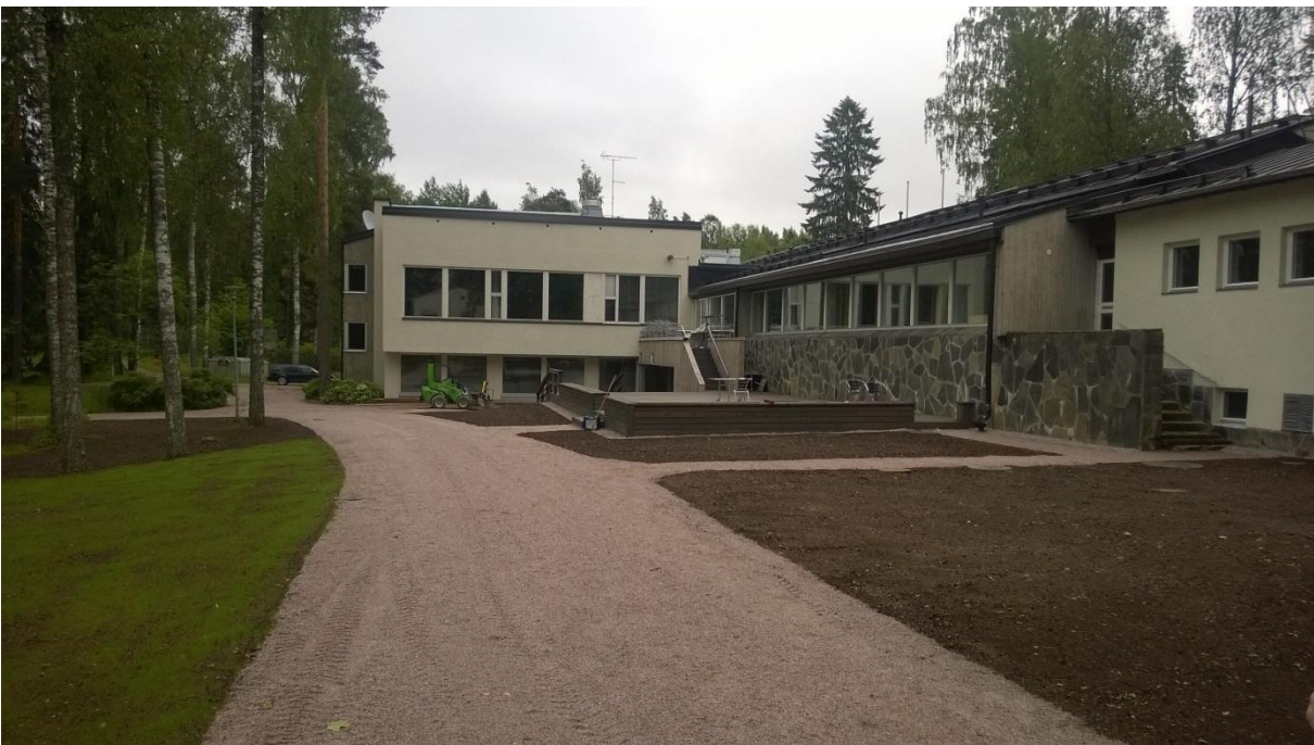
Kuva 10. Rakennuksen pohjoispuoli ennallistettu.
