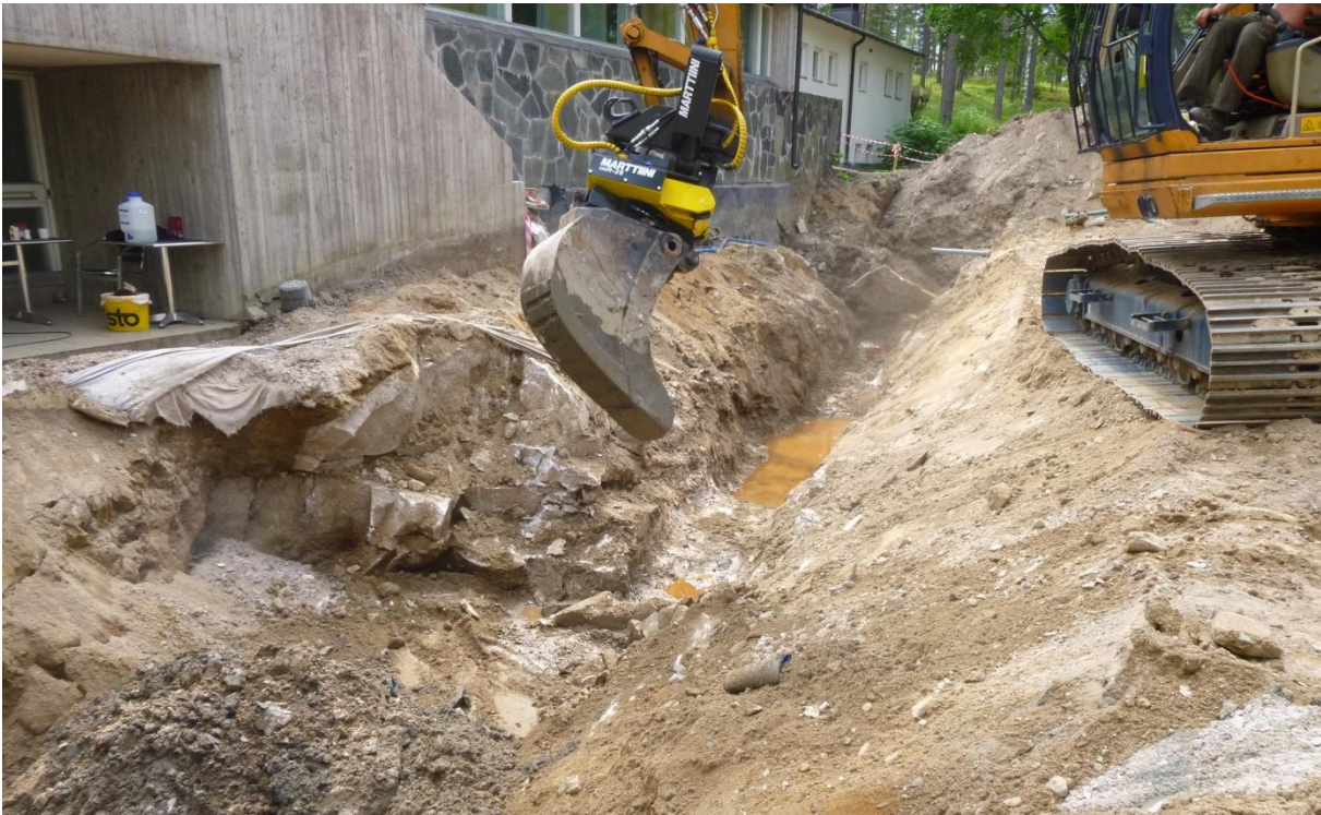
Kuva 3. Öljyisen maa-aineksen poistoa rakennuksen pohjoispuolelle aikaisemmin louhitusta putkikanaalista.
