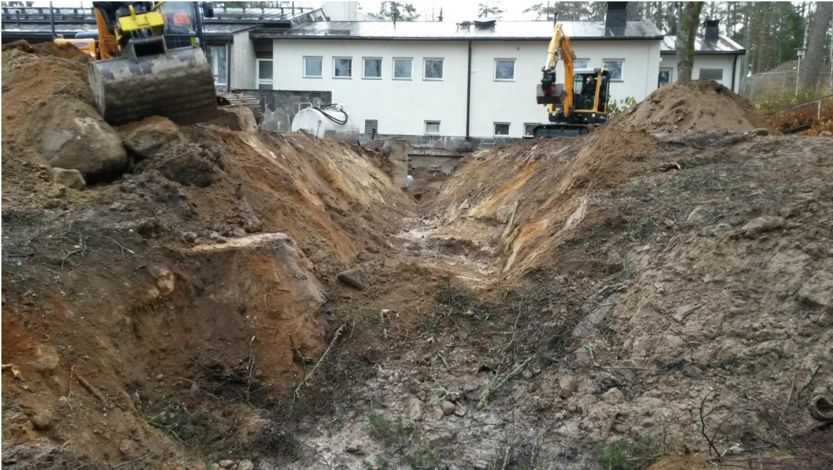
Kuva 5. Pilaantuneen maan poistoa Siikajärven rannasta rakennukselle ulottuvasta kaivannosta.
