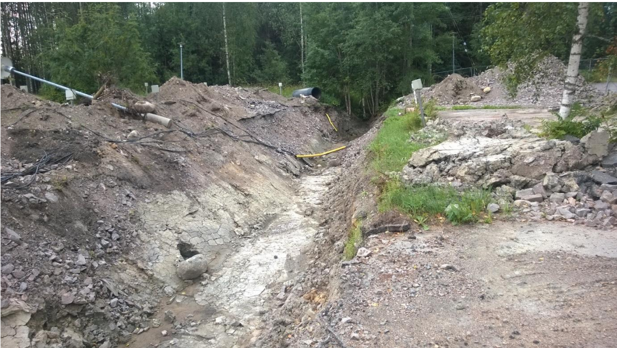
Kuva 2. Öljyiset maa-ainekset poistettiin Siikajärventien itäpuolella sijaitsevan paikoitusalueen rummun alta.
