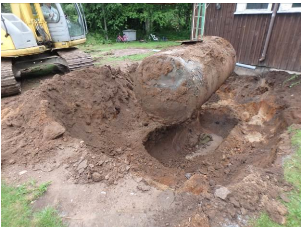
Valokuva 3. Öljysäiliö nostettiin tyhjänä ylös.
