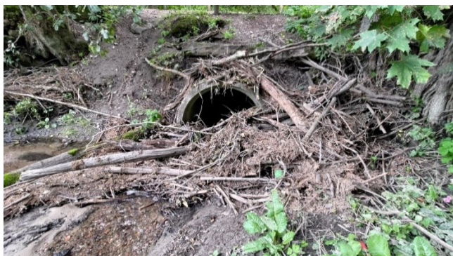
Kuva 3. Purojakso 3 alkaa siltarummun jälkeen. Rummun yläpäähän on kertynyt melko paljon puuainesta.
