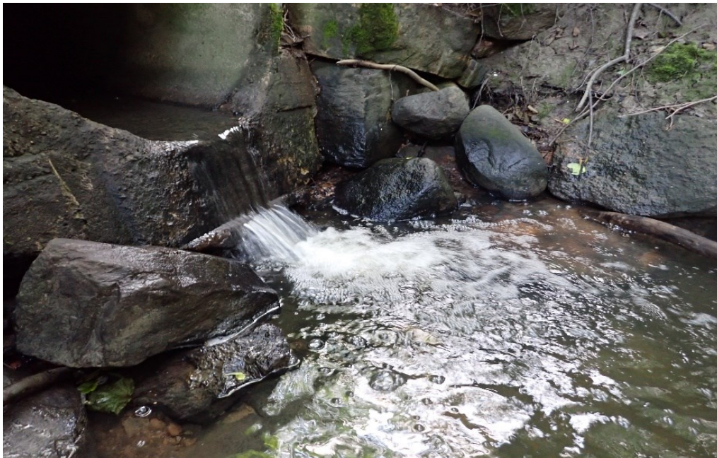
Kuva 7. Kolmas nousueste muodostuu myös siltarummusta, mutta putkessa on hieman vettä ja sen edessä vapaata vesitilaa.
