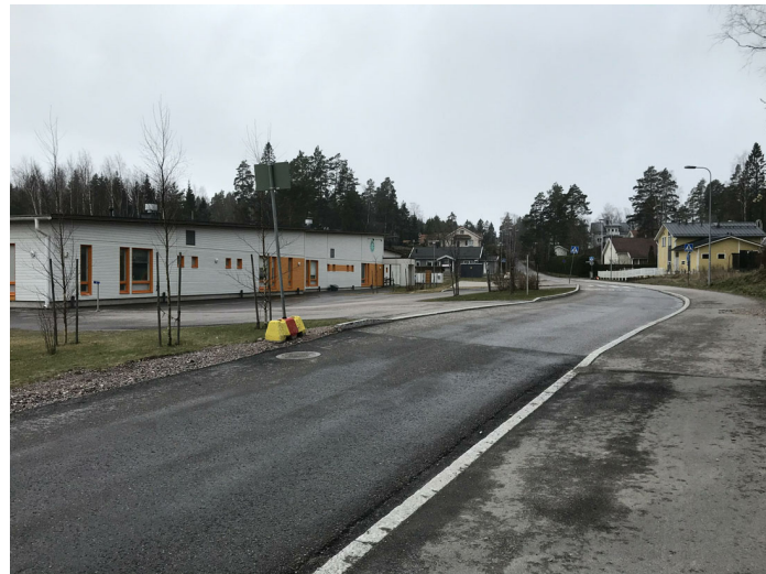
Valokuvat vuodelta 2020, jonka jälkeen ympäristöön on tullut uutta rakentamista.
