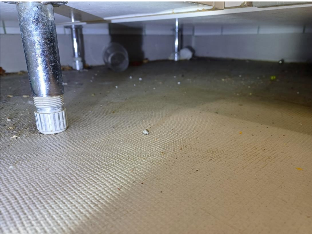
Kuva 4.6. Laitoskeittiö kaapistojen alustat ovat epäsiistejä.
