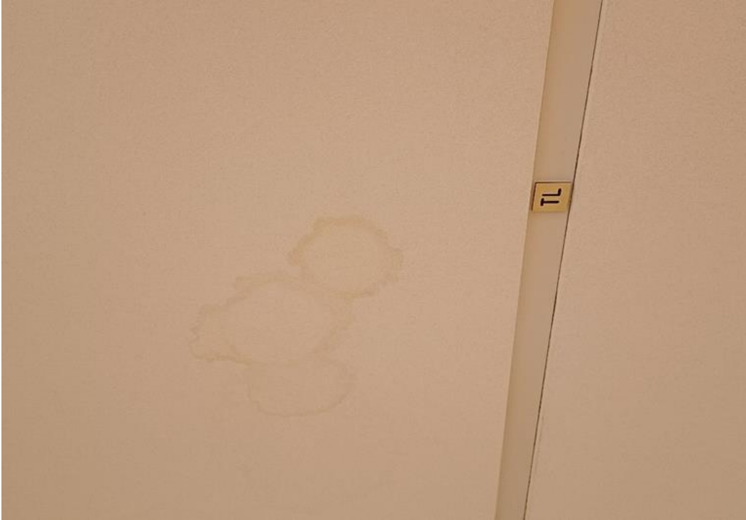
Kuva 4.1. Aulan 102 alakaton akustointilevyssä on vanha kosteusjälki.
