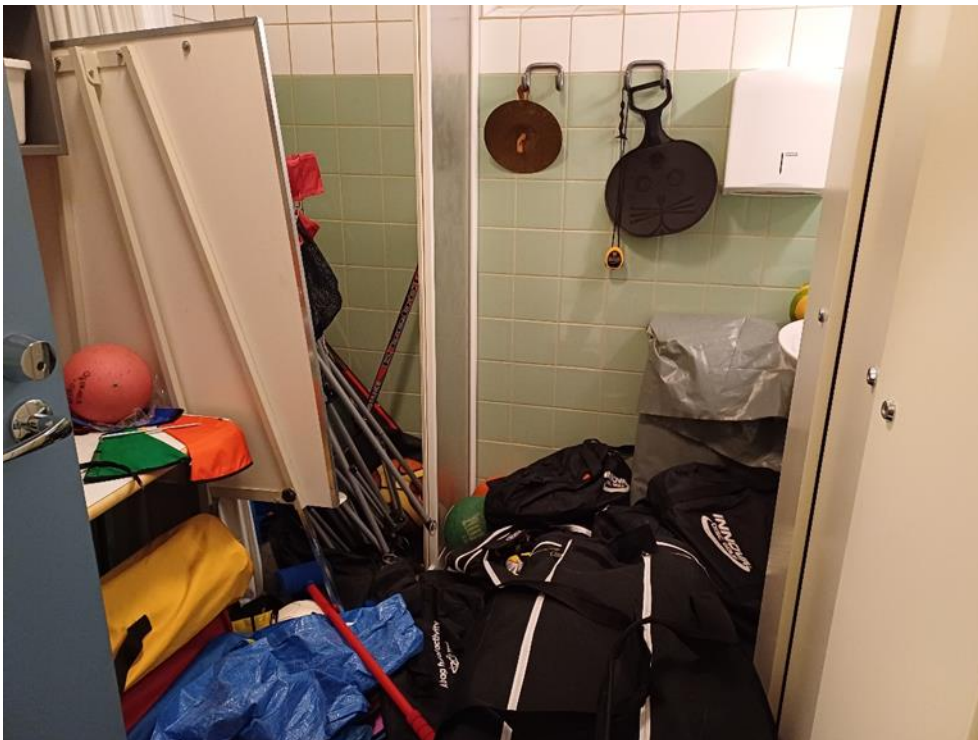
Kuva 4.8. 173 Suihkutilaan varastoidut tavarat estävät lattiakaivon täytön vedellä ja kuiva kaivo aiheuttaa viemärinhajua.
