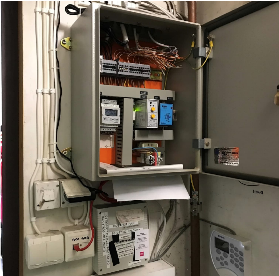
Kuva 6.2. Ilmanvaihtokoneen rakennusautomaatio.
