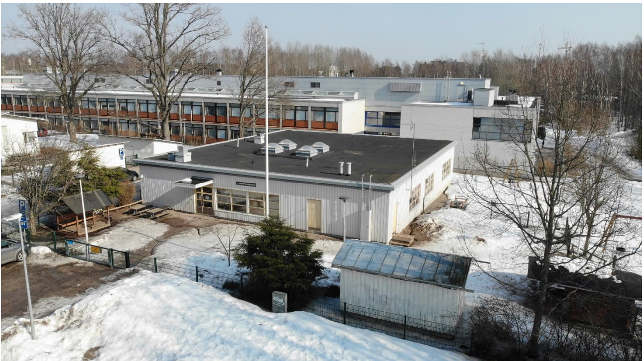
Ilmavalokuva kohteesta 28.2.2024. Päiväkotirakennuksen takana on Kaitaan koulu.
