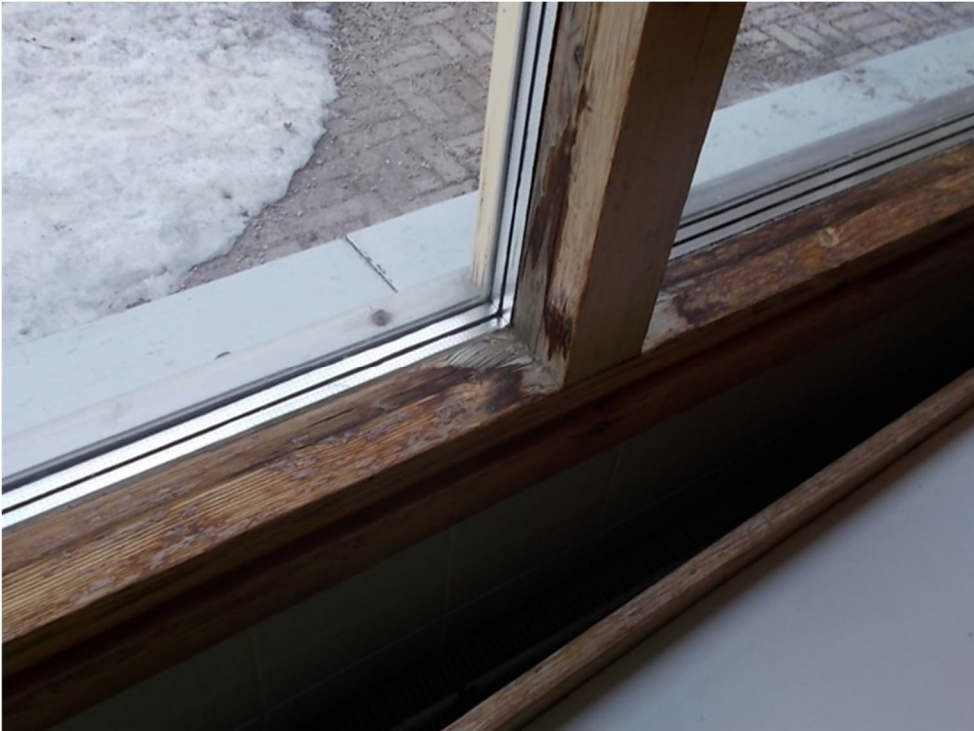
Kuva 4.4. Ikkunakarmit ovat kauttaaltaan huollon tarpeessa.
