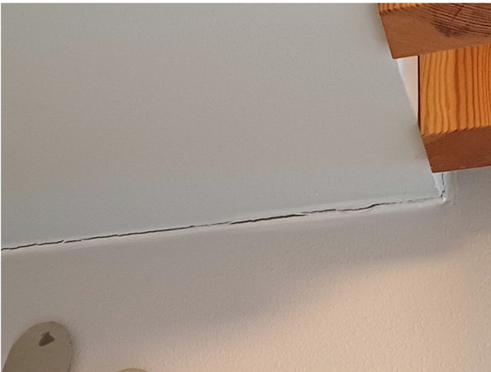
Kuva 4.8. Rakenneliittymien ratkeamia on runsaasti lähes kaikissa tiloissa.
