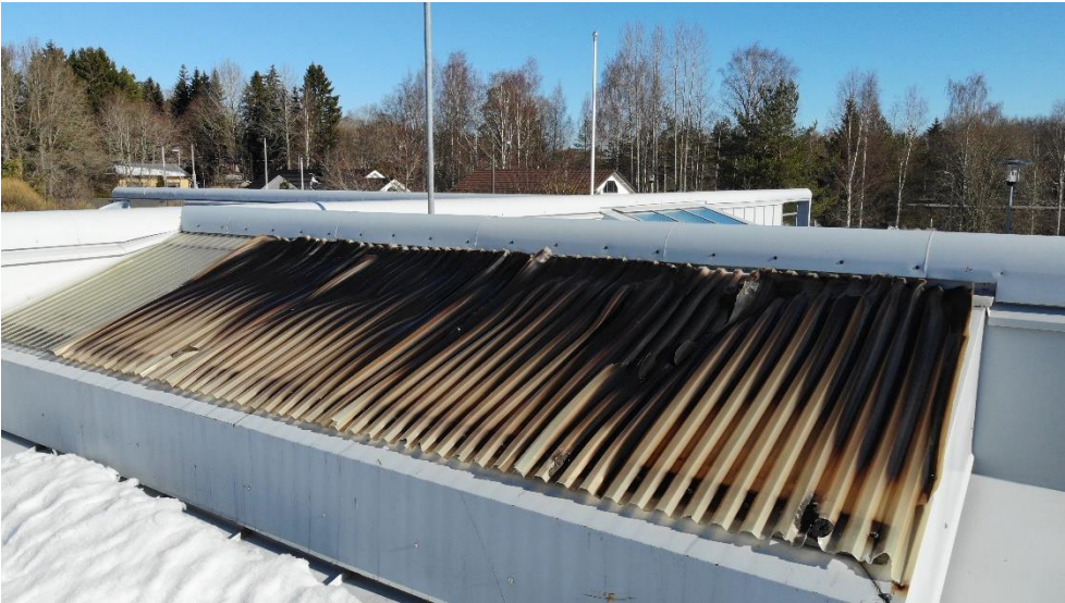
Kuva 4.17. Päärakennuksen valokate tarkastuksen 16.3.2023 yhteydessä kuvattuna.
