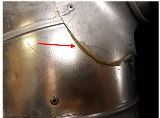
ASB.04 Tiivistysmassa, IV-kanava, vaalean ruskea. Samasta massasta otettiin raskasmetallianalyysiin näyte RM.01.
