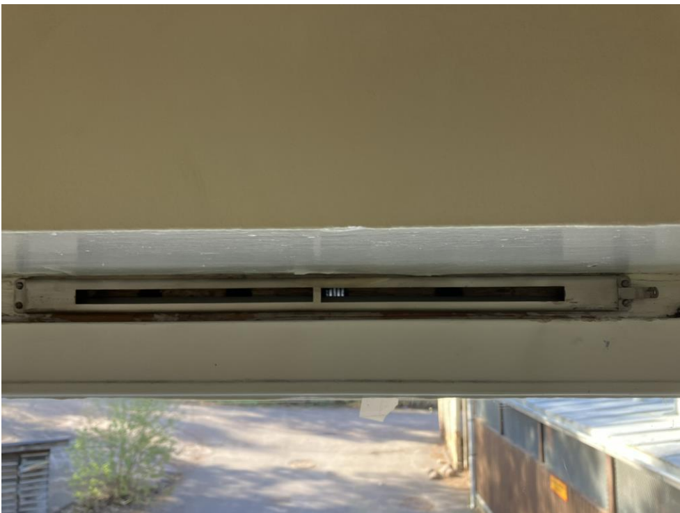
Kuva 5.2. Likainen korvausilmaventtiili.
