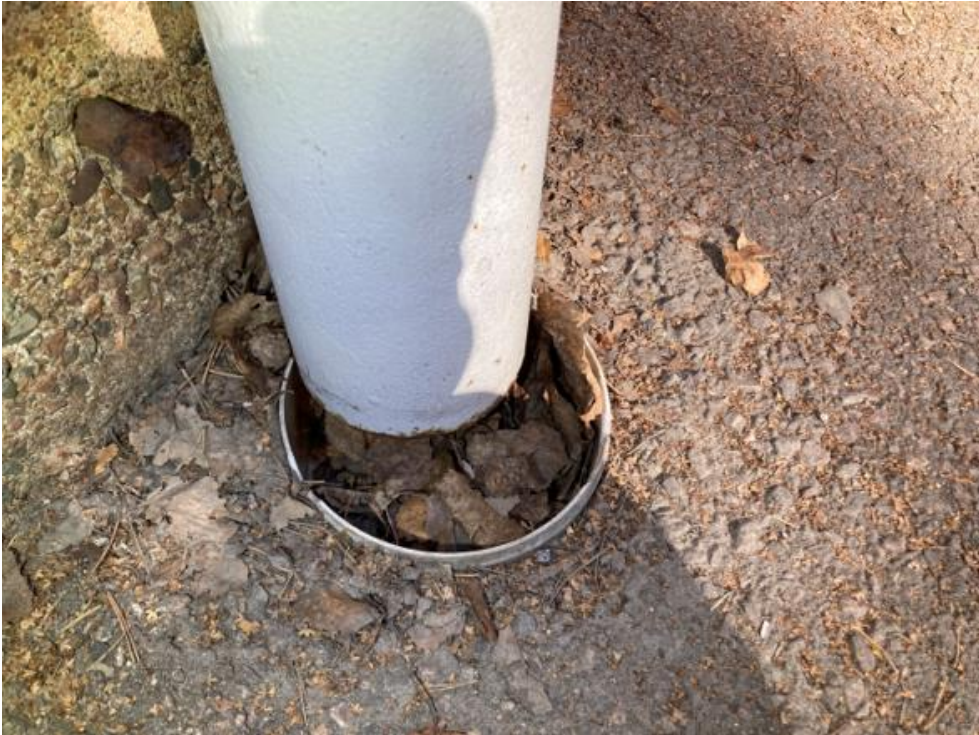
Kuva 5.5. Sadevesien maan alle menevissä sadevesiviemäreissä on paikoin runsaasti lehtiä ja muuta roskaa.
