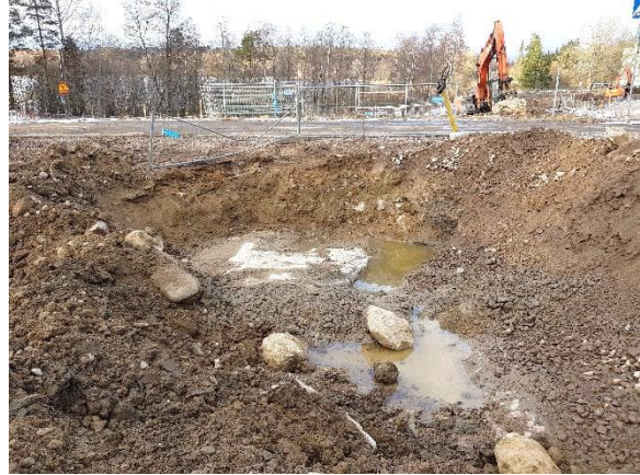
Kuva 2. Öljysäiliöalueen kunnostusta (pohjalla kallio).
