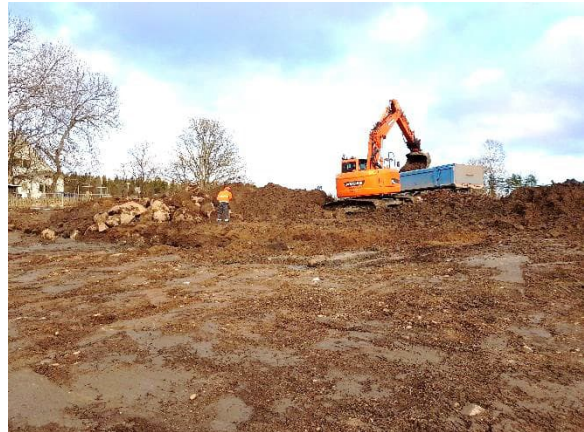
Kuva 4. Pilaantuneen maaperän puhdistamista.
