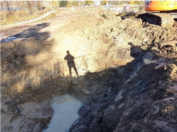
Kuva 3. Betonirengaskaivon ja putkilinjojen kaivua.
