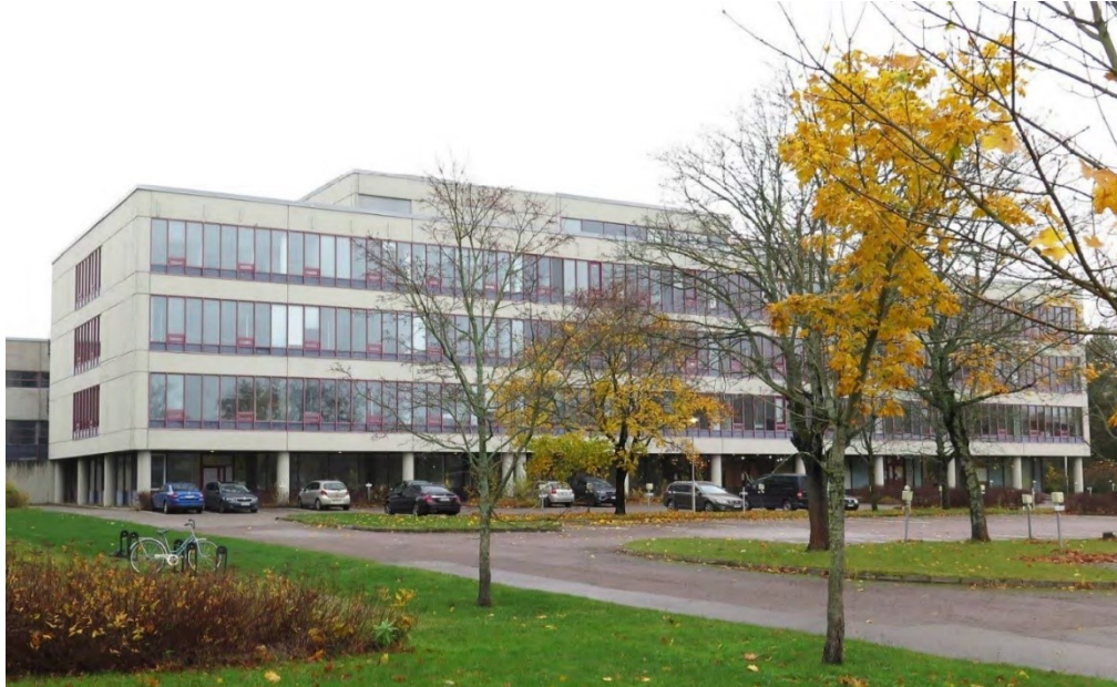
Kuva: Toimistorakennus tontin Turunväylän puolella. Rakennus on kiinteästi yhteydessä hallimaiseen varasto-osaan. Kiinteistön omistajalla ei ole rakennukselle käyttöä, ja se on tällä hetkellä tyhjiään.
