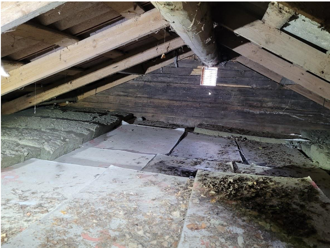
Kuva 3. Matalaa ullakkotilaa. Päädyssä on tuuletusräppänä.
