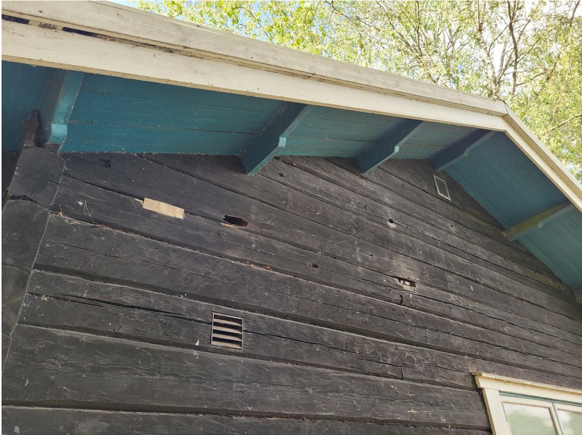
Kuva 2. Saunarakennuksen itäpäädyssä näkyy lepakoille soveltuvia kulkuaukkoja.
