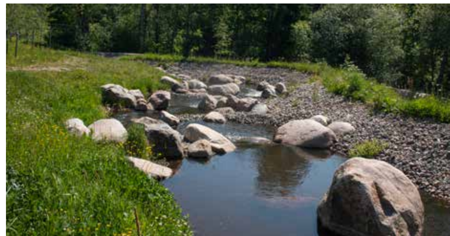
Gumbölenjoen padon itäpuolelle on rakennettu vuonna 2020 noin 190 metriä pitkä kalatie, joka mahdollistaa vaelluskaloille kulkureitin padon ohi. Mutkittelevaan uomaan on asennettu suuria virtauskiviä vaihtelevien virtausolosuhteiden aikaansaamiseksi. Kuva: Noelle Renberg
