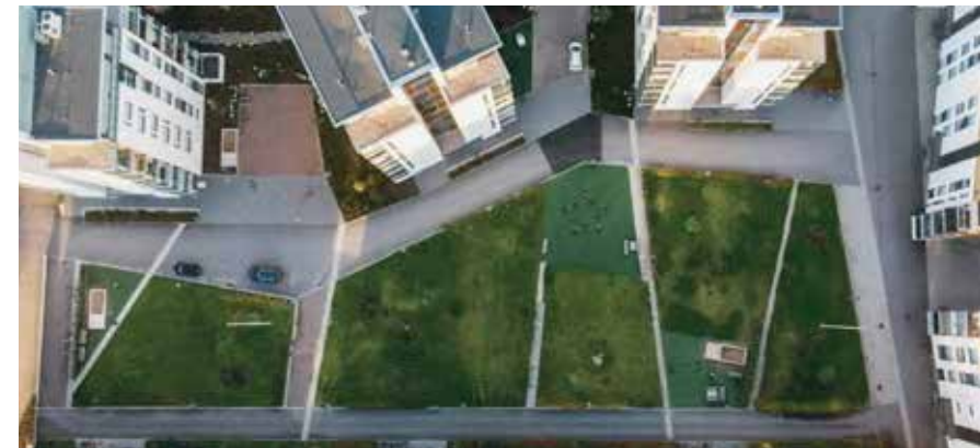
Tapiolan Revontulikorttelin pysäköintihalleihin on rakennettu maantasossa oleva kansipiha, jolla kasvaa pieniä puita, pensaita, kunntaa ja nurmea. Laaja kansipuutarha näkyy ympäröiviin rakennuksiin ja tarjoaa tilaa esimerkiksi pallotteluun avoimella nurmella. Kuva: Pyry Kantonen
