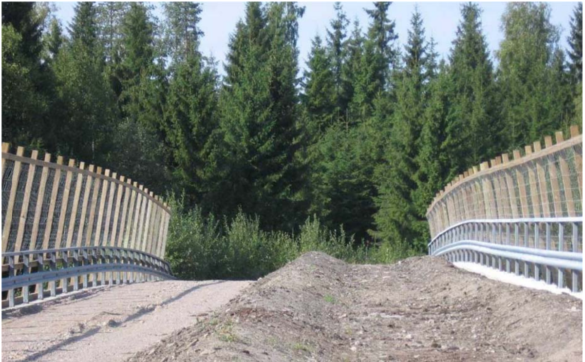
Kuva 6. Vierumäen vihersilta Heinolassa valtatie 4:llä ennen puuston istuttamista (© Väre 2007).
