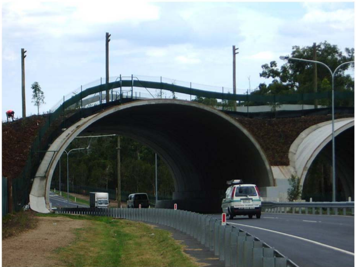
Kuva 9. Australiassa moottoritien yli tehty silta- ja tolppayhteys (© Taylor & Goldingay 2009).
