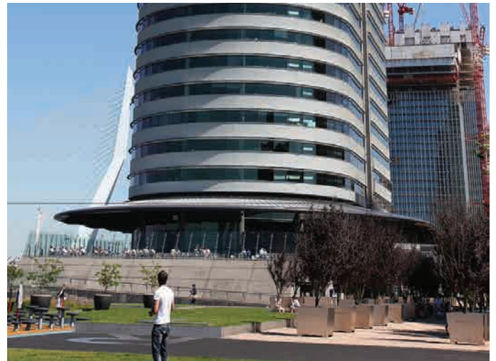
Katos suojaa Rotterdammassa sijaitsevan Foster+Partnersin World Port Centerin maantasossa sijaitsevan ravintolan terassia -teen lisäksi myös tuulelta.
