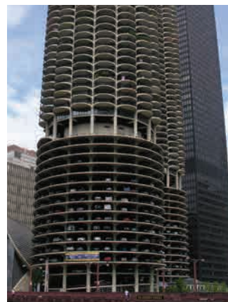
Bertrand Goldbergin suunnittelemissa, 1960-luvun alussa valmistuneissa Marina City-rakennuksissa pysäköinti on otettu osaksi tornien arkkitehtuuria.
