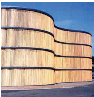
Leipzigissä sijaitsevan, Hentrich-Petschnigg & Partnerin suunnitteleman Parkhaus Zoon ajoramppien pyöreät muodot tekevät julkisivusta kiinnostavan. Runsas puun käyttö inhimillistää rakennusta. (Henley, 2007)
