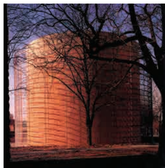
Mahler, Günther, Fuchsin suunnittelema Parkhaus am Bollwerksturm sijaitsee Heilbronnissa. Vaikka siinä on viisi kerrosta, se vaikuttaa kokoaan pienemmältä käytettyjen materiaalien ja hoikan muodon ansiosta. (Henley, 2007)
