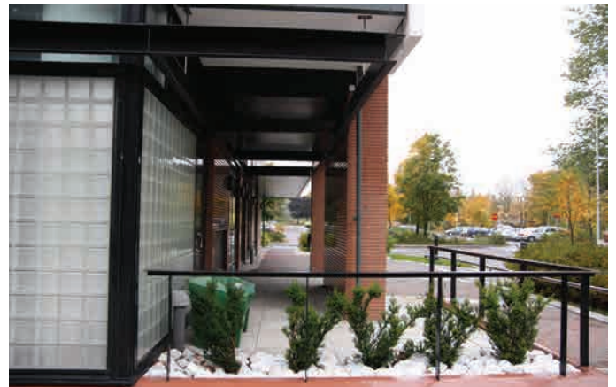
Kivenlahden Reimantornin arkadikäytävä rajaa rakennuksen sisäänkäynnin sen edessä kulkevasta kevyen liikenteen väylästä. Rakennuksen arkkitehtina toimi Juha Mutanen.
