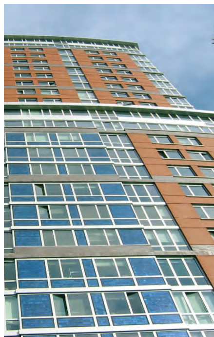
THE SOLAIRE, NEW YORK
