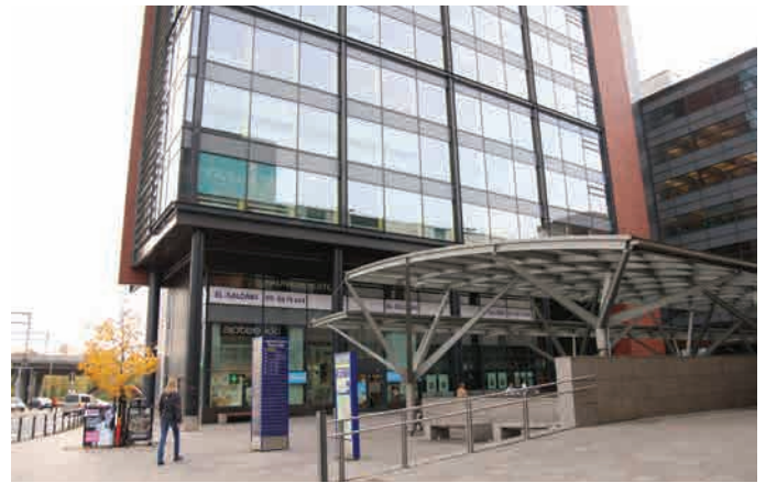
Leppävaarassa sijaitsevan Panorama Towerin maantasokerros on varattu liiketiloille. Se on selkeästi korkeampi kuin ylemmät toimistokerrokset. Rakennuksen on suunnitellut arkkitehtitoimisto Larkas & Laine Oy
