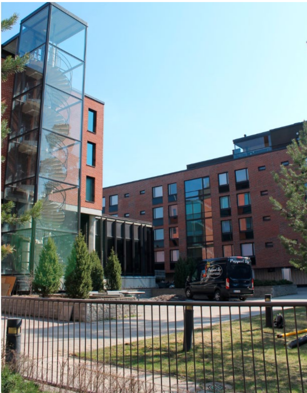
Tyrskyvuoren reunoilla olevien rakennusten piha-alue, jota jäsentää ilmava aita.
