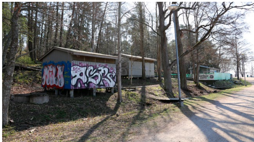
Uimarannan paikalla toimi aikoinaan Stensvikin henkilöliikennettä palveleva höyrylaivalaituri.
