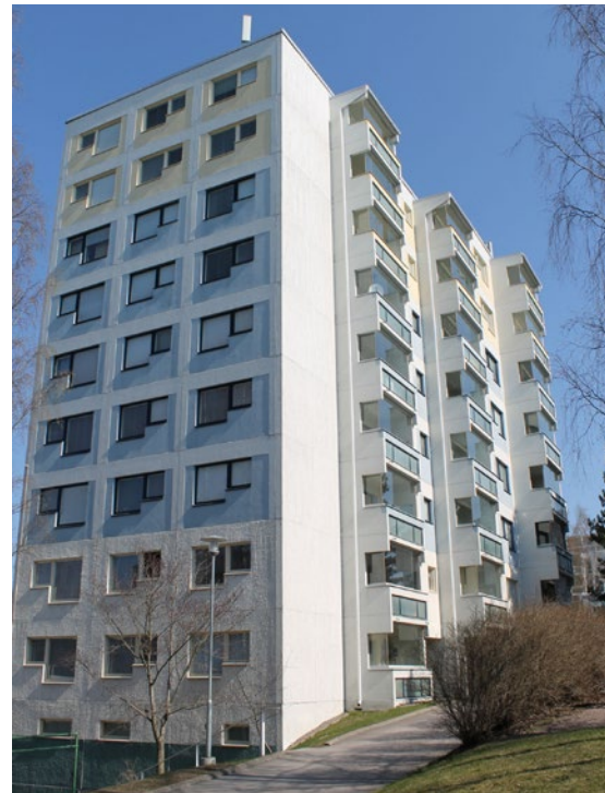
Pohjoisin, korkea asuinrakennus.
