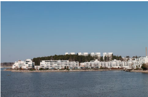
Marintornit erottuvat selkeänä maamerkinä Kivenlahden kaukomaisemassa.
