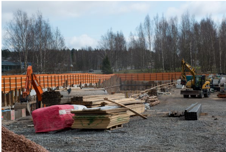
Kivenlahden metroaseman rakentaminen vuonna 2015. (Espoon kaupunginmuseo)
