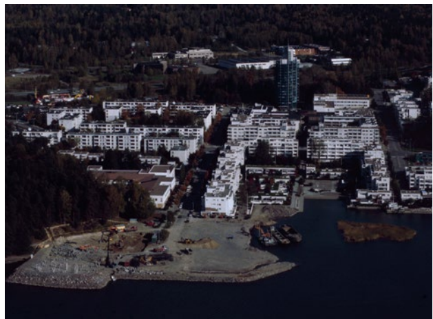
Rannan rakentaminen on käynnissä vuonna 1998. Alkuperäisistä suunnitelmista poiketen rantaan ei rakennettu kasino. (Espoon kaupunginmuseum)
