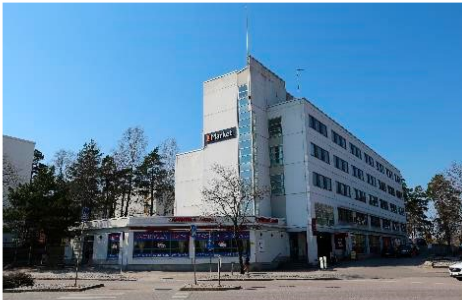
Rakennuksen arvo perustuu rakennuksen merkitykseen tärkeän sisäntuloväylän kulmauksessa.
