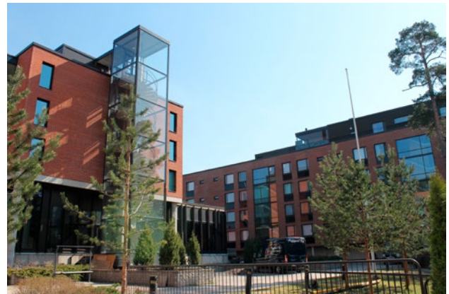
Näkymä sisäpihalta pohjoisen suuntaan
