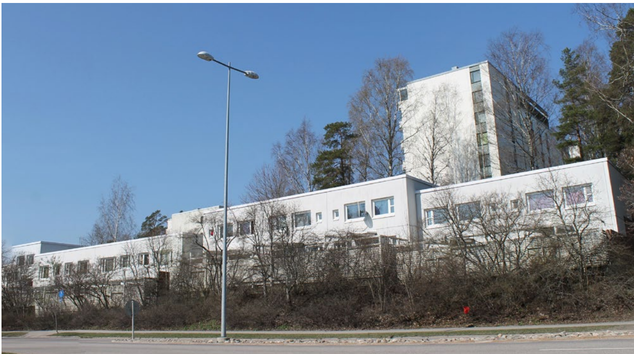
Pitkä julkisivu Espoonlahdenranta -kadun suuntaan
