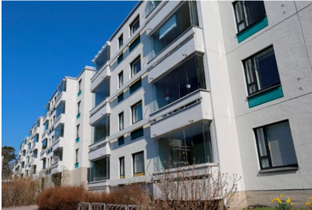
Merivalkama 3-5:n pihajulkisivu.
