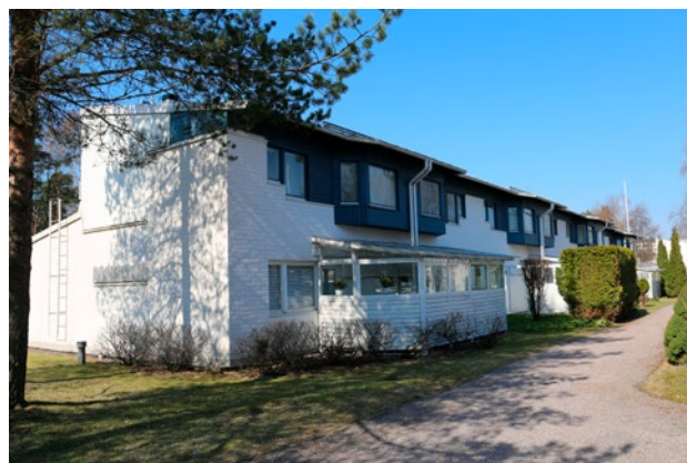
Vilkkupoiju 9 sisäpihan pitkä rakennus.
