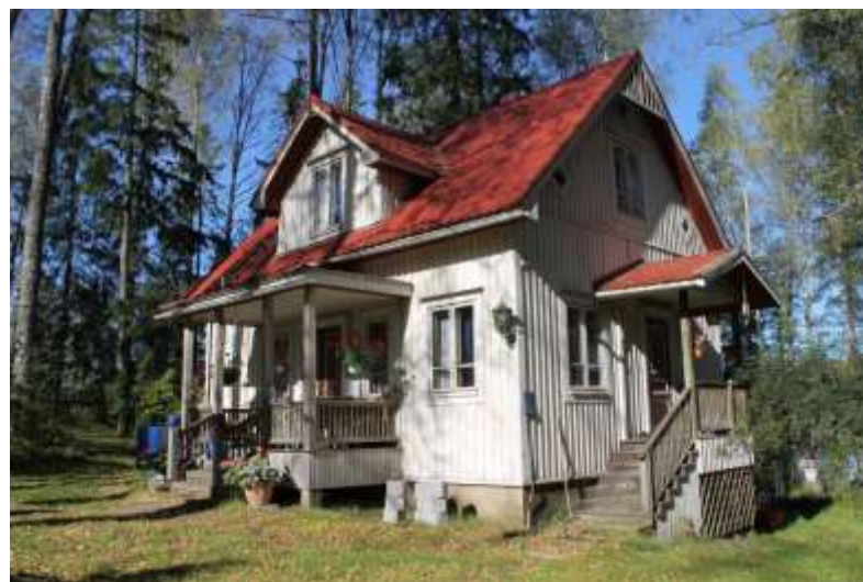
Lomarakennuksen Kolmperäntien puoleinen julkisivu.
