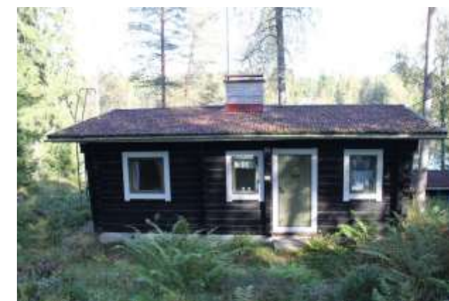
Lomarakennuksen Kolmperäntien puoleinen julkisivu.
