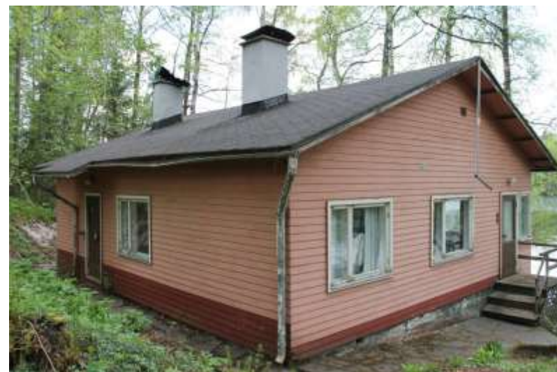
Lomarakennuksen julkisivut rinteen suunnalta.
