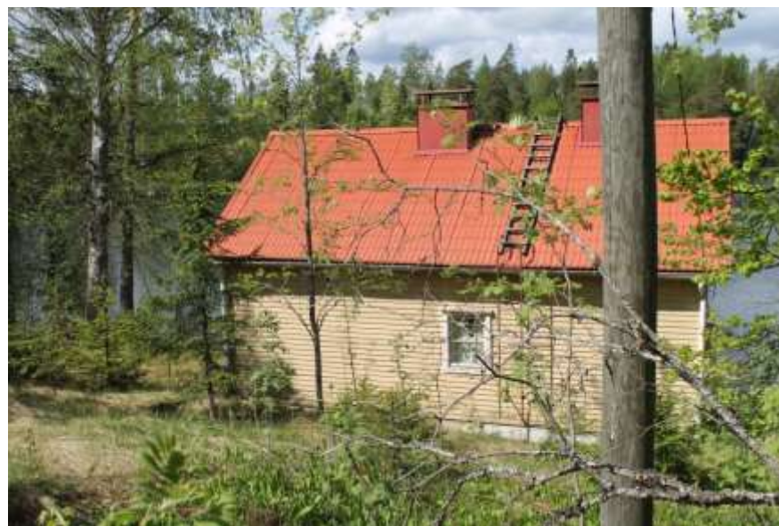
Lomarakennuksen Kolmperäntien puoleinen julkisivu.
