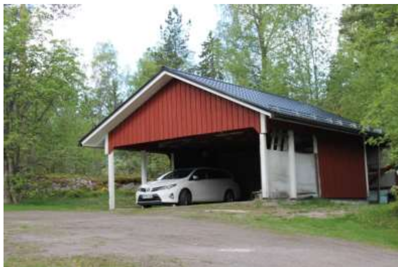
Autokatos ja varastorakennus.
