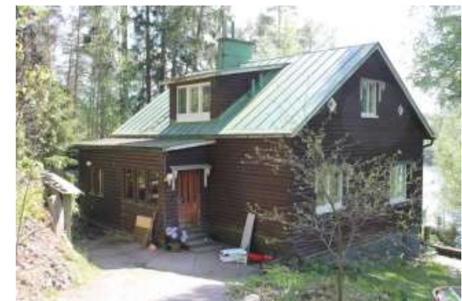
Asuinrakennuksen etupihan puoleinen julkisivu.
