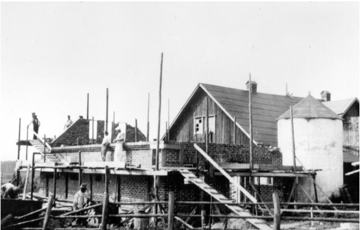
9. Bellin navettaa laajennetaan tiiliseksi, 1920-l:n loppu. EH
