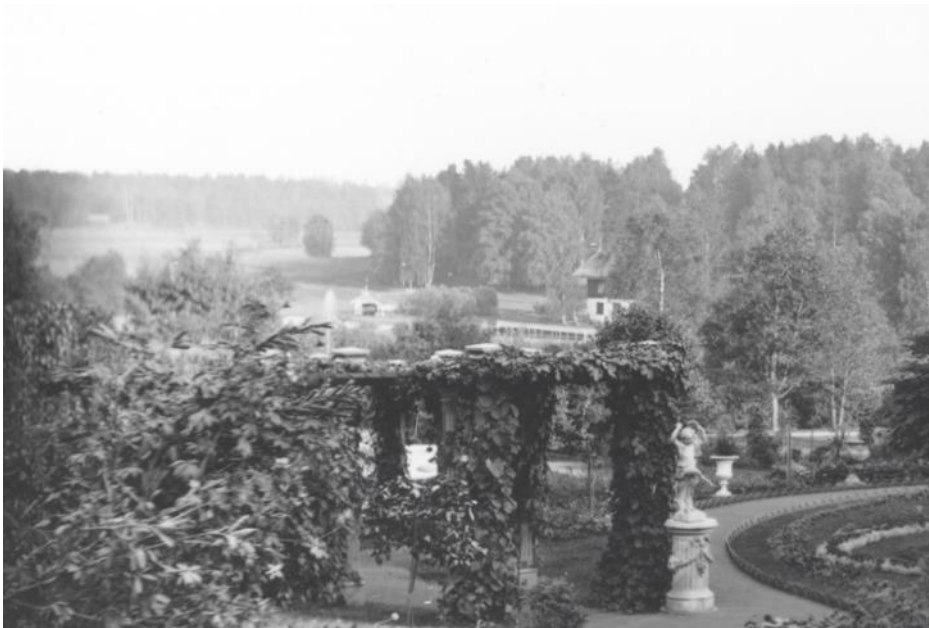
Näkymä päärakennuksesta kohti järven poukamaa 1880 (osa). Valokuva Reinhold Hausen. Museovirasto
