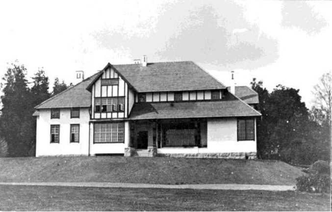
1900-luvun vaihteessa valmistuneen uuden, puurakenteisen päärakennuksen suunnitteli arkkitehtitoimisto Gesellius-Lindgren-Saarenen. Museovirasto
