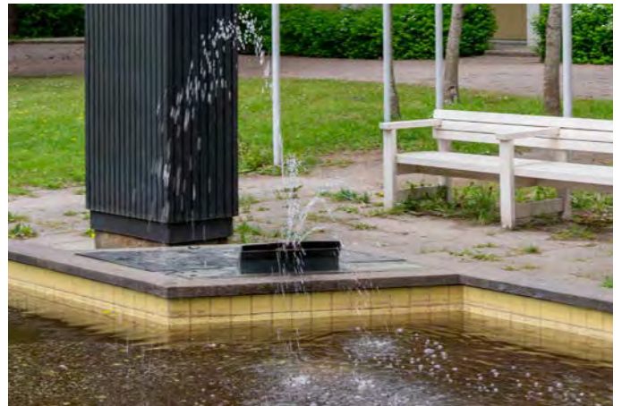
Neulaspuiston vesialtaan reuna on laatoitettu keltaisilla laatoilla. Altaan vesisuihku tulee litteästä kuparisesta suuttimesta altaan reunalta.
