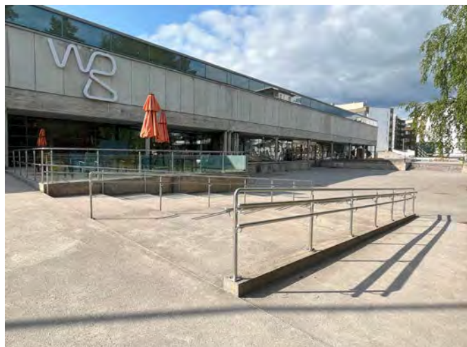
Betonista valetut portaat ja luiska laskeutuvat lastauspihalle. Kaiteet on tehty pyöreästä RST-putkesta. Taustalla ravintolan terassi.
