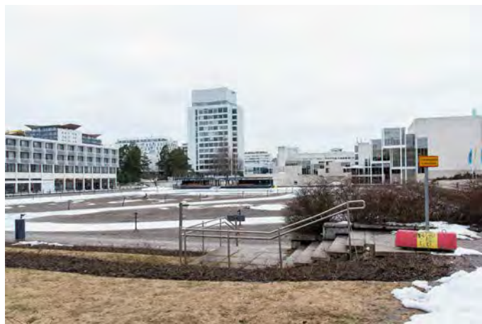
Alkuperäisiä kaiteita on paikoin korvattu ja täydennetty rosterisilla pyöröputkesta valmistetuilla kaiteilla.
