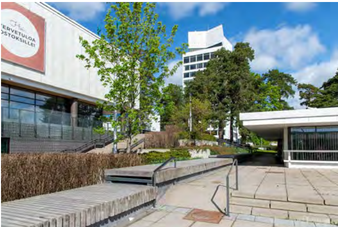
Tuulikinsillan uudistunut pohjoispää. Istuimena toimivan rakenteen pinta on tehty lehtikuusilankuista.
