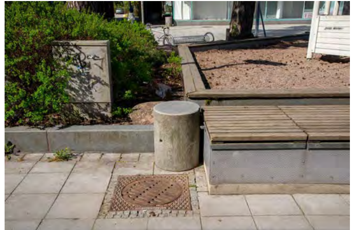
Uusia rakenteita, materiaaleja ja kalusteita leikkipaikan tuntumassa.
