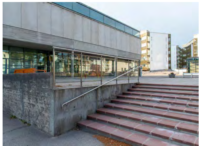
Aukion koillispuolella portaat on päällystetty punaisilla betonilaatoilla. Alkuperäiset betoniset tukimuurit ovat kauniisti patinoituneita.
