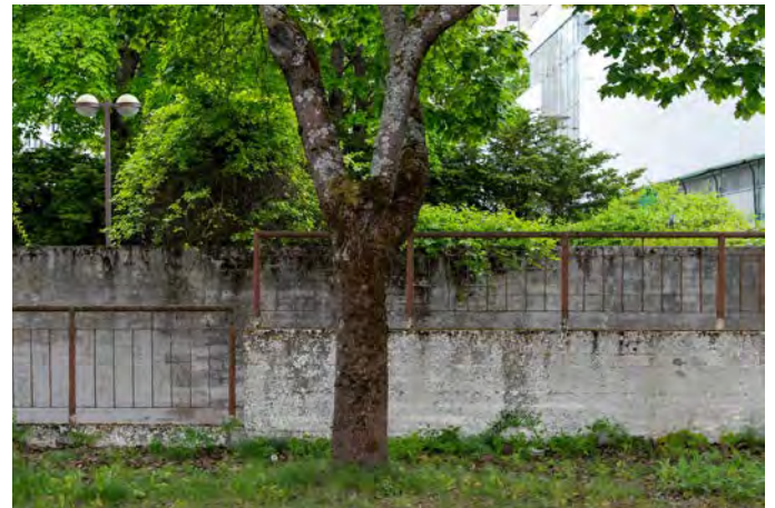
Alkuperäisiä muureja Sampotorin pohjoislaidalla ja Kauppamiehentien reunalla. Maalatut kaiteet muurien päällä ovat alkuperäisiä tai alkuperäisen mallin mukaan tehtyjä.
