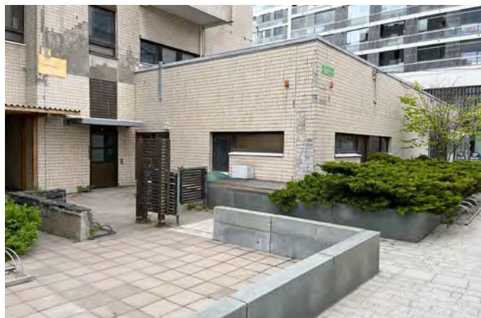
Monenlaisia pinnoitteita ja rakenteita Länsituulen pohjoisreunalla, KOY Hopiakanteleen edustalla.
