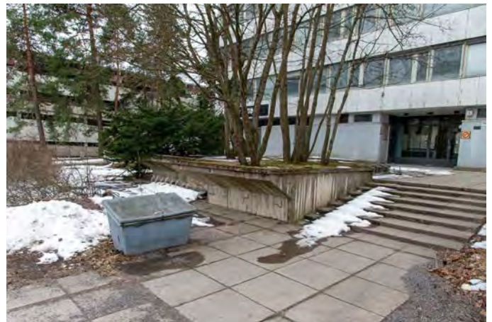
KOY Raitinlukon edustan vanhoja betonirakenteita, 700 x 700 mm laatoitusta ja laattamoduulin mukaiset portaat.
