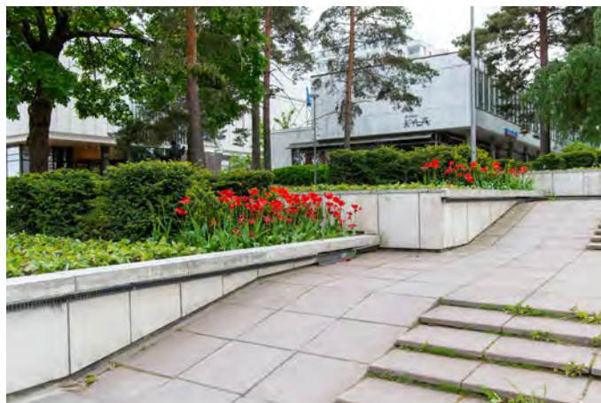
Tapiontorin portaikossa on näyttävät kukkaistutukset. Tukimuurien päällysteenä on käytetty valkokiviaineisia pesubetonilaattoja.
