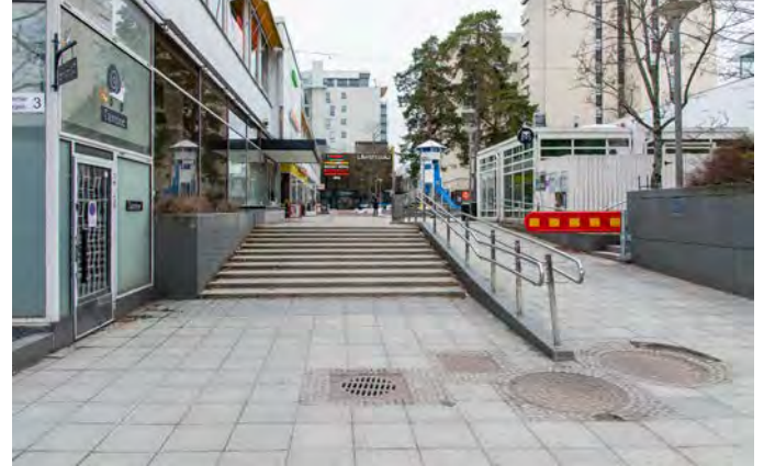
Uudet portaat, kaide ja tukimuuri Sampotorin pohjoislaidalla. Rosterinen kaide sopii heikosti kokonaisuuteen, kuten myös noppakivillä rajatut kaivonkannet.
