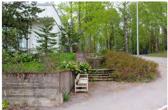
Aukiolle nousevat portaat Itärannan ja Harjuviidan risteyksestä. Rinnettä on pengerrytetty lautamuottipintaisilla betonisilla tukimuureilla.
