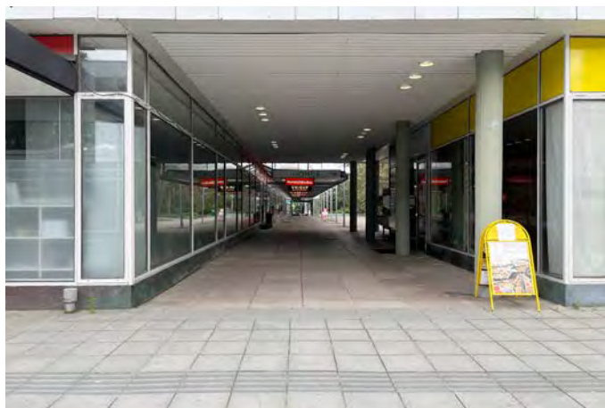
Tapionraitin päällyste vaihtuu Tapiolan ostoskeskuksen ja Sampotorin rajalla 700 x 700 mm betonilaatoituksesta pienemmäksi 400 x 400 mm graniittilaatoitukseksi.
