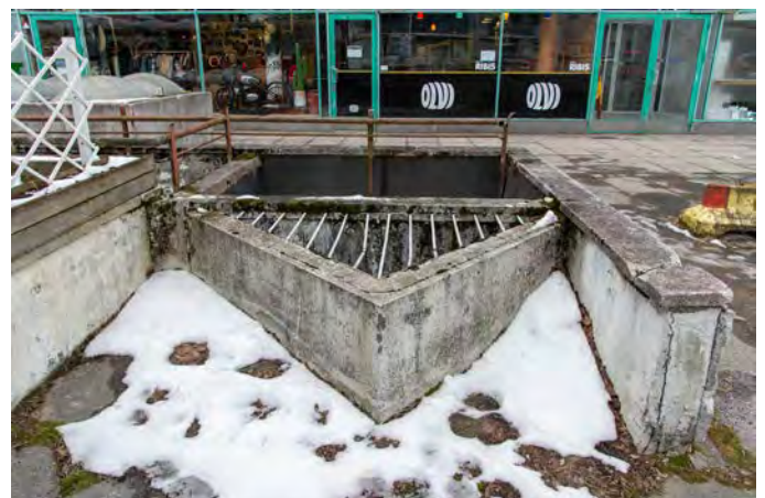
Maanalaisiin tiloihin liittyviä rakenteita Heikintorin pohjoispuolella.
