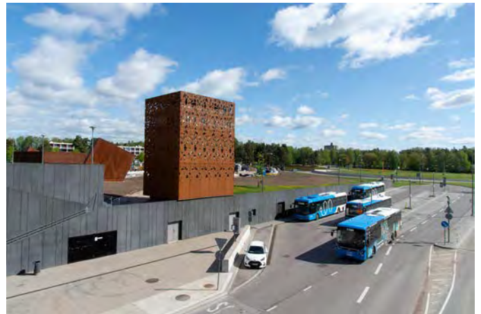
Tuulikinsillan nykyisen eteläpään kohdalla on ajoyhteys Tapiolan kannenalaisen paikallisliikenteen linja-autotermiiniin.
