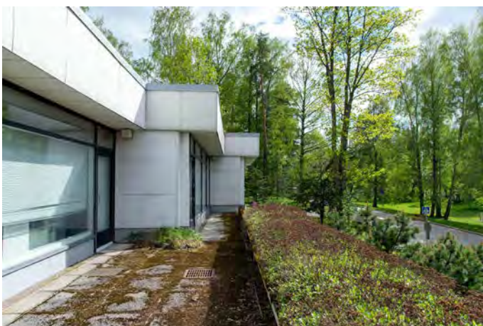
Liiketiloihin on sisäänkäynti myös rakennuksen länsipuolelta. Terassin kaiteena toimii betoninen istutusallas.
