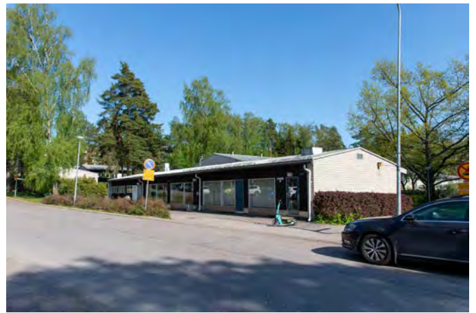
As.oy Kontiontie 3, toimisto- ja huoltorakennus.
