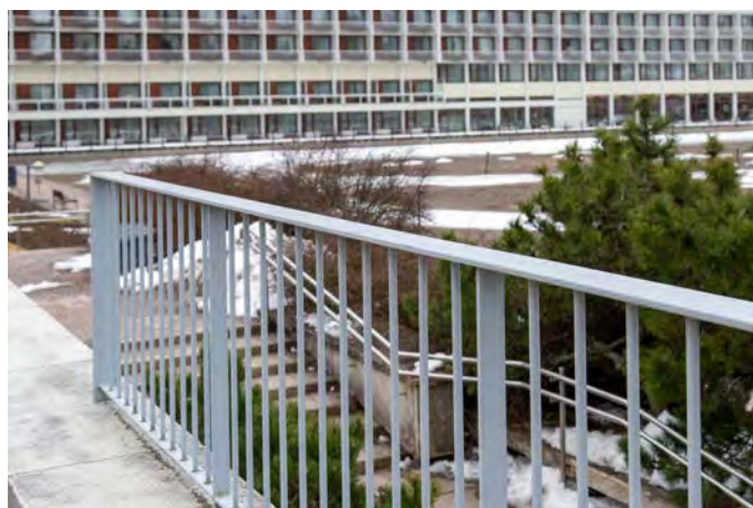
Alueen alkuperäiset kaiteet on tehty lattateräksestä ja maalattu vaalean harmaiksi.
