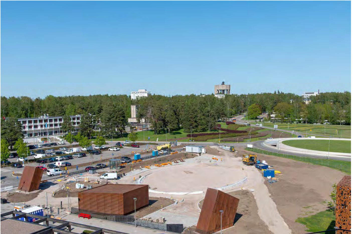
Tapionaukion eteläpuolelle sijoittuvassa Tapionpuistossa olivat keväällä 2023 käynnissä rakennustyöt. Metroon liittyvät cortenpintaist rakenteet dominoivat maisemaa.
