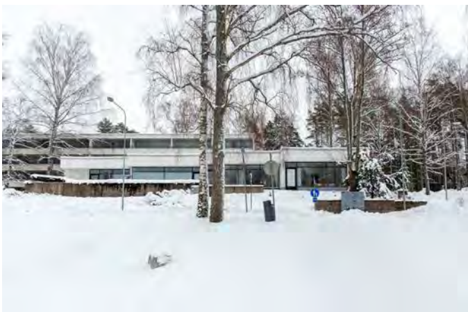
Rinteeseen sijoittuva matala liikerakennus on Itärannan puolelta melko huomaamaton.
