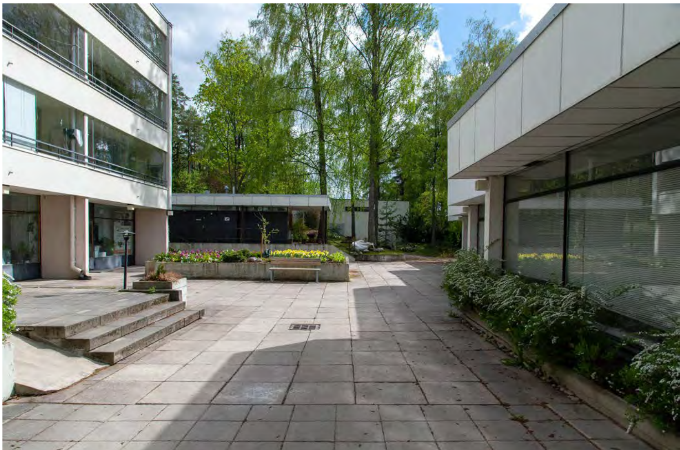
Itärannan ostoskeskus pohjoisesta. Laatoituksen koko vaihtuu aukion pohjoispäässä 700 x 700 mm:stä 400 x 400 mm:ksi.
