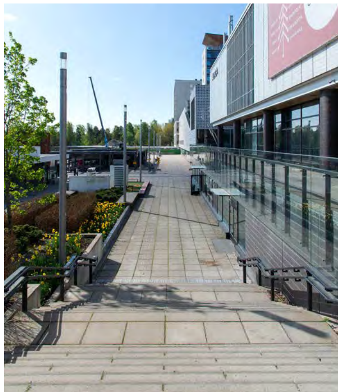
Tuulikinsillan uusissa portaissa on sovellettu Tapiolalle tyypillistä 700 x 700 mm laattamoduulia puolen laatan limityksellä.
