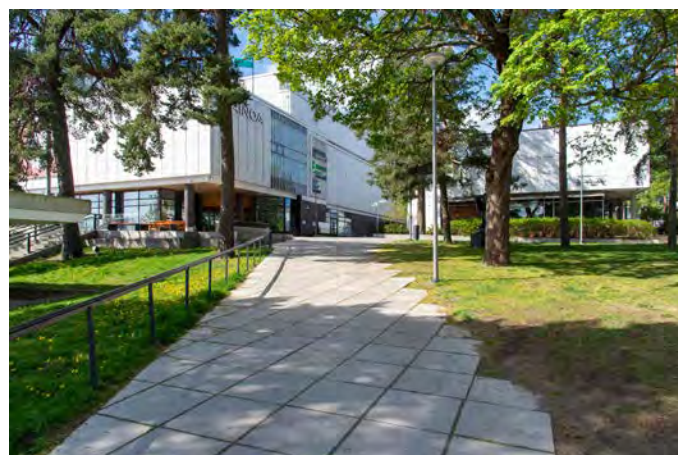
Laatoitus liittyy kasvillisuusalueisiin pääosin ilman reunakiveä.
