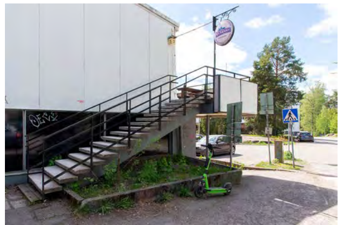
Oravannahkatori 3:n päädyssä sijaitsevat terassille johtavat portaat. Portaiden alla ja alapäässä on betonimuurein tuetut istutusaltaat.
