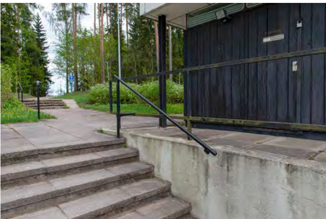
Portaiden pinta on betonilaattaa. Vanhaan neliöputkiseen kaiteeseen on liitetty uusi pyöröputkikaide.
