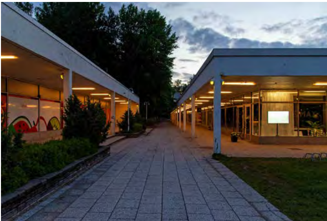
Katosten alapinnoissa on loisteputkivalaisimet, minkä lisäksi pilareihin on myöhemmin lisätty kupuvalaisimet.
