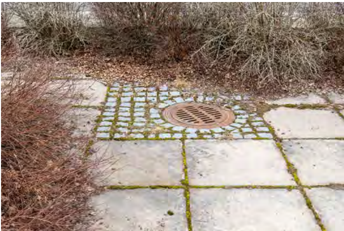
Alkuperäiseen laatoitukseen on sijoitettu muun muassa vääränmallisia viemärinkansia, minkä lisäksi on käytetty alueelle huonosti sopivia materiaaleja kuten noppakiviä.
