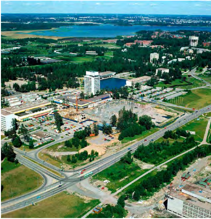
Ilmakuva lounaasta uuden keskustan rakentamisen alkuaikoina 1970-luvun loppupuolella. Länsituulenaukion pysäköintialue oli huomattavasti nykyistä laajempi. Arkkitehtuurimuseo.
