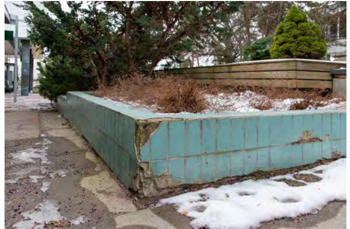
Suihkulähteen altaaseen on istutettu kasvillisuutta. Turkoosi paikoitellen huonokuntoinen laatoitus ei ole alkuperäinen.
