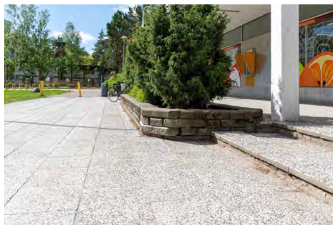
Pohjantorin ostoskeskuksen edustalle on tehty jossakin vaiheessa betonikivisiä istutusaltaita, jotka sopivat huonosti selkeälinjaisiin ja materiaalivalinnoiltaan harkittuihin rakennuksiin. Kävelyalueiden pesubetonilaatoitus ei ole alkuperäinen
