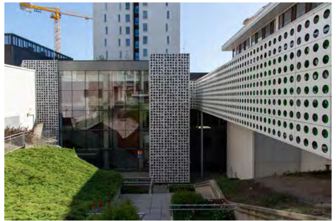
Metron sisäänkäynnille johtavat Länsituulelta portaat. Oikealla Merituulentorille vievä kävelysilta.
