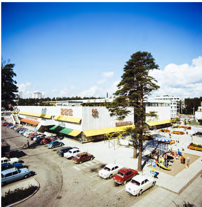
Sampotori ja Länsituulenaukio liittyivät toisiinsa nykyistä vahvemmin ennen 1970-luvun lopun uudisrakentamista. Kuvan etualalla puisto liukumäkineen. KAMU, Teuvo Kanerva 1972.
