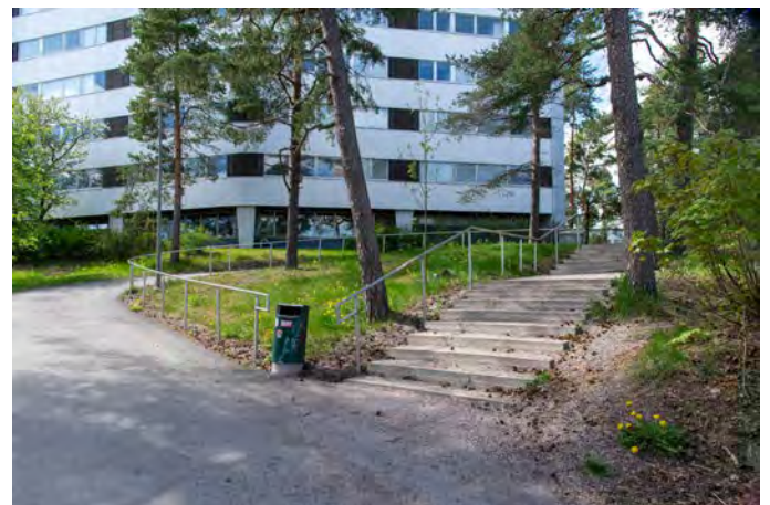
Uudet portaat Tapionraitin länsipäässä on tehty vanhan mallin mukaan, mutta kaiteena on käytetty rosterista pyöröputkea alkuperäisen maalatun teräskaiteen sijaan.
