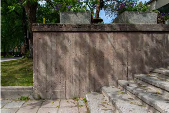
Kino Tapiolan edustan pengerryksissä on käytetty lautamuottipintaisia betonimuureja. Kulkualueiden laatoituksessa on käytetty 350 x 350 mm laattoja, kuten portaissakin.
