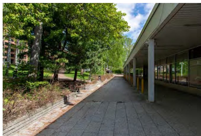
Pohjantori yhdistyy Ukonpuistoon ostoskeskuksen A-osan länsipuolella. Betonikivimuuri ei ole alkuperäinen rakenne.
