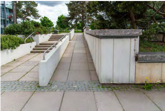
Oikella 1970-luvun betonilaattapintainen tukimuuri, vasemmalla vuoden 2008 hotellilaajennuksen yhteydessä tehtyjä betonirakenteita.
