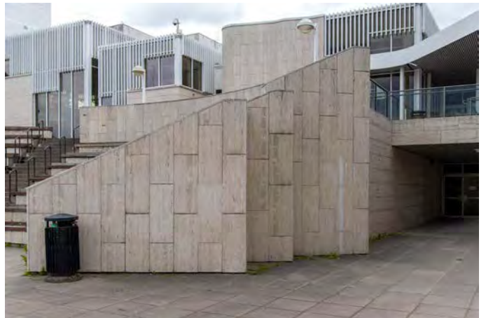
Kulttuurikeskuksen muureissa on käytetty sekä pysty- että vaakasuuntaisia travertiinilaattoja.
