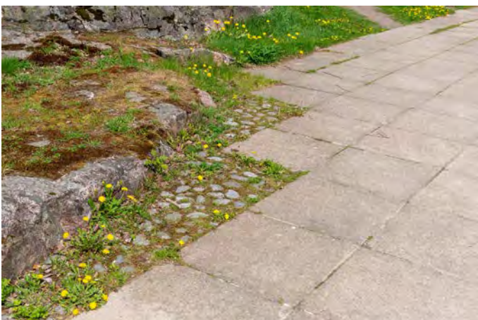
Laatoitus liittyy kasvillisuuteen ja kallioon ilman reunakiveä. Kenttäkivillä tehdyt alueet pistävät silmään alueelle vieraina elementteinä.
