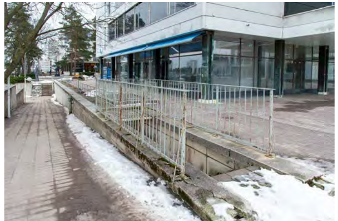
Alkuperäisiä lattateräksestä valmistettuja vaalean harmaiksi maalattuja kaiteita Keskustornin edustalla.
