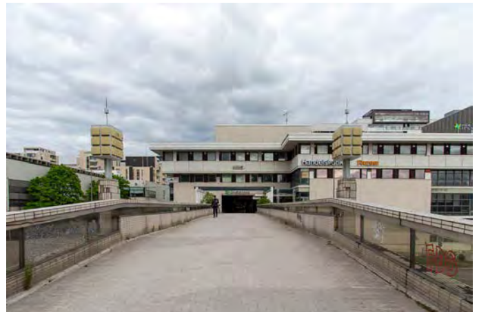
Länsituulensillalla on erityiset valaisimet. Kaiteiden pinnoitteena on käytetty keraamisia laattoja.
