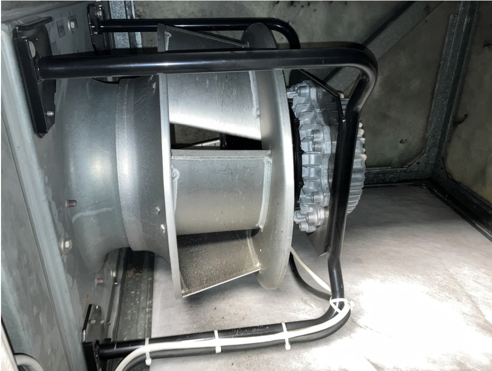
Kuva 5.1. Ilmanvaihtokoneen TK01/PK01 puhaltimet vaihdettu EC-puhaltimiksi.
