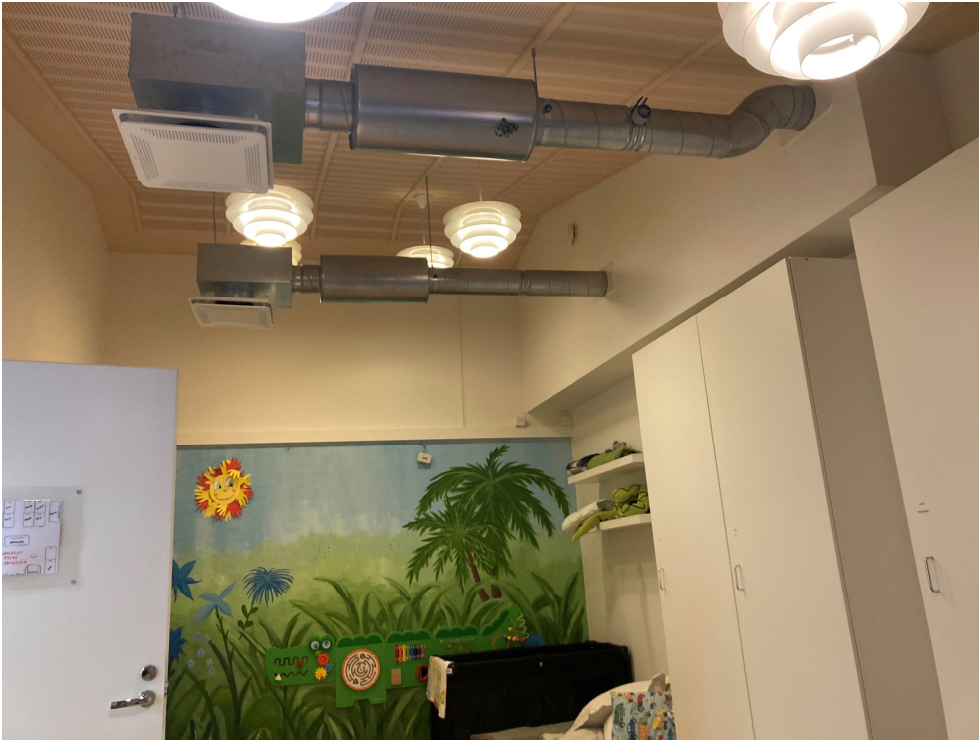
Kuva 5.3. Osassa tiloja on tuloilmapäätelaitteet vaihdettu uusiin ja tuotu keskelle huonetilaa paremman ilmanjaon saavuttamiseksi.
