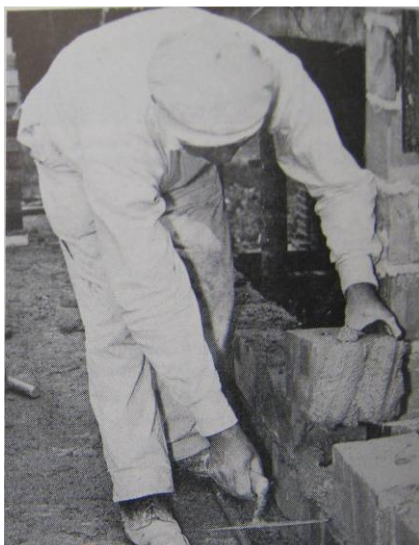
Muurari Vilho Salakka muuraamassa seinää S-16 reikätiilellä. Kuva Rakennustaito 1963 N:o 22
