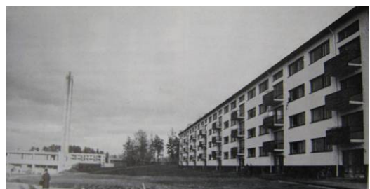
Lämpökeskuksen punatiilinen piippu toimii alueen maamerkinä. Oikealla alueen pisin rakennus, Niittykumpu 10. Maisena on rakentamisen jälkeen paljas ja avoin. Kuva Rakennustaito 1963 N:o 22
