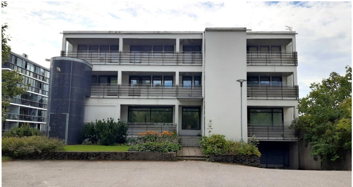
Kuva 2 Suunnittelualueella sijaitseva liikerakennus pohjoisesta kuvattuna.
