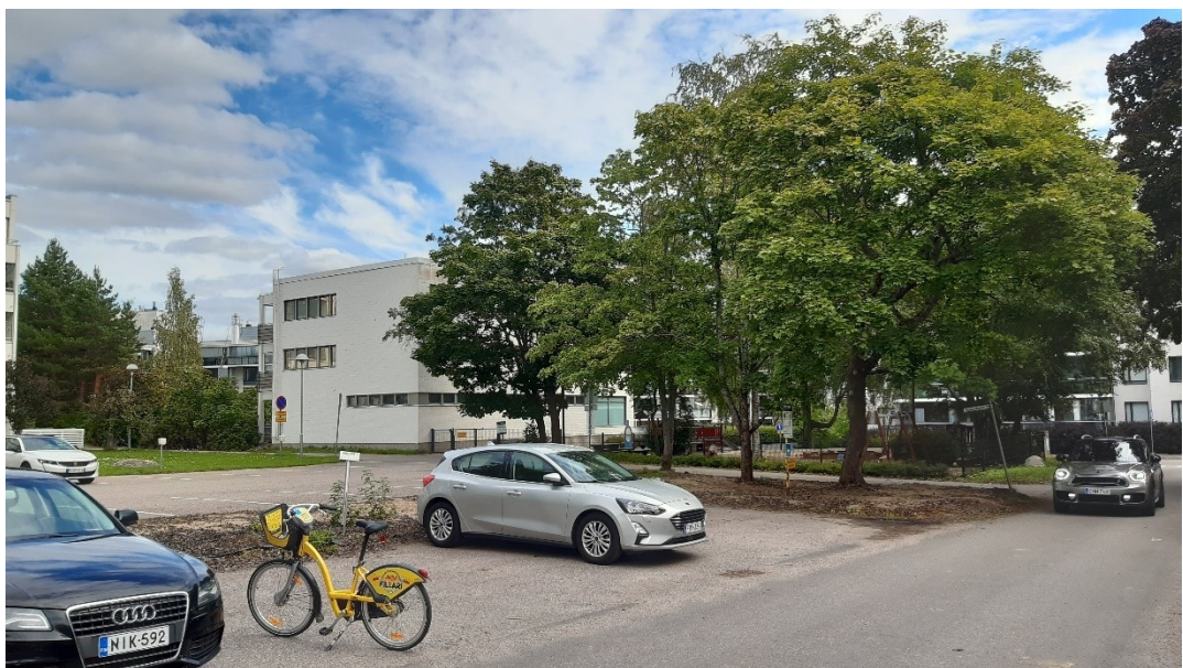
Kuva 9 Katunäkymä Keijuniityntieltä kohti suunnittelualuetta. Taka-alalla näkyy suunnittelualueella sijaitseva kolmikerroksinen rakennus ja oikealla puolen takana Tietäjän alueen puoleinen kerrostalo. Leikkipuisto talon eteläpuolelta on purettu. Kuva syksyltä 2023.
