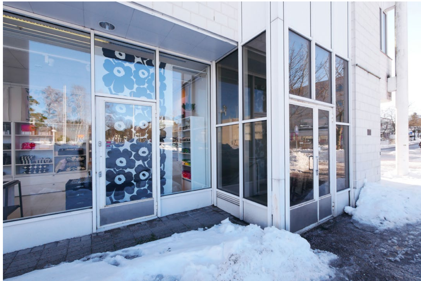
Suurten ikkunapintojen umpinaisissa osissa on käytetty valkoiseksi polttomaalattua alumiinia. Karmit ja jako-osat ovat niin ikään valkoiseksi polttomaalattua alumiinia.
