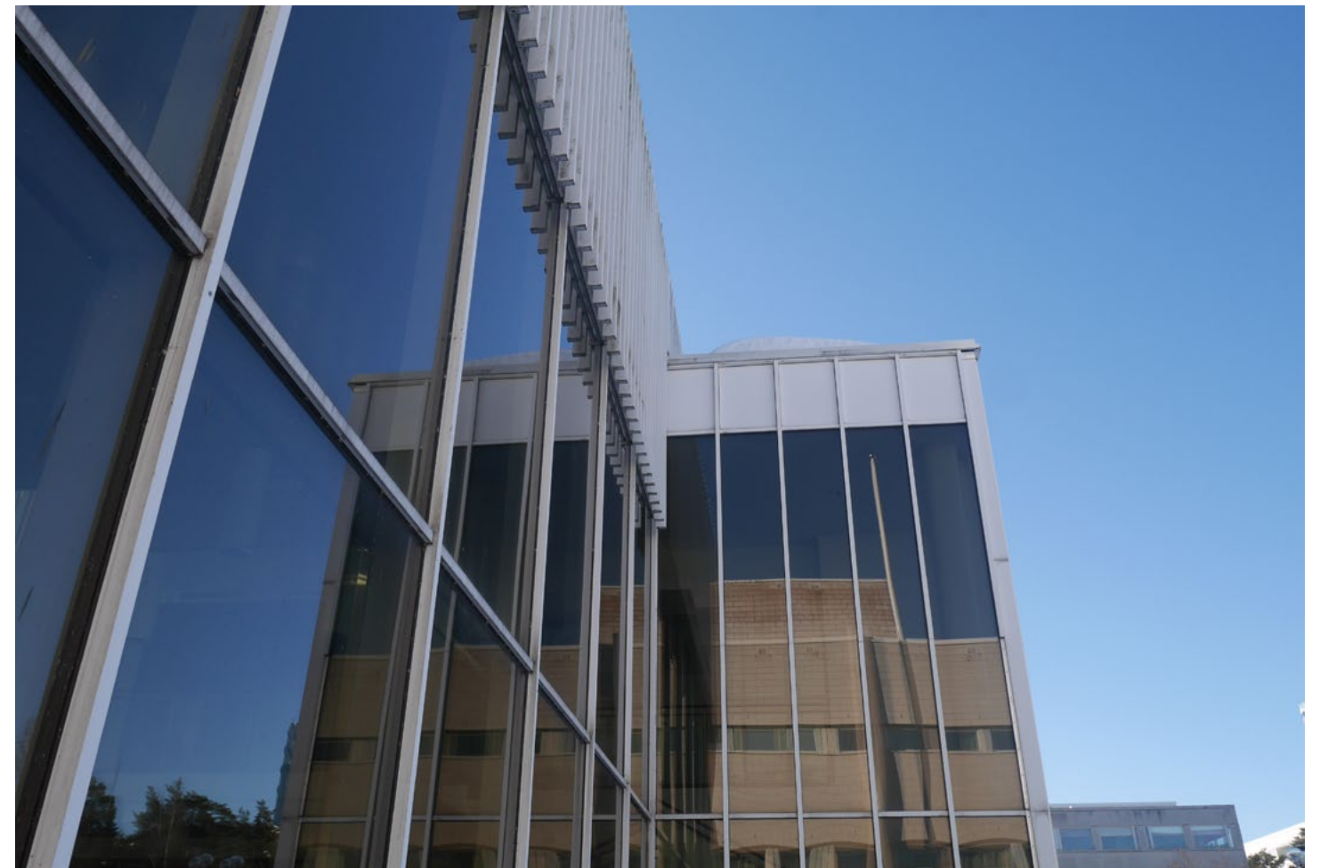
Lasijulkisivujen yläosassa on käytetty valkoiseksi maalatuista alumiiniprofiileista rakennettua, varjostavaa ritiläaihetta.
