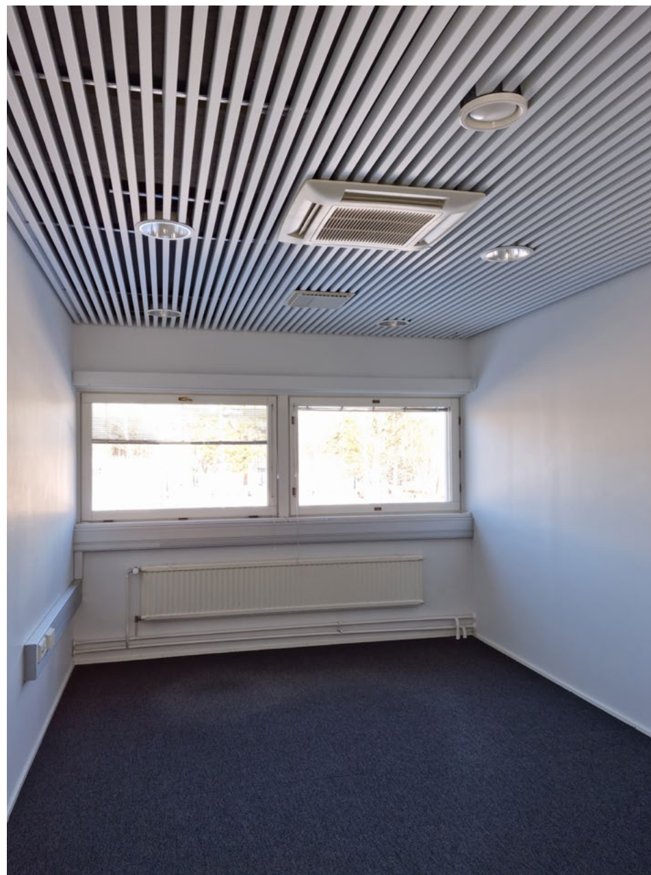
Alakattoja on uusittu ja muutettu tilamuutosten yhteydessä, muutamissa toimistotiloissa on vielä säilynyt Lautexin mallisto- toa edustava kevytmetallisälealakatto.
