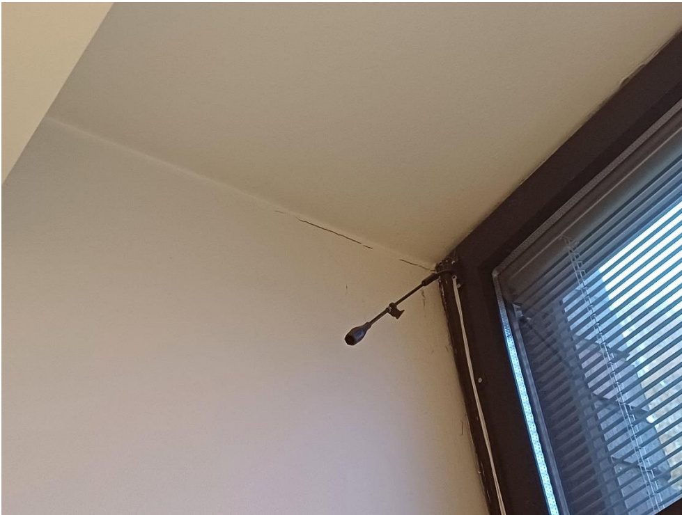
Kuva 4.1. 104 Inva-WC, rakenneliittymien ratkeamia.
