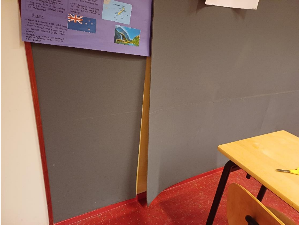
Kuva 4.1. H138 Opetustila, ilmoitustaulun pinta irtoilee liimauksesta.
