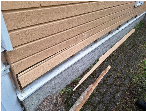
Kuva 15 US1, ulkoseinälaudan avaus tilan 67 kohdalla.
