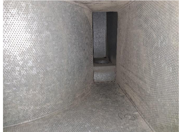
Kuva 57 Poistoilman äänenvaimennuskammiota.
