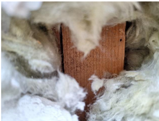
Kuva 17 Avaus osui pystykoolauksen kohdalle. Eristettä ennen koolauspuuta 50 mm, yhteensä noin 180 mm.
