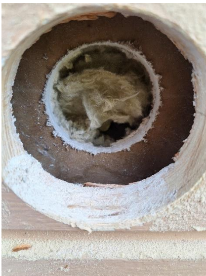
Kuva 27 Avaus tuulensuojalevyyn.
