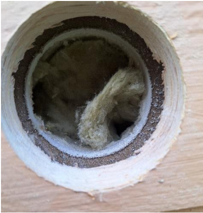
Kuva 21 Avaus tuulensuojaan. Eristettä noin 140 mm.
