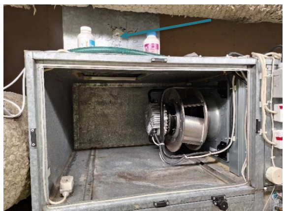
Kuva 53 Tuloilmapuhallin oikealla kammioista katsottuna.
