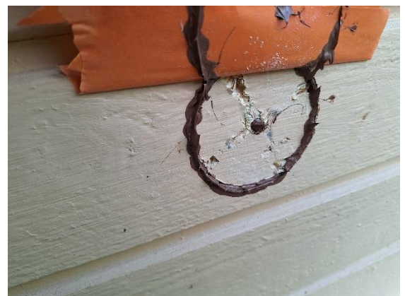
Kuva 30 Avauskohdan US2 paikkaus. US3 paikattiin samalla tavalla.
