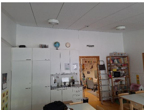
Kuva 47 Tilan 5 päätelaitteet.
