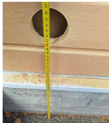
Kuva 24 Avaus tehtiin noin 550 mm maanpinnasta.
