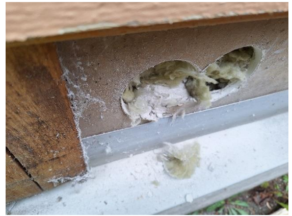
Kuva 16 Julkisivulaudan jälkeen on ilmarako ja tuulensuojalevy (gyproc).
