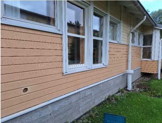
Kuva 19 US2, julkisivun avaus tilan 43 kohdalle. Avauskohta oli noin 900 mm maanpinnasta.
