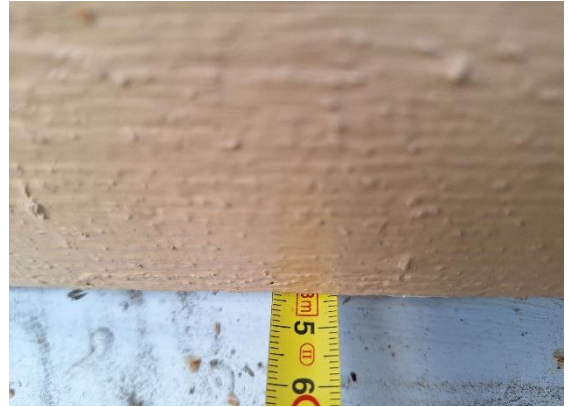
Kuva 14 Verhouslauta ja tuuletusrako ovat yhteensä 44 mm.
