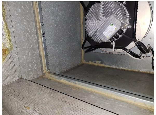
Kuva 53 Tuloilmapuhallin oikealla kammioista katsottuna.
