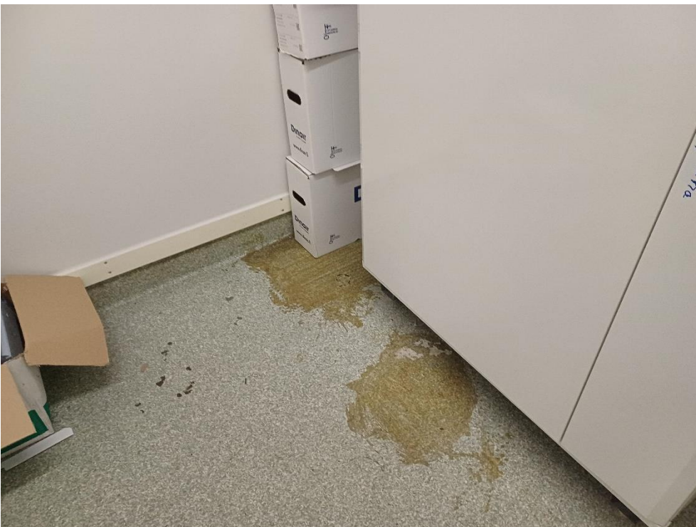
Kuva 4.25. Entinen talonmiehen as. IV-pakettikoneen luona lattiassa on liima tms. jälkiä.
