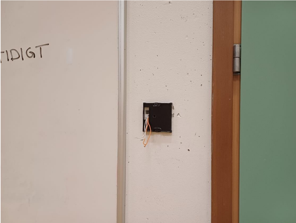
Kuva 4.10. 1158 Voimistelusal, heikkovirtarasian kansi puuttuu.
