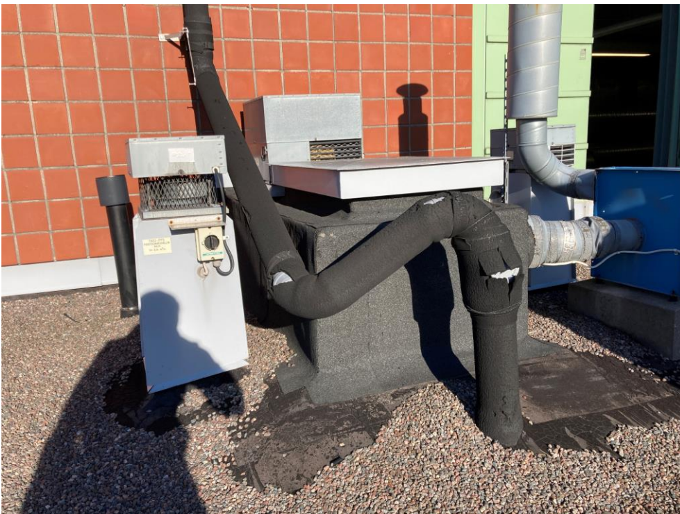
Kuva 5.3. Viemärin tuuletuksen mutka saattaa kerätä vettä alimpaan kohtaan.
