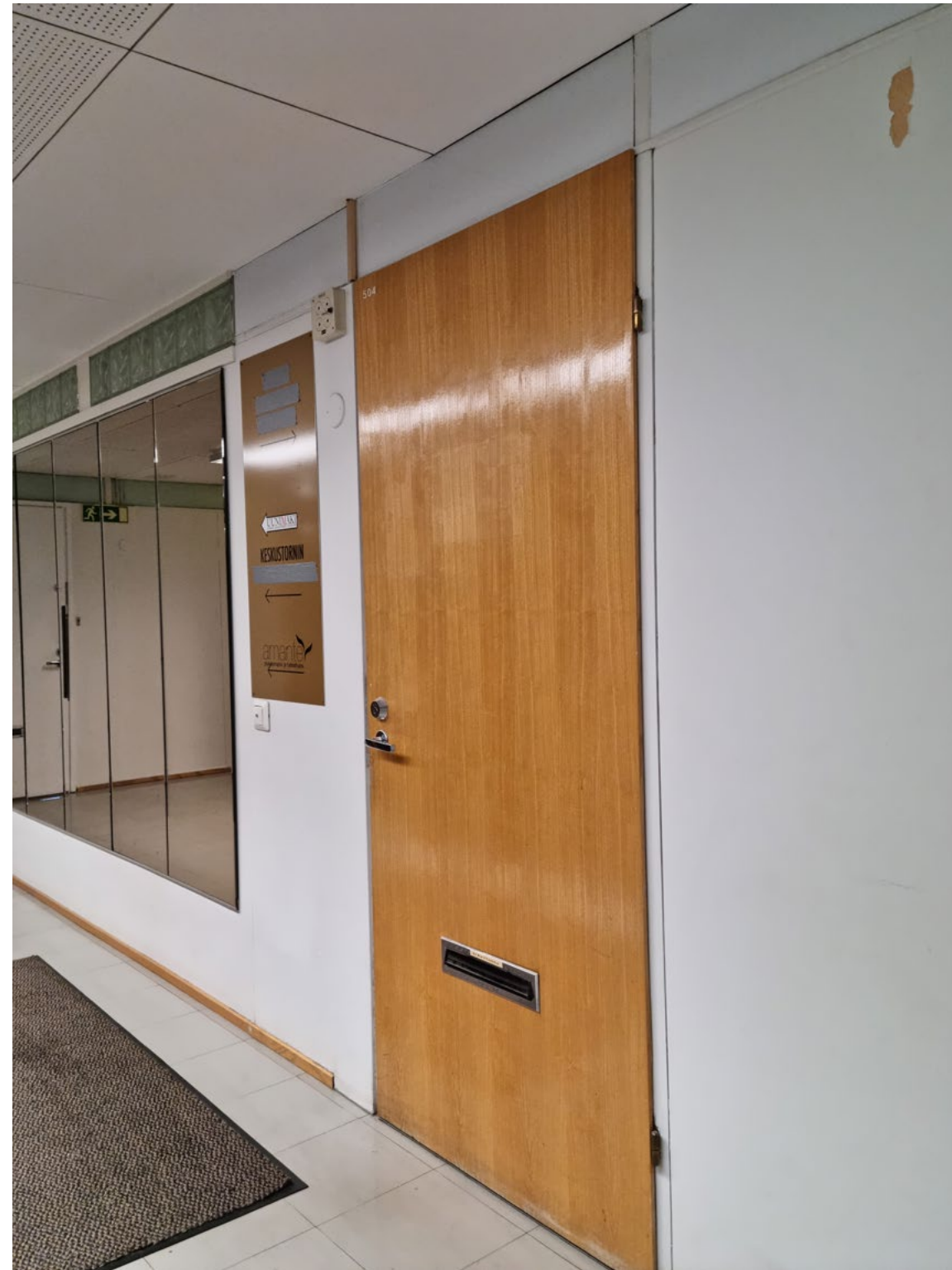
Käytävän oven alkuperäinen sovitus levyseinään ilman peitelistoja.
