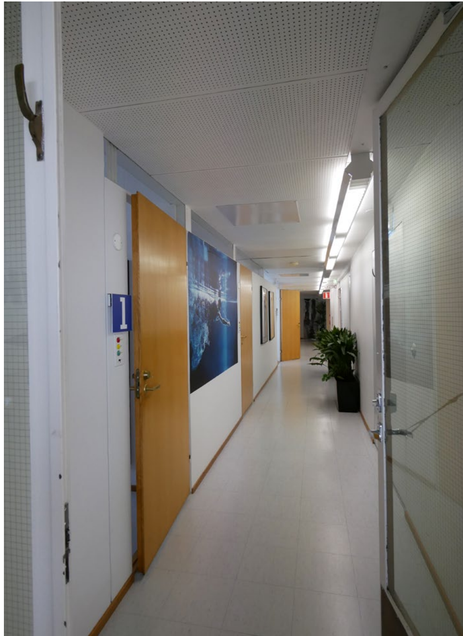
Ominaispiirteitään säilynyt käytävätila yläikkunoineen ja lakattuine ovineen. Lattiapäällysteenä on alkuperäinen vinyylilaatta.
