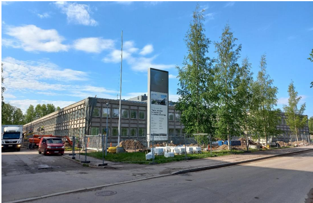
Rakennus kuvattuna pohjoisesta.
