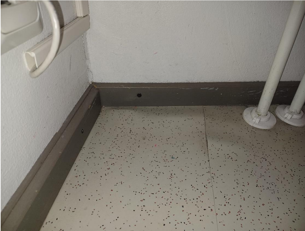
Kuva 4.5. A117 Tutkimus/Terapia, lattiapinnoite kupruilee paikoittain.
