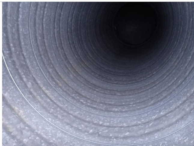
Kuva 3. Tuloilman runkokanavan sisäpinnasta otettiin kaksi geeliteippinäytettä (KK1 & KK2) mineraalikuitupitoisuuden määrittystä varten. Näytteiden mineraalikuitupitoisuudet olivat hyvin pieniä: 0,79 ... 1,07 kuitua/cm 2 .
