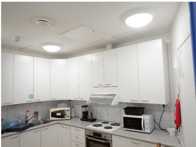
Kuva 14. Henkilökunnan keittiön / taukotilan 139 katossa on pieni alue akustioivaa kipsilevyrakennetta ja melko korkea alakattotila.
