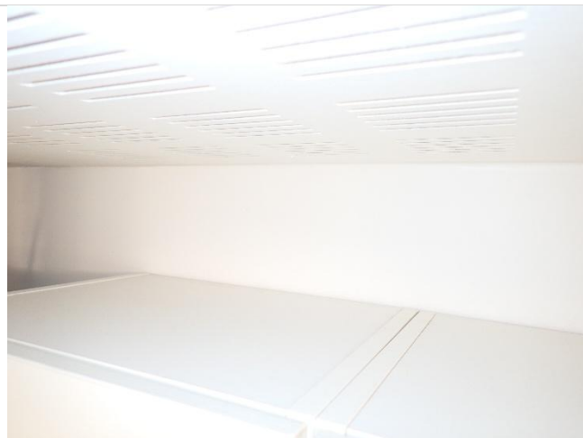
Kuva 15. Keittiötilan 139 kaapin päältä otettiin vanhasta pölystä koostumusnäyte (PP4). Näytteessä todettiin jonkin verran mineraalikuituja.
