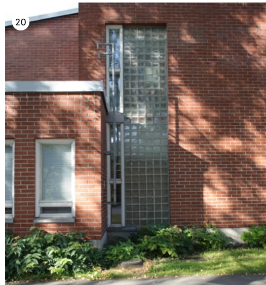
Siiven päässä on käytetty ikkunoiden ohella lasitiilikenttiä.
