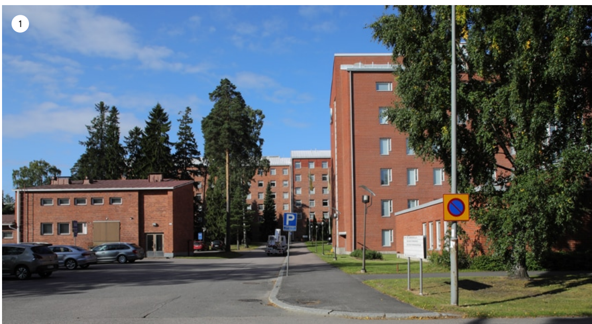
Betonimiehenkujalta on suora näköyhteys alkuperäiselle pääsisäänkäynnille. Nyt sen eteen on sijoitettu korkeat istutukset.
