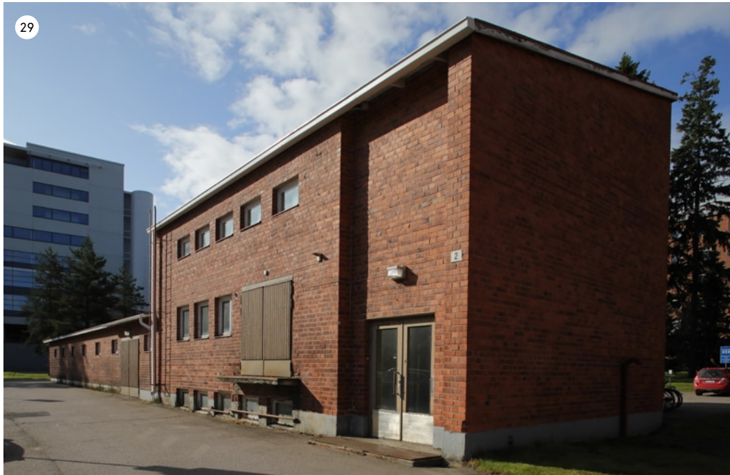
Autotallirakennuksen itäjulkisivulla on pieni lastauslaituri, josta on käynti alkuperäisiin huoltotiloihin. Kuvassa etualalla näkyy sisäänkäynti porrashuoneeseen, josta on käynti kellariin ja toisen kerroksen varasto- ja asuintiloihin. Asuintilojen nykykäytöstä ei ole tietoa, tiloihin ei ollut inventoinnin yhteydessä pääsyä.
