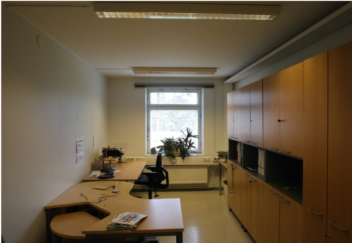
Huoneiden pintamateriaalit on uusittu eri vaiheissa. Ikkunat ovat alkuperäiset puuikkunat.
