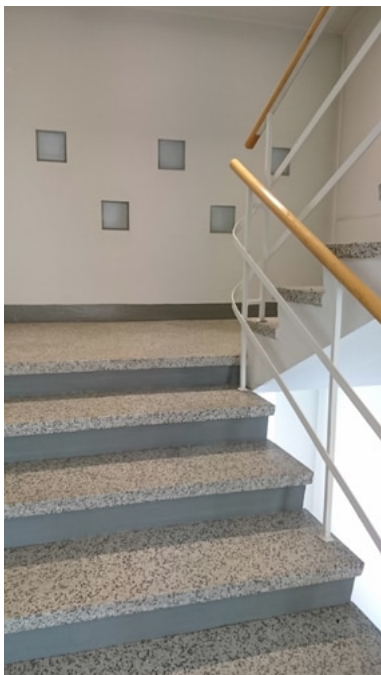
B-portaan ylimmällä välitasanteella näkyvät julkisivun lasitiiliyksityiskohdat.
