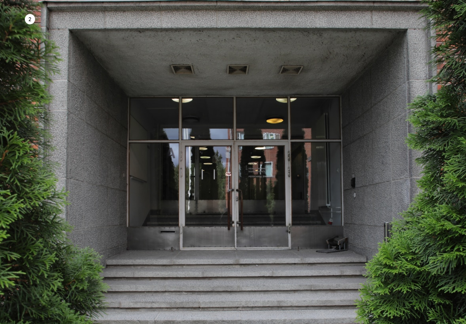
Alkuperäinen pääsisäänkäynti on päällystetty ristiinhakatulla harmaalla graniitilla.
