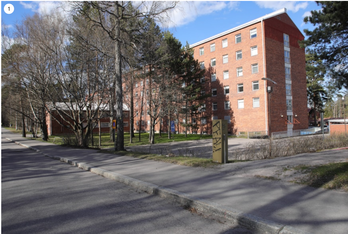
Ensimmäinen rakennusvaihe, näkymä Miestentien ja Kivimiehentien risteykseen.
