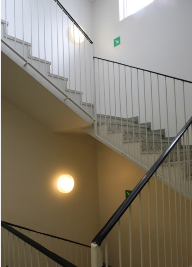
Kolmevartinen porras on elementeistä koottu betoniporras, jonka keskelle jää avoin tila.
