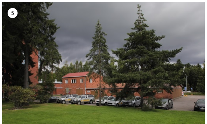
Autotallirakennus ja pysäköintialue kuvattuna lounaasta. Pysäköintialueen erottaa ensimmäisestä rakennusvaiheesta laaja nurmialue.
