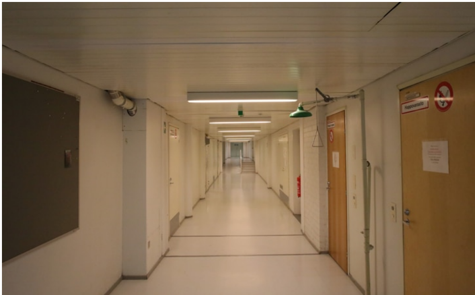
Myös kellarikerroksen tasolta on kulkuyhteys rakennuksen vanhempiin osiin. Siipien välinen tasoero on hoidettu luiskalla ja portaalla.
