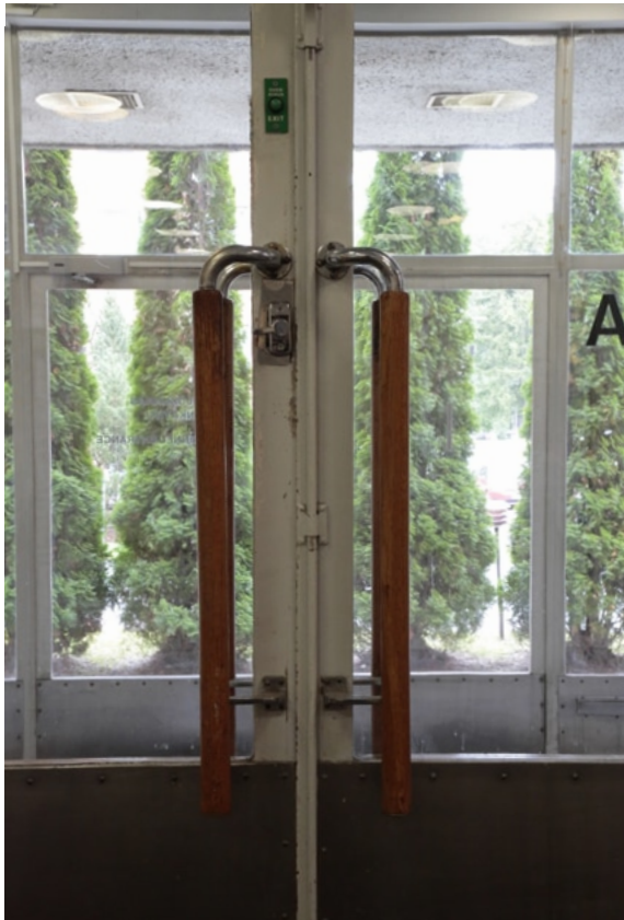
Pääsisäänkäynnin teräs-lasiovien vetimet ovat säilyneet alkuperäisinä.
