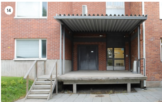
Lastauslaituri, josta on suora yhteys nivelosan porrashuoneeseen sekä tavarahissiin.
