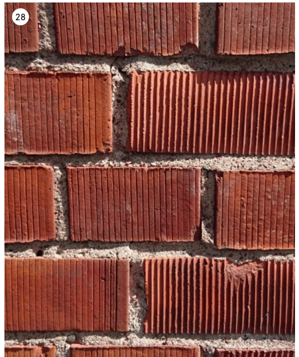
Tiilien pinta on harjattu. Kuva rakennuksen jatkoskohdasta, jossa erottuvat eriaikaiset tiilet.
