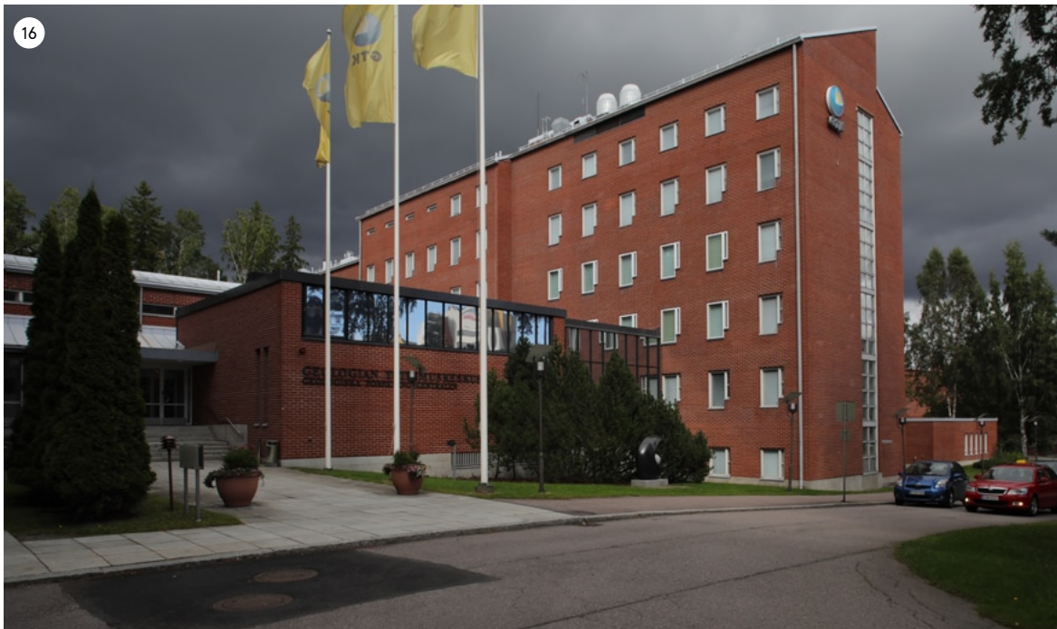
Kolmatta rakennusvaihetta dominoi korkea toimisto- ja laboratoriosiipi. Vasemmalla tutkimuslaitoksen nykyinen pääsisäänkäynti.
