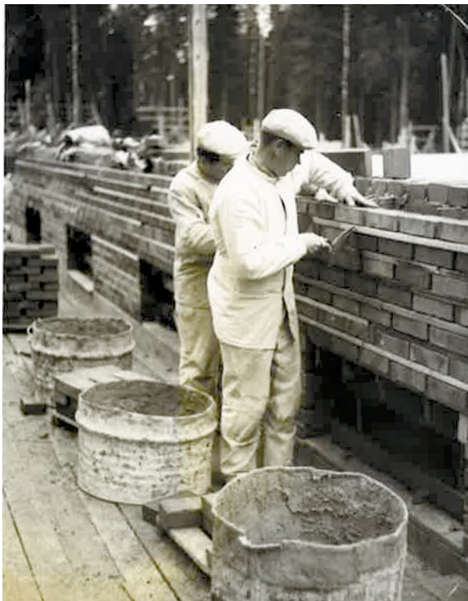
Ulkoseinän muurausta Geologisen tutkimuslaitoksen rakennustyömaalla 8.11.1954. Kuvaaja: Veikko Räsänen. GTKA.
