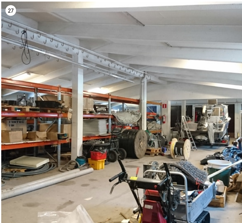
Autotallirakennuksen matalampi osa on varastokäytössä. Autotallin siro teräsbetoni-rakenne on hallitilassa selkeästi luettavissa.
