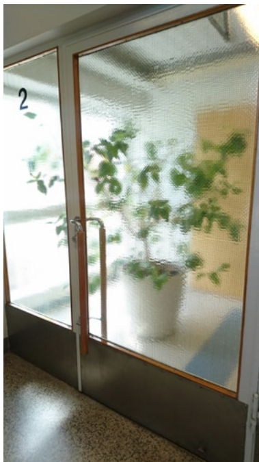
Porrashuoneen lankalasiovet ovat alkuperäiset.
