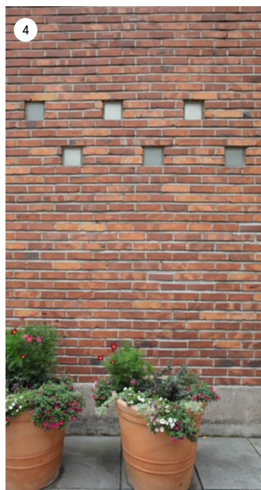
Lasitiiliyksityiskohta vanhan pääsisäänkäynnin vieressä.
