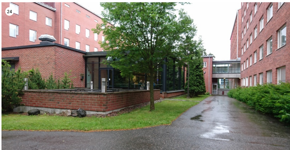
Rakennuksen pohjoispuolelle rakennettiin henkilökuntaruokalan ja keittiön sisältävä laajennus, joka valmistui 2004.
