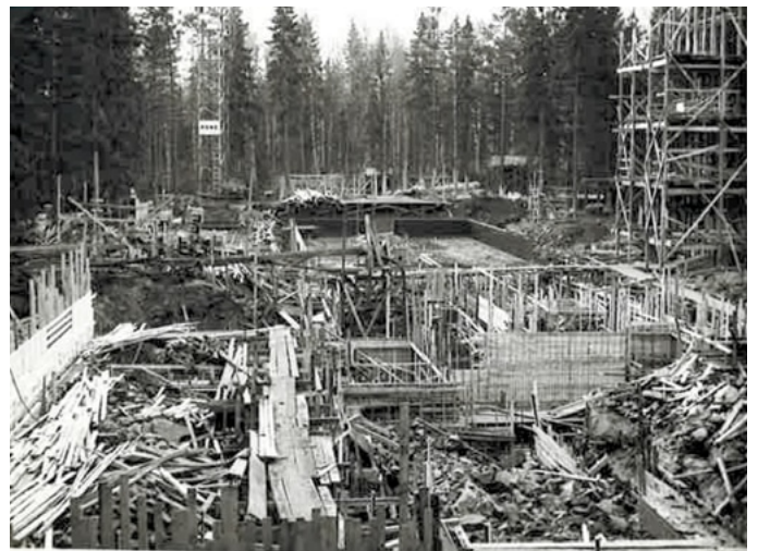
Näkymä työmaan pohjoispäästä katsoen lokakuussa 1954. GTKA.
