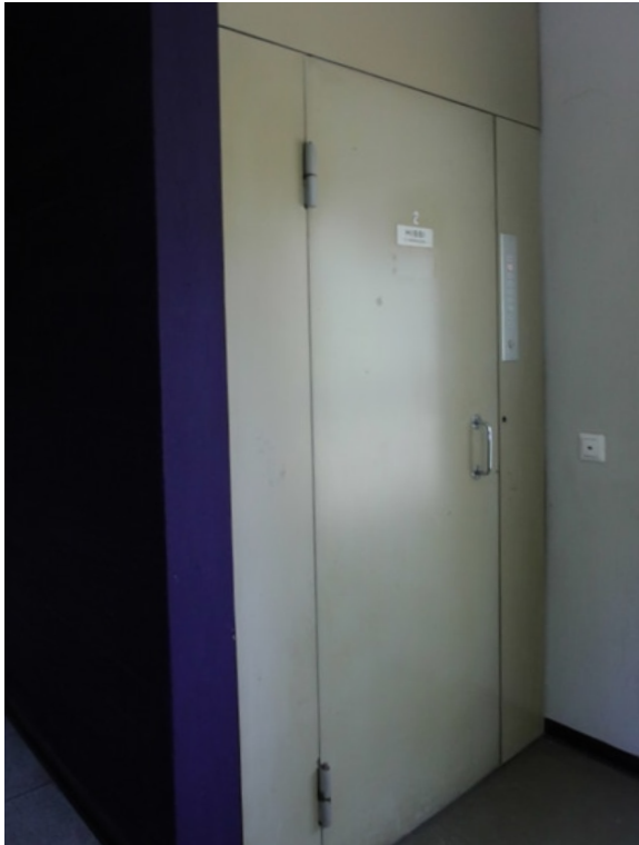
Laajennusosan pohjoispäässä sijaitsevan B-porrashuoneen alkuperäinen henkilöhissi.
