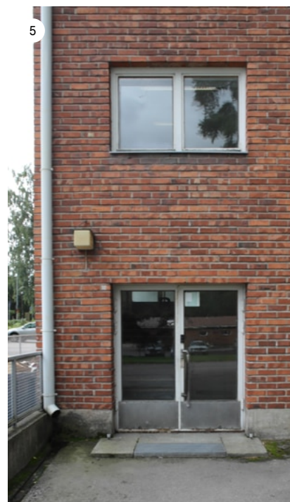
B-portaan sisäänkäynti on arkinen teräslasipariovi.
