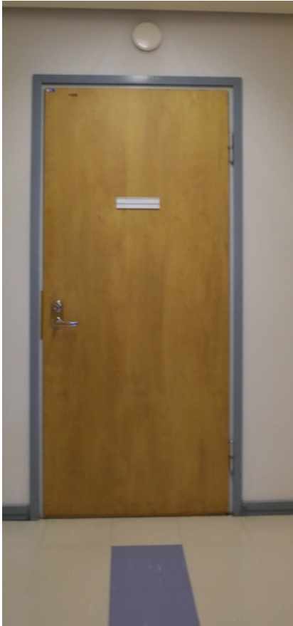
Alkuperäinen puuviilulaakaovi, joka on varustettu sinertävillä ovilistoilla.
