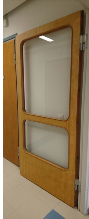
Alkuperäinen puu-lasipariovi toisen kerroksen käytävällä.
