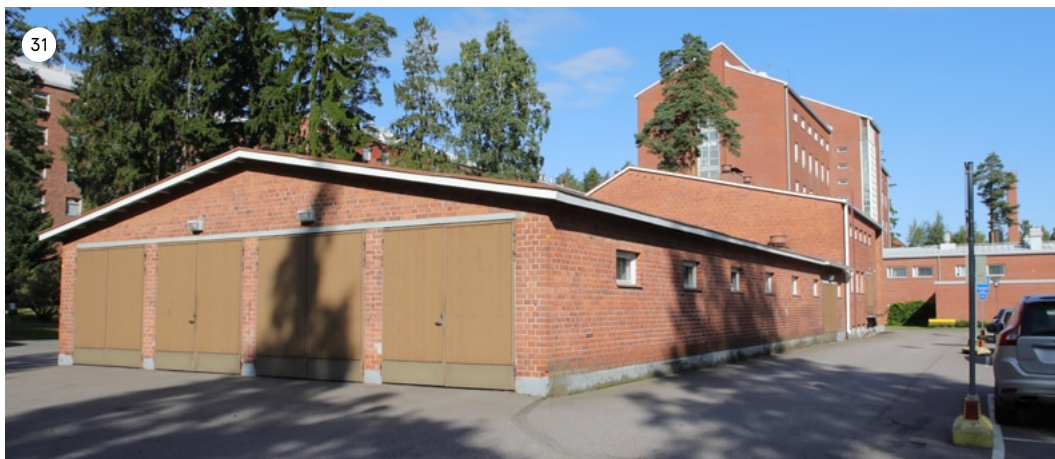
Autotallirakennus on ulkohaamoltaan horisontaali ja sen loiva satulakatto noudattelee tutkimuslaitosrakennuksen vanhimman osan kattoratkaisua.
