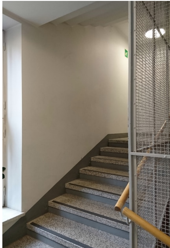
Pääporras on päällystetty mosaiikkibetonilla.
