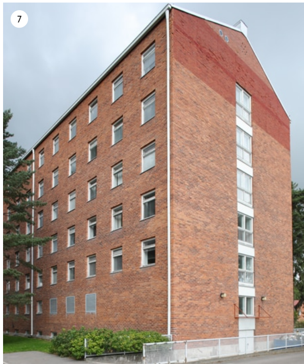
Rakennuksen eteläpääty. Arkistotilojen umpeen rakennetut ikkunat näkyvät julkisivussa alinna.
