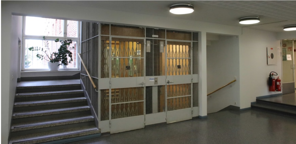
Rakennuksen alkuperäinen pääporrashuone, jossa kolmivartinen pääporras kiertää teräsverkolla muusta tilasta erotettua hissikuilua. Porrashuonetta ja aulatiloja valaisee ajalle tyypillinen epäsymmetrinen ikkunakenttä.
