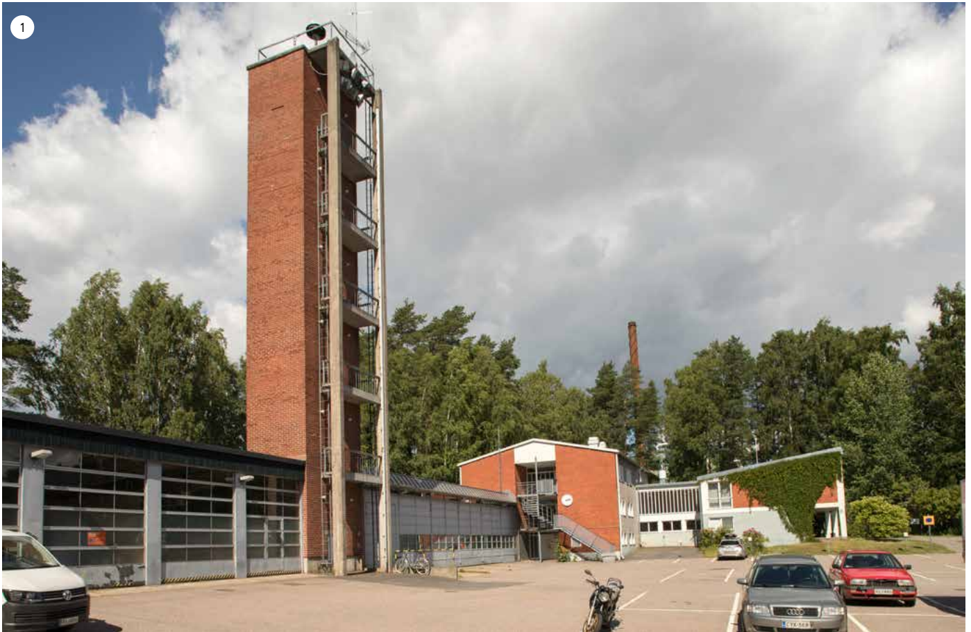
Vuonna 1956 valmistuneeseen palokoulurakennukseen kuuluivat letkunkuivaustorni (purettu), kalusto- ja autohalli (kuvassa tornista oikealle, korotettu 1996), majoitussiipi ja sisäänkäyntisiipi. Majoitussiiven päähän lisättiin poistumisporras vuoden 1996 korjaustöiden yhteydessä.
