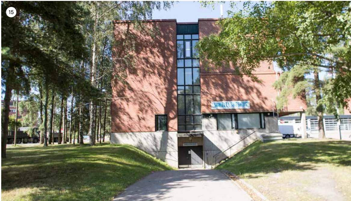
Kivimiehentieltä johtaa suora ajoluiska kellaritason sisäänkäynnille. Julkisivun keskilinjan korkea ikkunakenttä on 1.–4. kerrokset yhdistävän B-portaan kohdalla.
