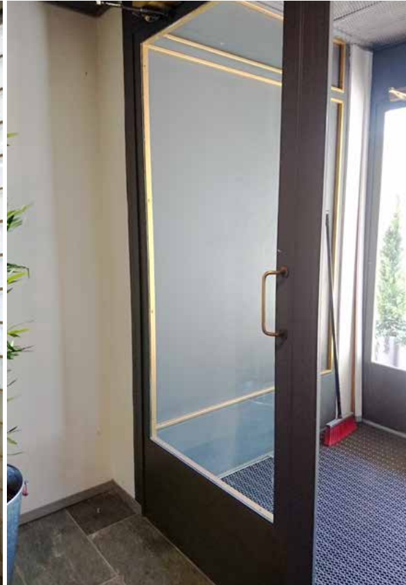
Alkuperäiset teräs-lasiovet ovat rakenteeltaan hyvin sirot.
