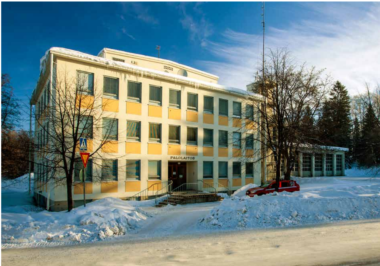
Heinolan poliisi- ja paloasema (1952) edustaa tyypiltään virastotalon ja paloaseman yhdistelmää, siinä missä Valtion palokoulu suunniteltiin opiston ja paloaseman yhdistelmäksi. Kuitenkin rakennusosien massoittelu ja suhde toisiinsa muistuttaa toisiaan. Pertti Bruun.
