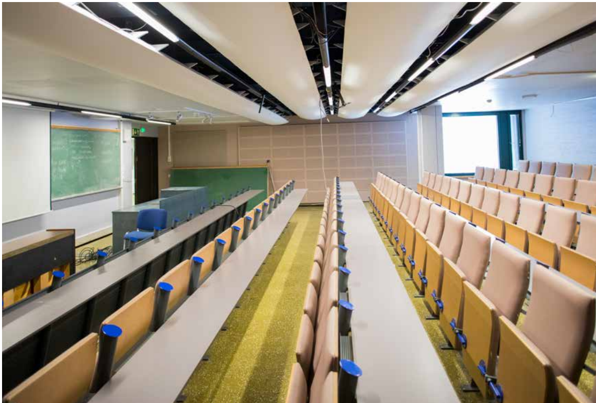
Auditorion ilmanvaihtojärjestelmä ja alakatto on uusittu 1990-luvulla. Lattia on alkuperäinen.
