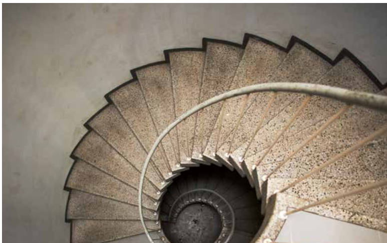
Kierreporras ulottuu kellarista toiseen kerrokseen. Kellarikerroksessa on varasto-tiloja.
