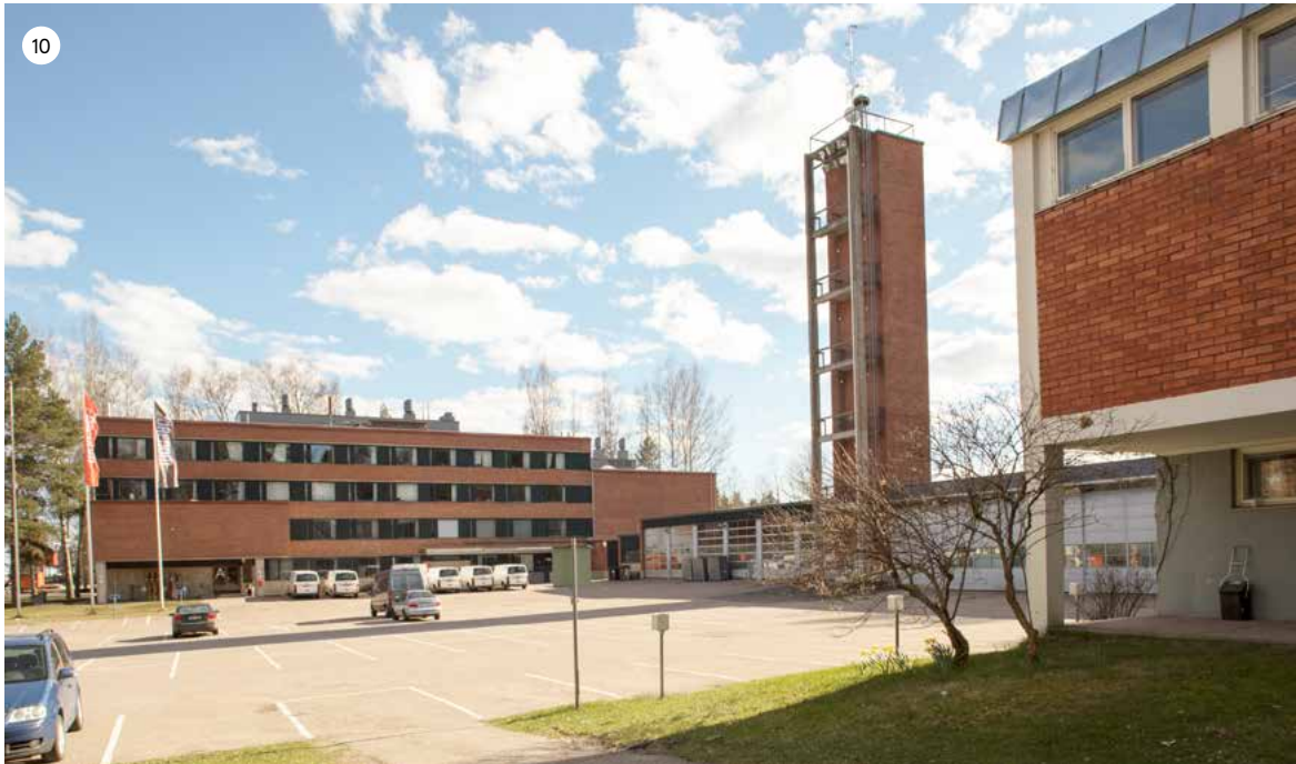
Vuonna 1972 valmistunut päärakennus sijaitsee ajopihaan eteläpuolella. Ajopiha on nykyisin pysäköintialueena.
