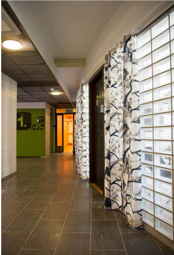
Aulan lattiamateriaali on uusittu. Aulan eteläosasta on erotettu huonetila lasitiiliväliseinällä (1995)
