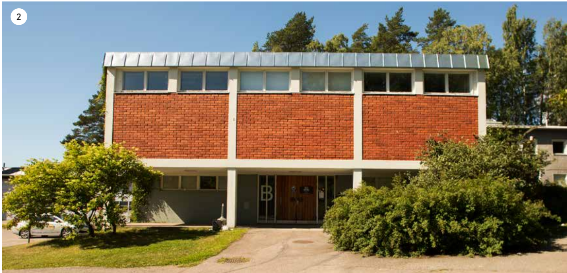
Sisäänkäyntisiiven päätyjulkisivu on muurattu betonirakenteen varaan.
