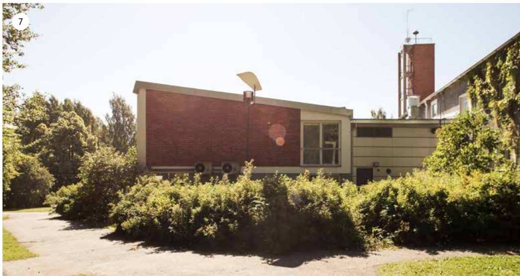
Sisäänkäyntisiiven pohjoispuolelle on rakennettu ilmanvaihtokonehuone vuonna 1996 (kuvassa oikealla).
