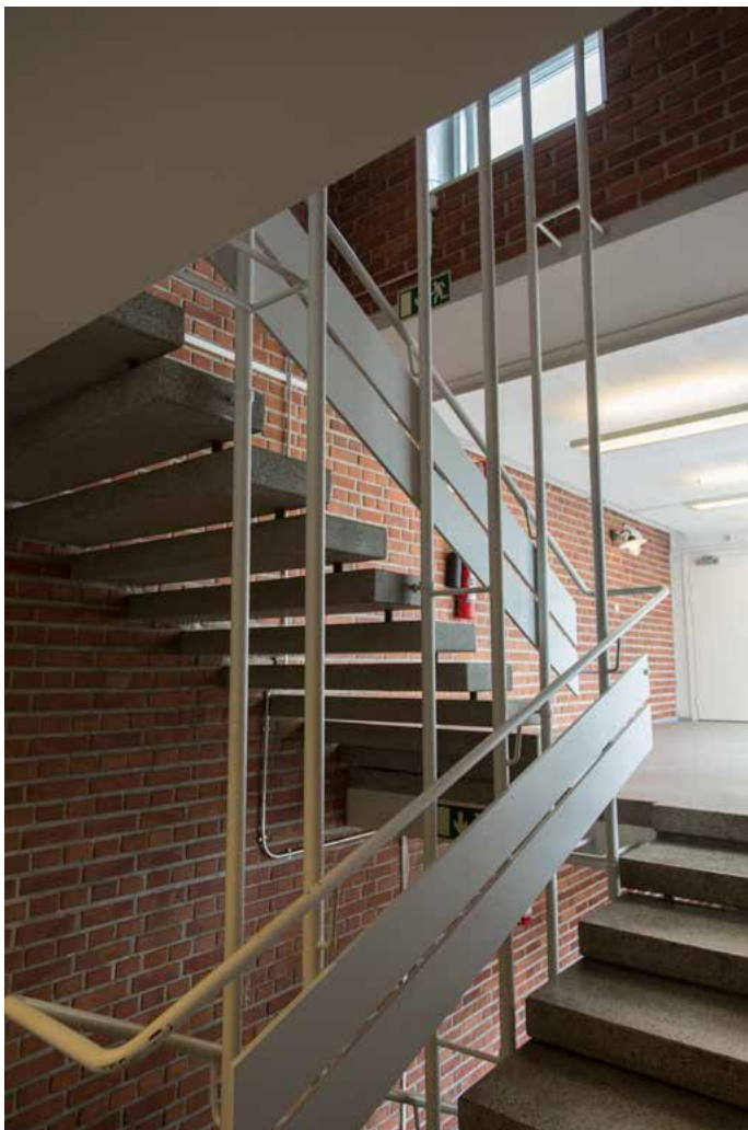
Pääporras on kaksivartinen avoin betoniporras, jonka huomiota herättävin piirre ovat pystyputket, joihin osa portaista sekä kaiteet tukeutuvat.
