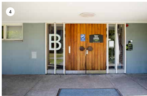
Pääsisäänkäynti on säilynyt alkuperäisenä. Sisäänkäynnin ylle työntyvät luokahuoneet muodostavat pääsisäänkäynnille katoksen.
