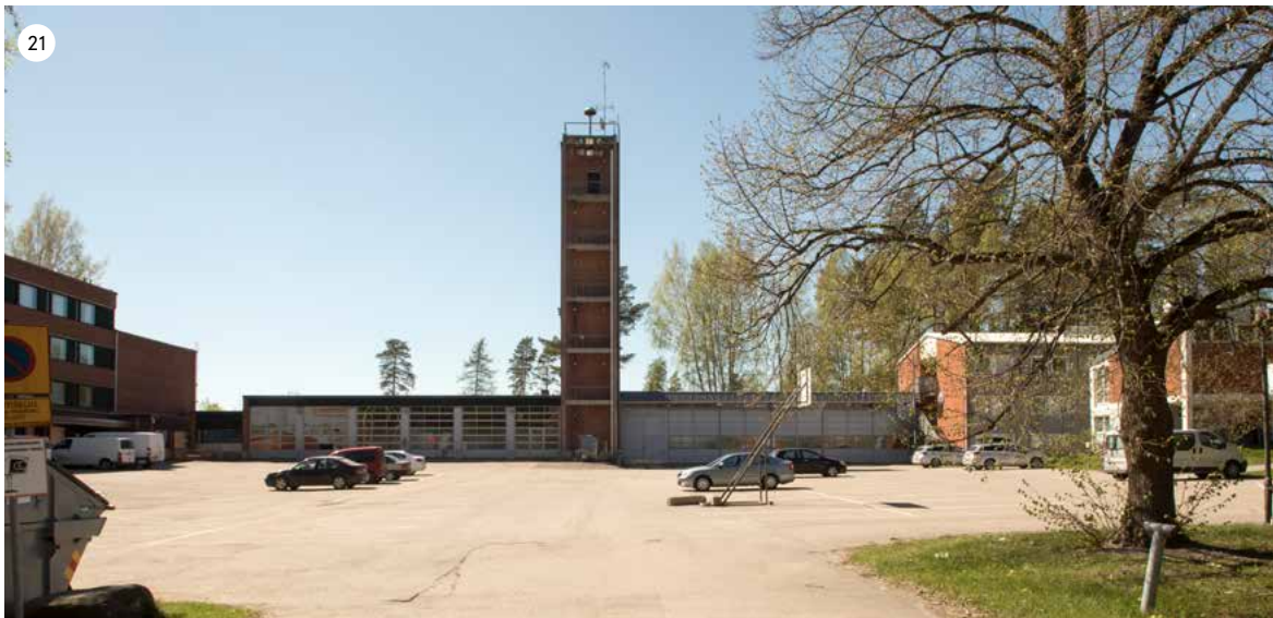
Entinen ajopiha, nykyinen paikoitusalue, avautuu itään. Eriaikaisten ajohallien keskellä on harjoituskäyttöön ja letkujen kuivaukseen rakennettu palotorni.
