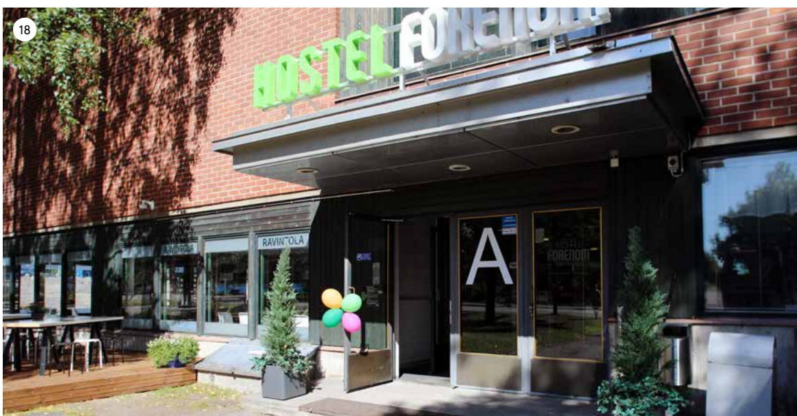
Päärakennuksen pääsisäänkäynti on säilynyt katoksineen alkuperäisenä. Katoksen rst-kasetit on uusittu. Ovet ovat sirot teräs-lasiovet, joiden välissä on kiinteä teräs-lasiseinä.
