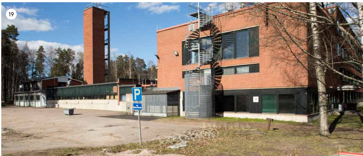
Päärakennuksen länsipäätyyn on lisätty poistumistieporras vuonna 1995. Sen takana näkyvät voimistelusalin ikkunat. Taustalla näkyvät 1950-luvun ja 1970-luvun auto- ja kalustohallit. Niiden takana on pysäköintialue. Inventointihetkellä viereinen tontti, entinen Poliisikoulun tontti, oli tyhjiällä.
