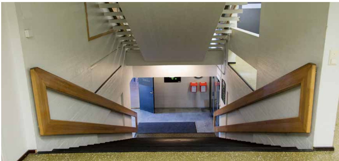
Pääportaan sivuseiniä on rakennettu umpeen, kun porrasta ympäröiviin aulatiloihin on rakennettu uusia huonetiloja.
