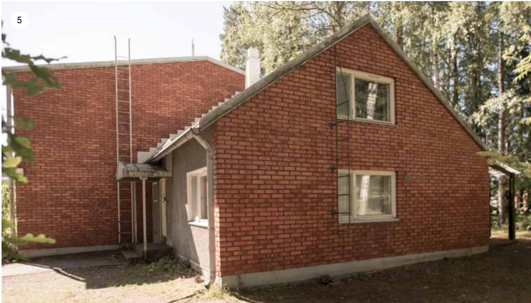
Majoitussiiven pohjoispäähän sijoitettu koulun johtajan asunto. Majoitusrakennuksen pitkät julkisivut jouduttiin kustannussyistä rappaamaan, mutta päätyjulkisivut ovat puhtaaksimuurattuja tiiliseiniä tummanpunaisella laasti-saumalla.
