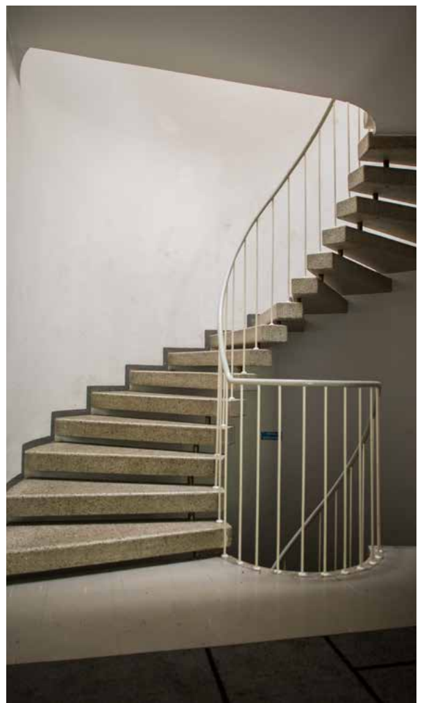
Portaan kaide koostuu metallisesta käsijohteesta, johon yhdistyvät sirot, poikkileikkaukseltaan pyöreät pystypinnat. Kaide on alkuperäinen.
