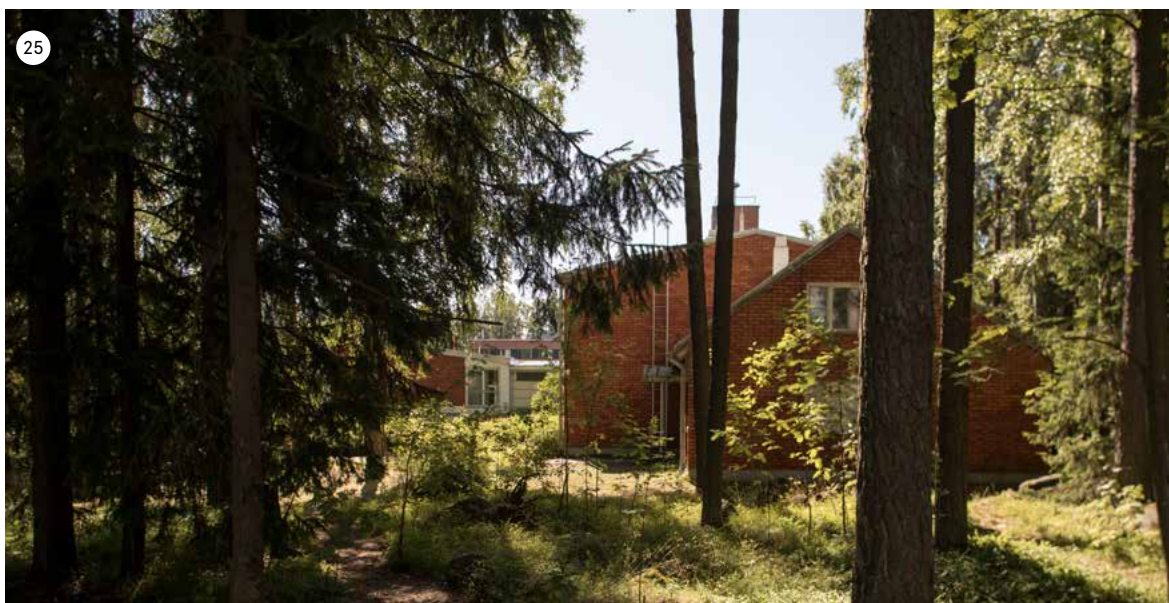
Asuinsiipi nähtynä pohjoisesta. Etualalla johtajanasunnon harjakattoinen hahmo.
