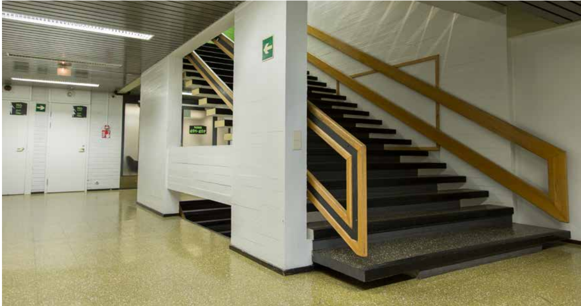
Toisen kerroksen porrastasolla hahmottuu portaan alkuperäinen, avonainen betonirakenne. Puista käsijohdetta kantaa metallirakenne.
