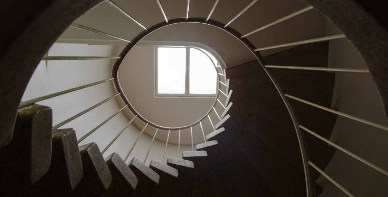
Porrashuone saa valoa kattoikkunasta, joka on uusittu vuoden 1996 korjaustöiden yhteydessä.
