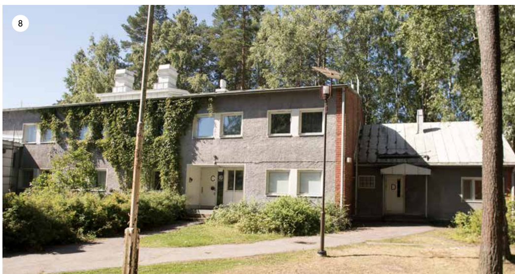
Majoitussiiven keskiosassa sijaitsevat alun perin henkilökunnan virka-asunnoiksi suunnitellut huoneistot. Sisäänkäynti niihin tapahtuu erillisen porrashuoneen kautta.
