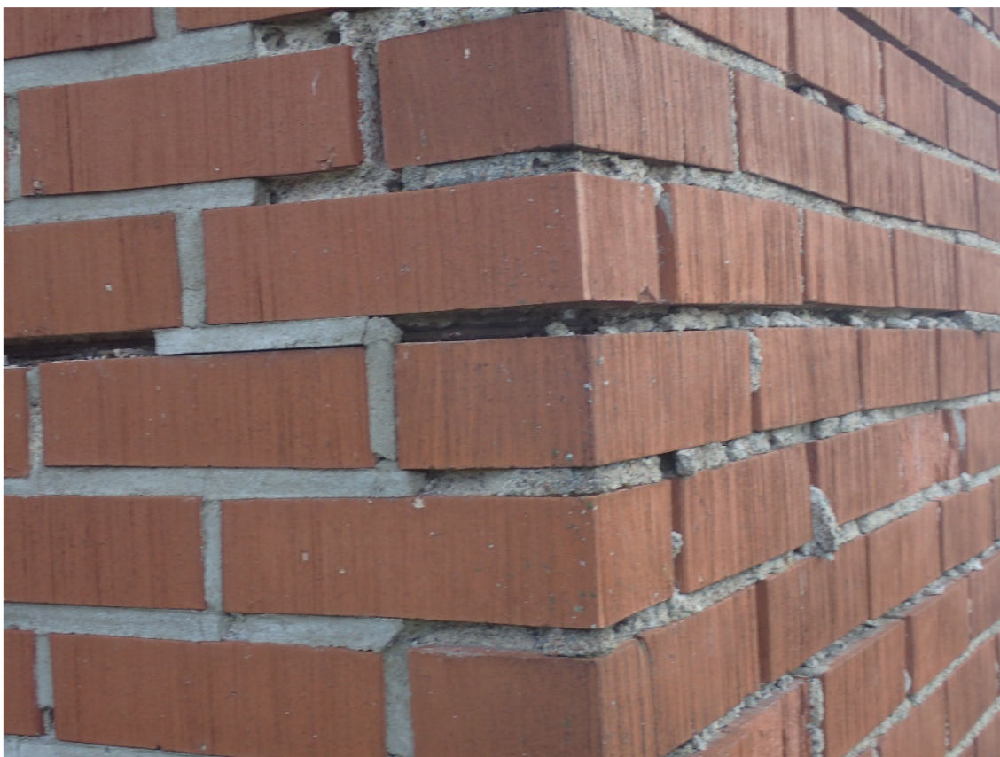
Kuva 10. Rengasteräkset eivät enää toimi kun tartuntaa laastiin ei ole.
