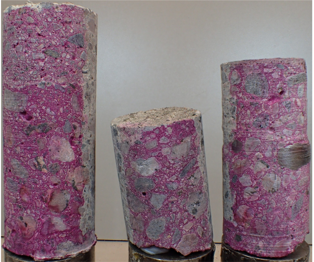
Kuva 23: Fenoliftaleiini-indikaattorilla käsitellyt parvekenäytteet, indikaattori värjää karbonatsoitumattoman betonin pinkiksi / lilaksi. Vasemmalla laatta, keskellä pilari ja oikealla palkki. Karbonatsoitumissyvytydet olivat pieniä.
