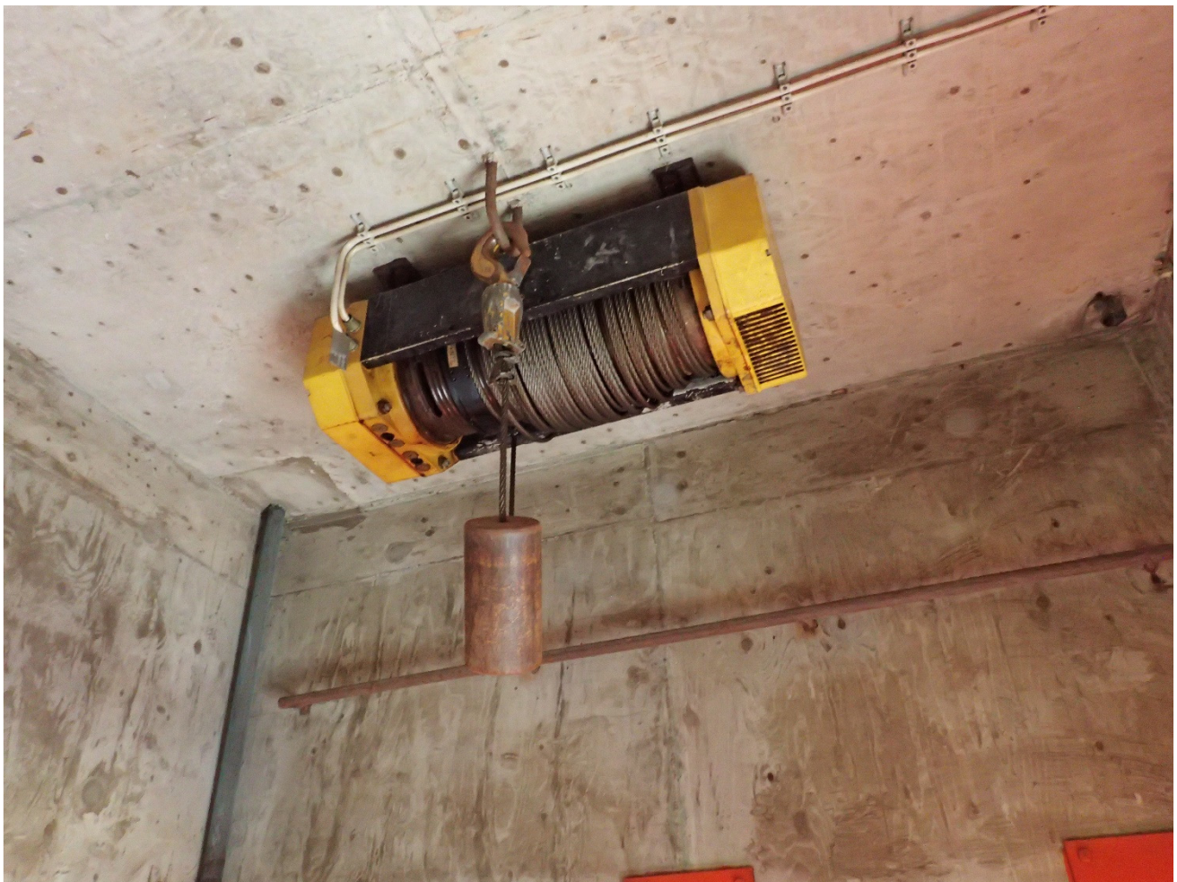
Kuva c. Tornin katossa oli sähkövinssi. Betonikatossa ei ollut merkkejä vuodoista. Vesikaton "syöksytorvi" näkyy nurkassa.
