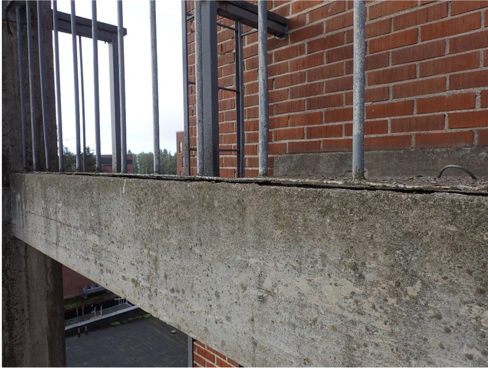
Kuva 21. Pinnakaiteen alatanko ei ollut enää kiinni reunapalkin tartunnoissa.
