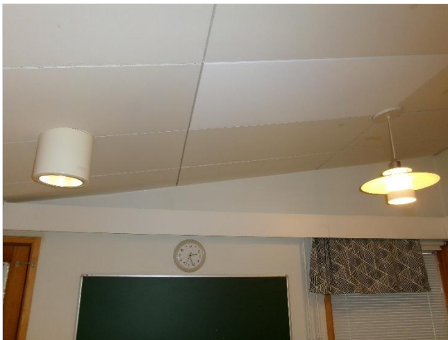
Kuva 1. Ryhmätilojen kattoihin on liimattu akustolevyjä, joissa on maalattu lasihuopapinta.
