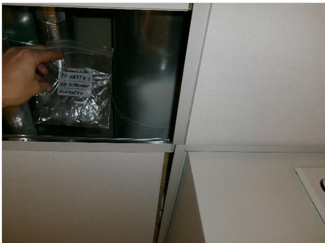
Kuva 20. Tilasta 20 eteinen otettiin pölyn pyyhintänäyte alaslasketujen kattojen yläpuolisesta tilasta.
