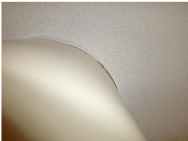
Kuva 4. Valaisimia varten tehtyjen leikkauspintojen käsittelystä ei saatu varmuutta pienen raon takia.
