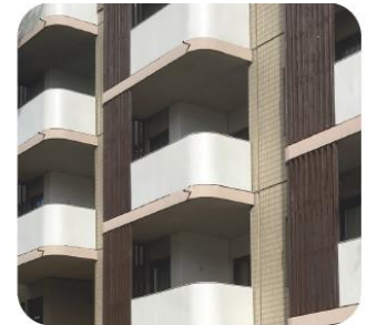
1960-70-luvun vaihteen kaupunkirakenne ja arkkitehtuuri
