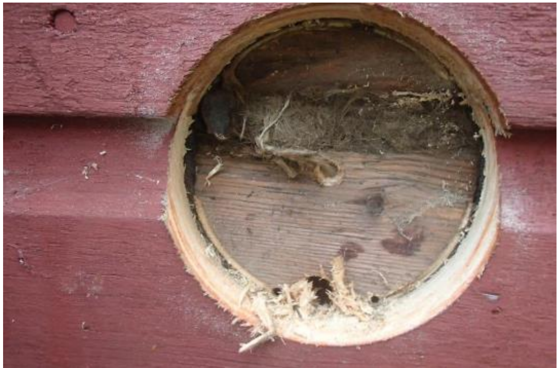
Kuva 2. Rakenneavaus J3 ulkovaipparakenteeseen.
