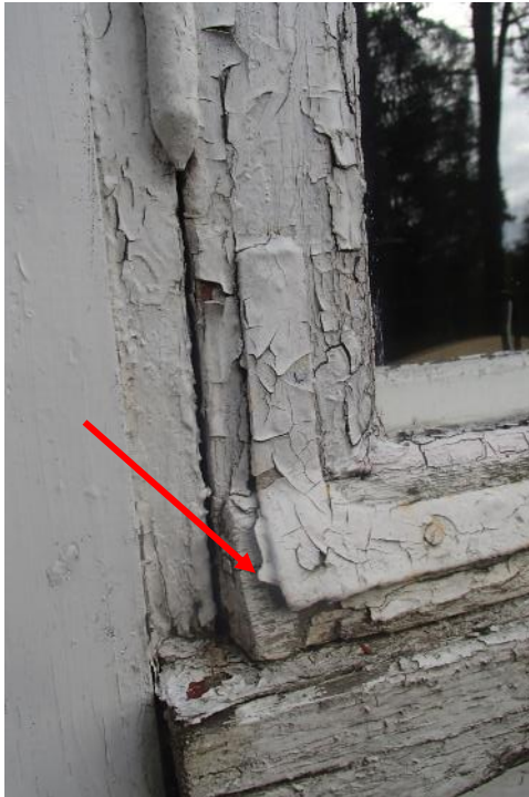
Kuva 49. Ikkunarakenteiden ulkopinnoilla havaittiin maalipintojen irtoilua, halkeilua ja hilseilyä sekä kulmaraudat ovat irti puupinnasta.
