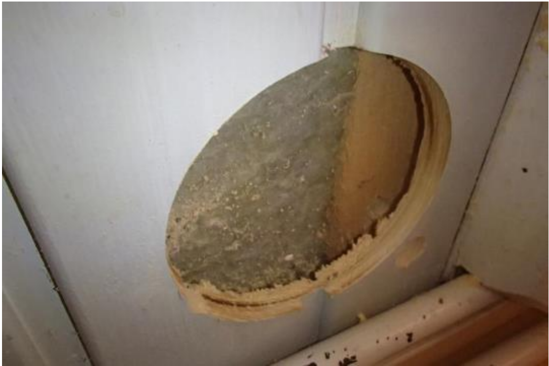
Kuva 6. Rakenneavaus SJ3 ulkovaipparakenteeseen sisäkautta suoritettuna.
