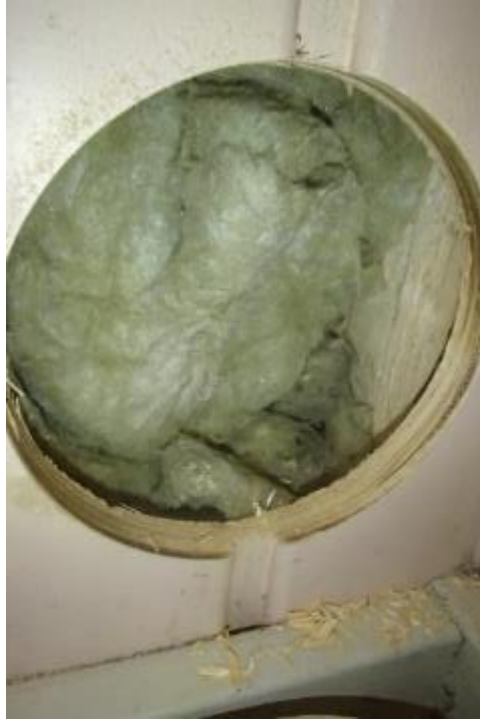
Kuva 5. Rakenneavaus SJ2 ulkovaipparakenteeseen sisäkautta suoritettuna.
