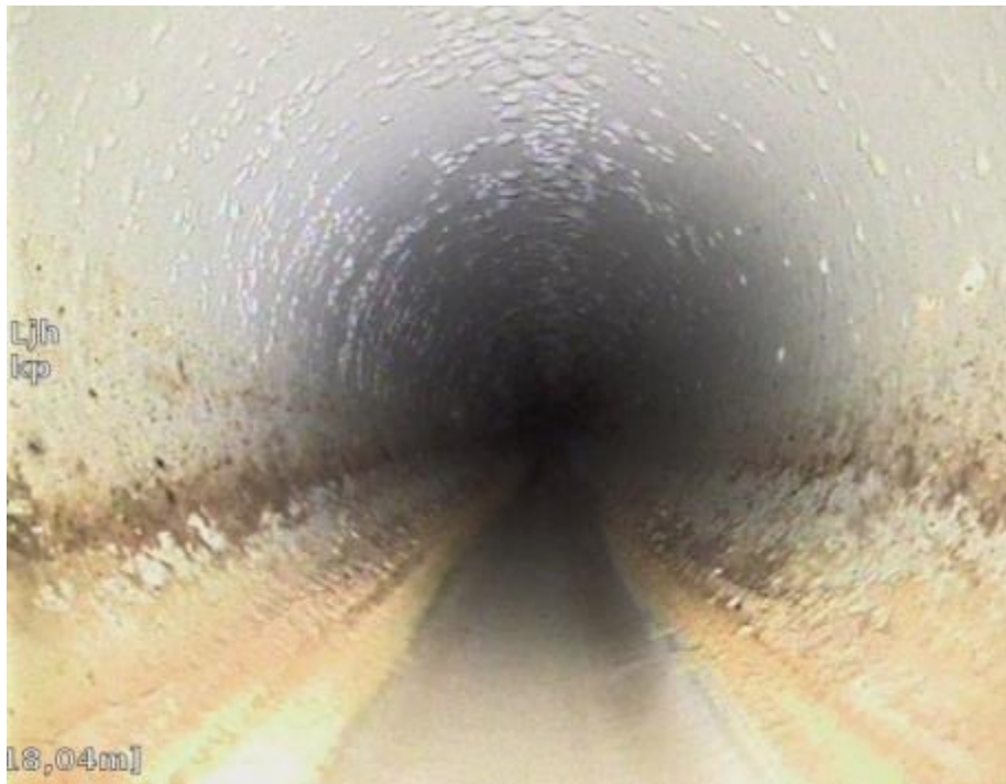
Kuva 125. Lämmönjakohuoneen linjaston kuvaus päättyi 18,04 metrin kohdalle. Linjasto rakennuksen ulkopuolella.
