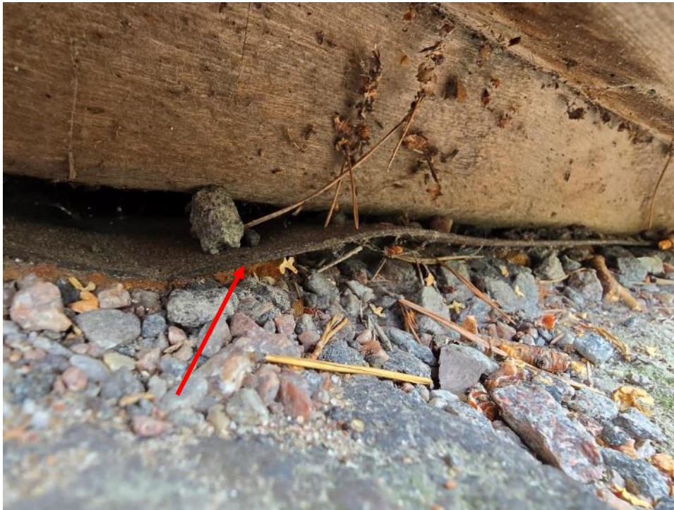
Kuva 37. Hirsirungon ja luonnonkivisokkelin välissä havaittiin bitumikermikaistaleet.
