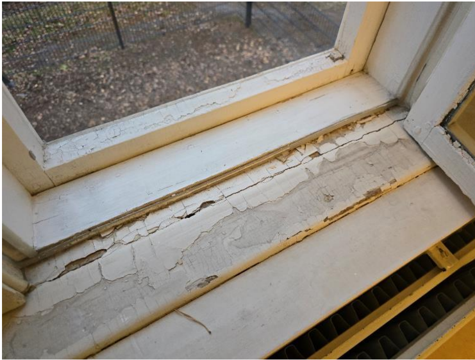
Kuva 59. Ikkunarakenteiden sisäpinnoilla havaittiin maalipintojen irtoilua, halkeilua ja hilseilyä.
