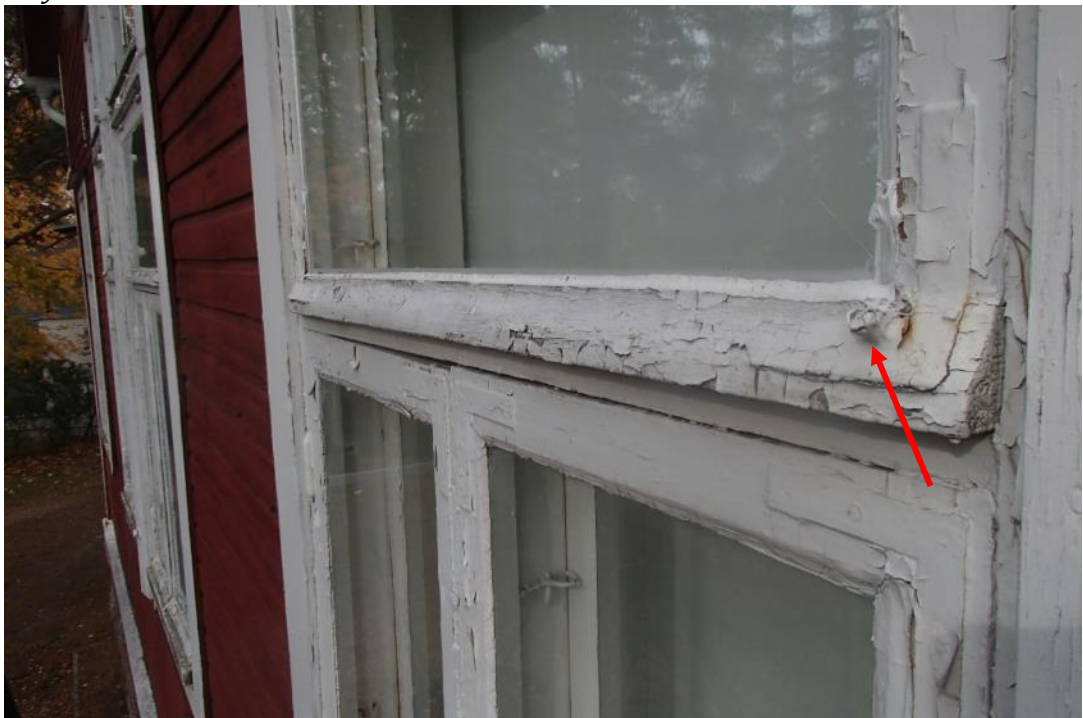
Kuva 48. Ikkunarakenteiden ulkopinnoilla havaittiin maalipintojen irtoilua, halkeilua ja hilseilyä sekä kulmarautojen kiinnitysnaulat ovat kulkeutuneet ulospäin.
