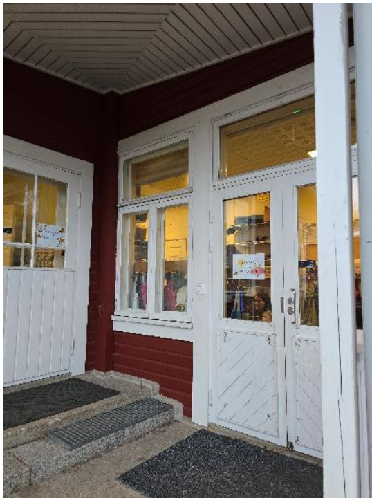
Kuva 80. Pääsisäänkäynnin ovet on uusittu.
