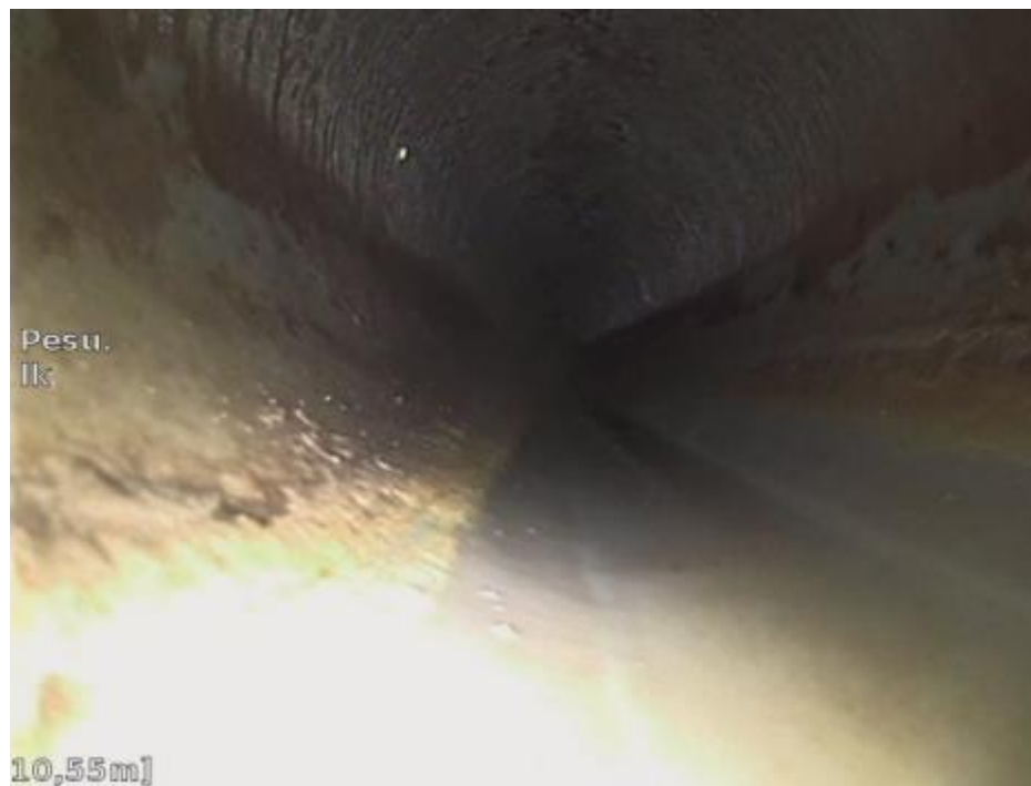
Kuva 122. Poikkeamia ei havaittu.
