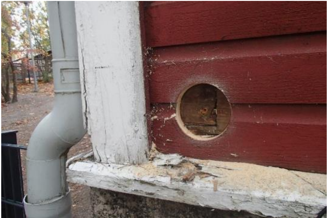
Kuva 3. Rakenneavaus J7 ulkovaipparakenteeseen.
