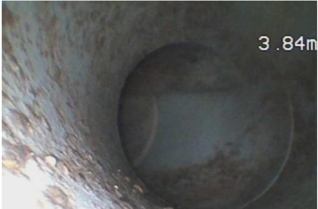
Kuva 115. Henkilökunnan pukuhuoneen suihkuhuoneen pohjaviemäreissä ei havaittu poikkeamia. Kuvaus päättyi 3,84 metrin päähän kaivolta.
