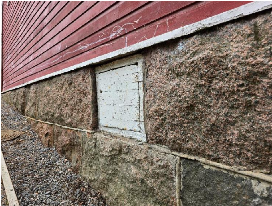
Kuva 107. Sokkelissa on tuuletusluukkuja.
