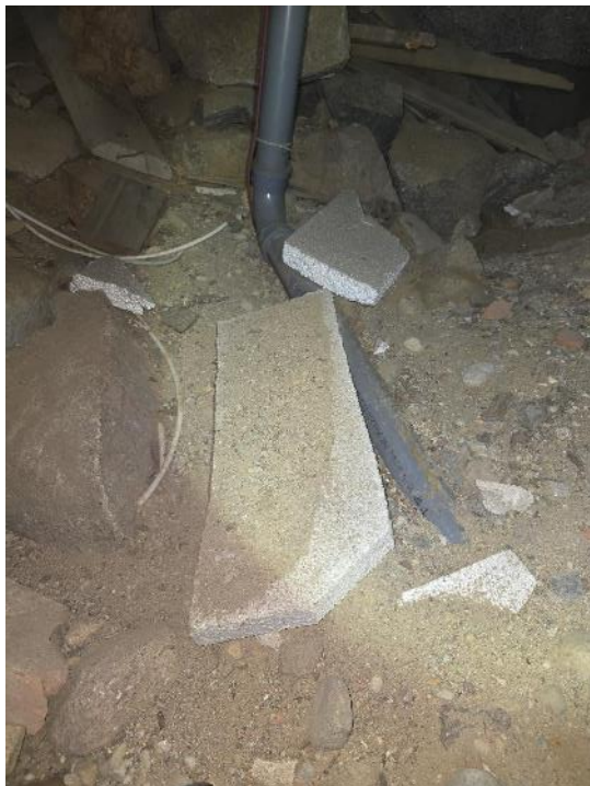
Kuva 96. Ryömintätilassa havaittiin ylimääräistä jätettä ja puumateriaalia sekä viemäriputkia ei ole eristetty, mutta muoviputkissa on saattolämmitykset.
