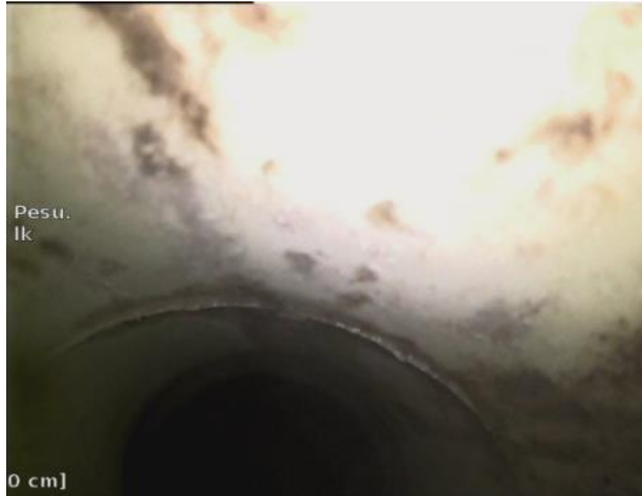
Kuva 121. Pesuhuoneen pohjaviemäreissä ei havaittu poikkeamia.
