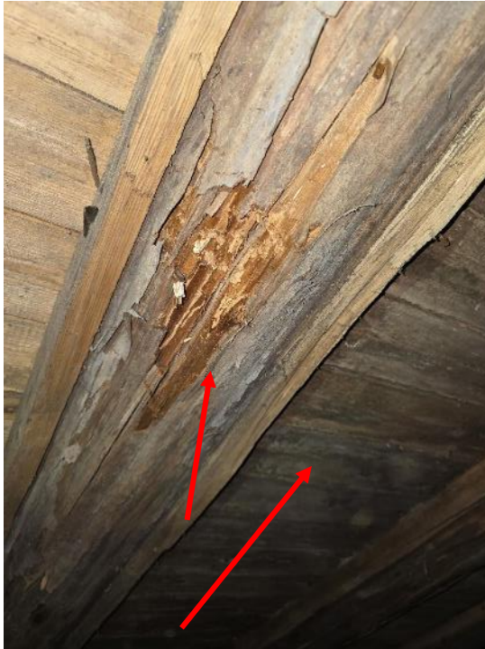
Kuva 101. Alapohjan runkokuissa havaittiin lahovaurioita sekä alalaudoitusten alapinnoilla on tummaa mikrobikasvustoa.
