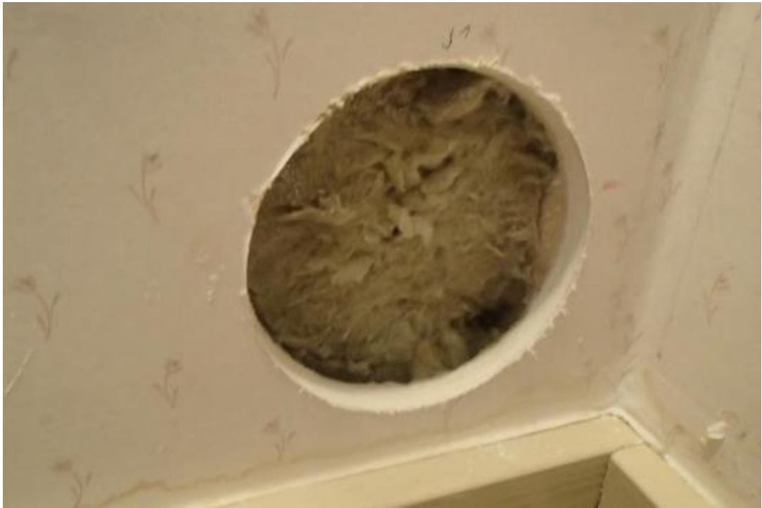
Kuva 4. Rakenneavaus SJ1 ulkovaipparakenteeseen sisäkautta suoritettuna.
