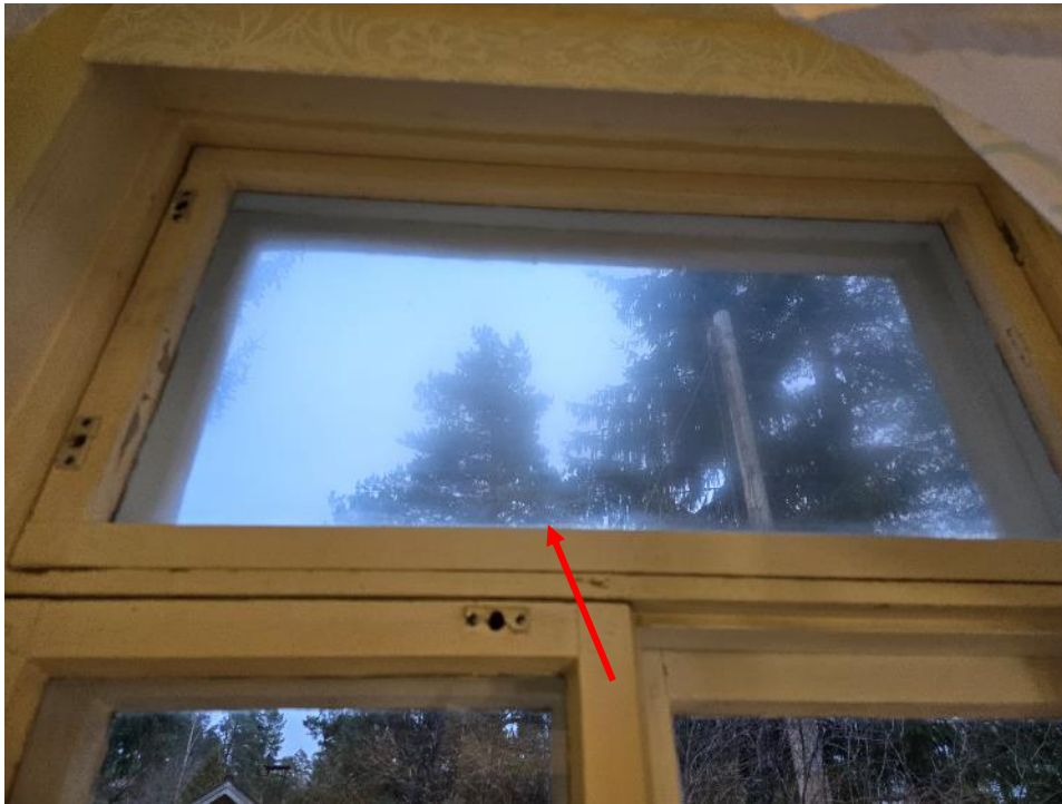
Kuva 77. Paikoin ikkunoiden välitilaan kondensoituu kosteutta puutteellisen tuuletuksen seurauksena.
