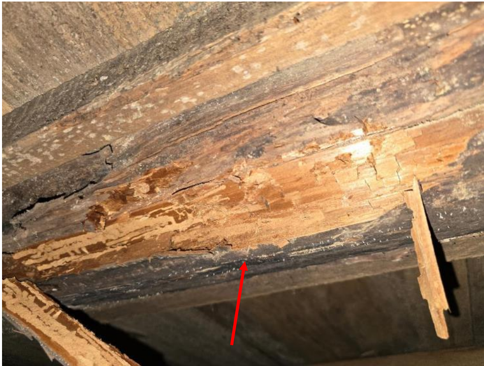
Kuva 103. Alapohjan runkokuissa havaittiin lahovaurioita ja hyönteisten tekemiä vaurioita.
