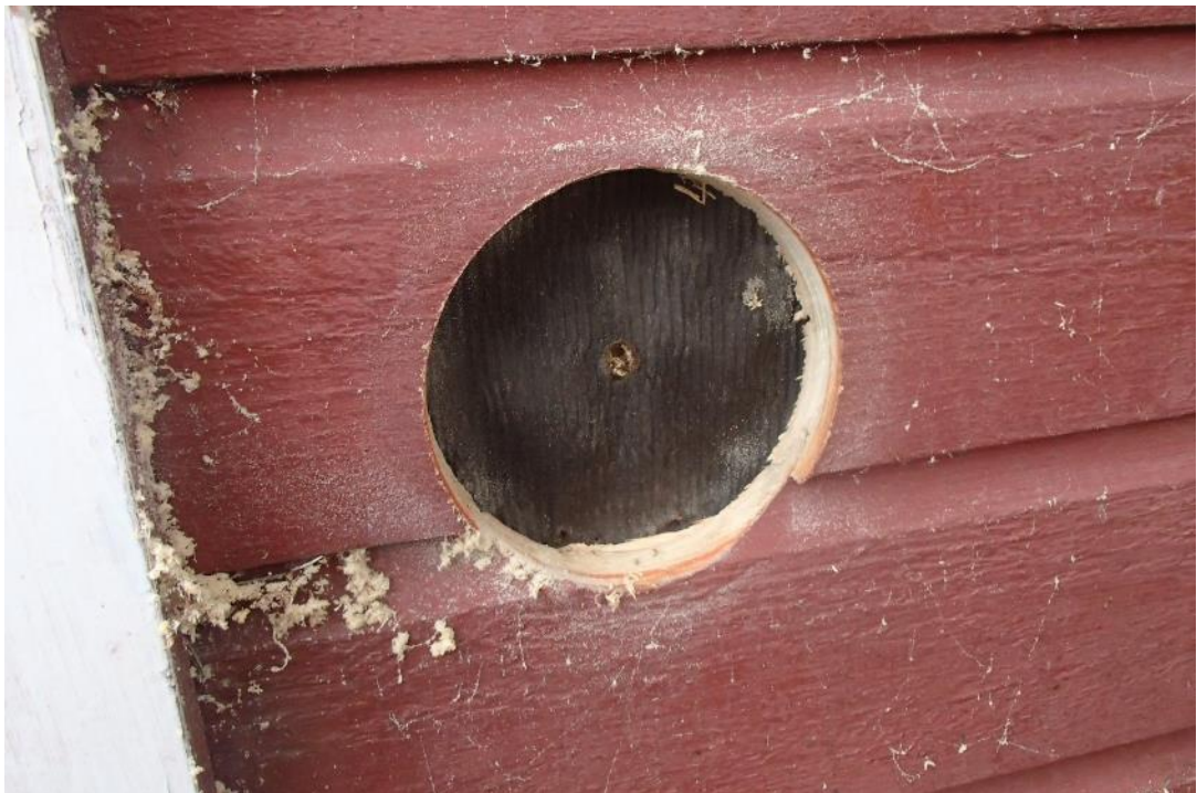
Kuva 30. Rakennuksen parkkipaikan puoleisella julkisivuilla paneelien taustalla havaittiin bituminen rakennuspaperi, mutta paneelien taustalla ei ole tuuletusväliä.
